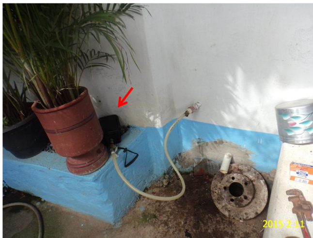
Foto 14 – Aparelho datalogger instalado no endereço localizado na Rua José Siqueira, nº 1.359 – Bairro de Fátima.
