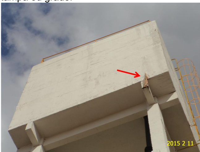
Foto 12 – REL-06: vazamento na laje de fundo.
