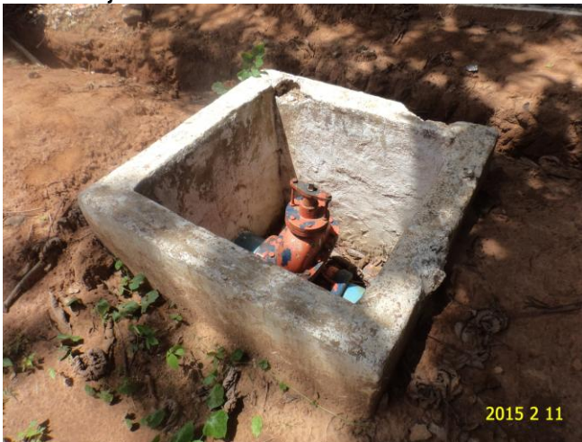
Foto 10 – RAP-06: caixa de inspeção sem tampa ou grade.
