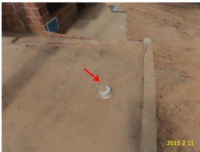
Foto 6 – Registro de descarga na Rua João Batista Leal sem caixa de inspeção e proteção.
