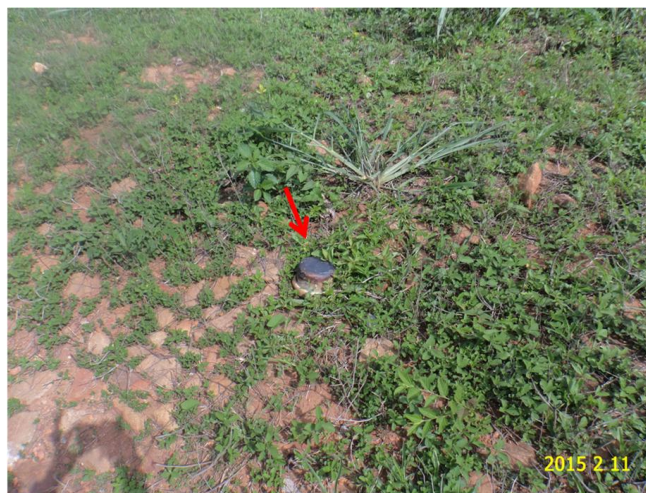
Foto 7 – Registro de descarga na Rua Projetada II sem caixa de inspeção e proteção.
