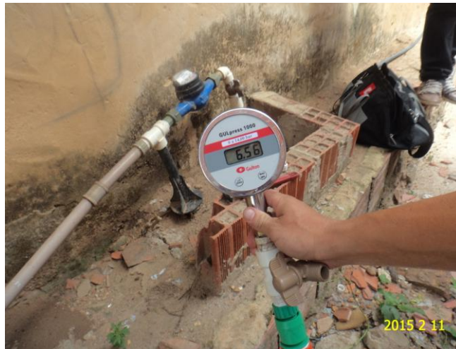
Foto 1 – Medição de pressão na Rua João Benício, nº 556 – Centro.
