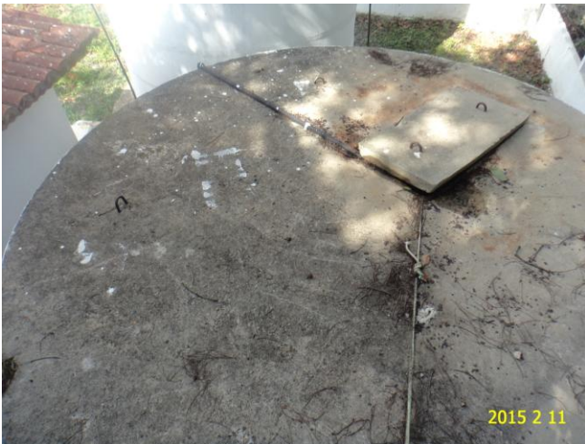
Foto 4 – RAP de Brejo Grande: ausência de tubulação de ventilação e tampa de inspeção sem vedação adequada.
