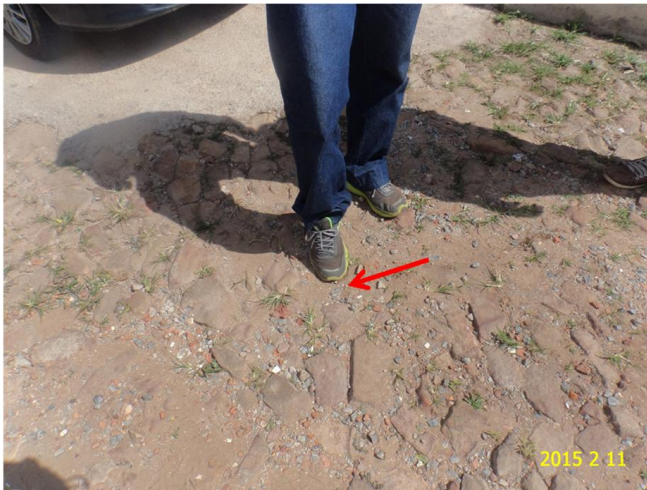
Foto 8 – Local do registro de descarga na Rua Projetada IV soterrada.
