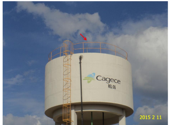
Foto 5 – REL-32 (identificado como REL-05): falta sinalização de obstáculo.
