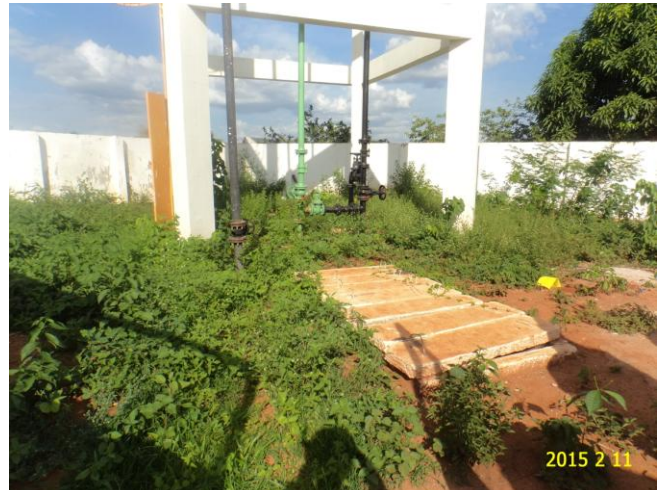
Foto 9 – REL-32: condições de limpeza e conservação inadequadas.
