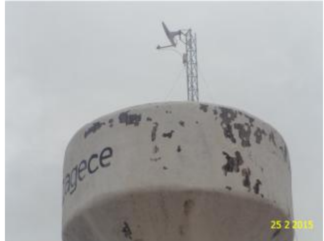
Foto 4 – REL-01: ausência de para-raios e sinalização noturna.
