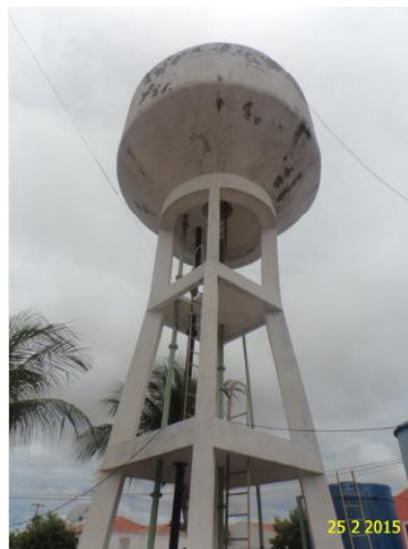
Foto 6 – REL-01: pintura deteriorada.
