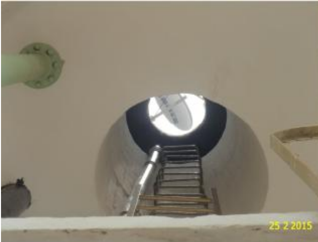
Foto 3 – REL-01: ausência de tampa de inspeção.
