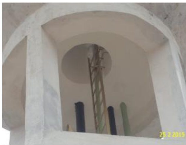
Foto 7 – REL-01: terceiro nível de escada fixado inadequadamente.
