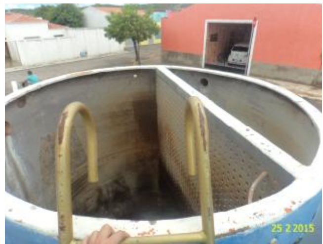
Foto 2 – Reservatório (antigo filtro): ausência de tampa.
