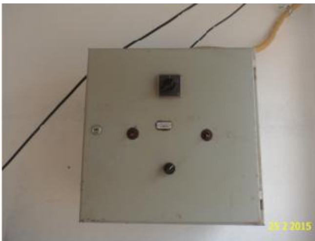
Foto 1 – EEAT-01: ausência de horímetro e identificação.
