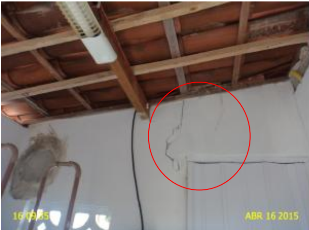
Foto 9 – ETE: casa de apoio ao operador com parede deteriorada.
