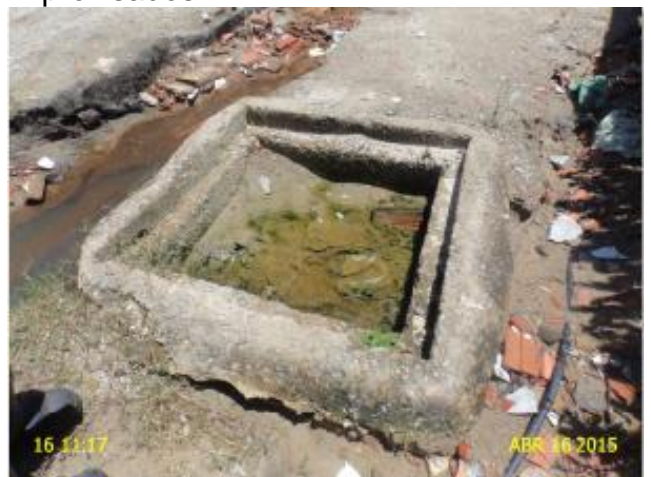
Foto 14 – RDA: registro de descarga com caixa deteriorada na Rua Cristiano Moreira Cavalcante.
