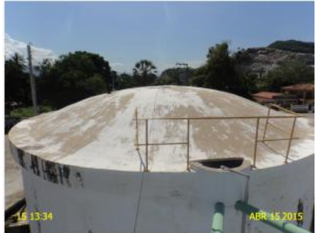
Foto 2 – RAP-01: ausência de tampa.
