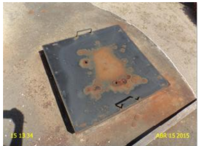
Foto 8 – Filtro-01: tampa em processo de corrosão e sem vedação adequada.
