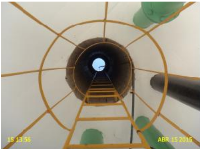
Foto 3 – REL-01: ausência de tampa.
