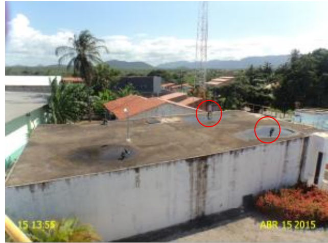
Foto 16 – RAP-02: tubulações de ventilação sem tela de proteção e pintura deteriorada.
