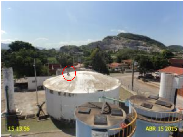
Foto 15 – RAP-01: tubulação de ventilação sem tela de proteção e pintura deteriorada.
