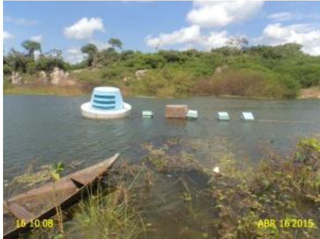
Foto 18 – Açude Riachão: ausência de sinalização de área destinada à captação de água para abastecimento público.
