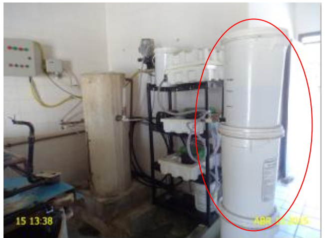
Foto 12 – ETA: tanques de dosagem improvisados.
