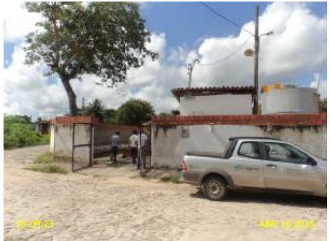
Foto 10 – ETE: ausência de identificação.
