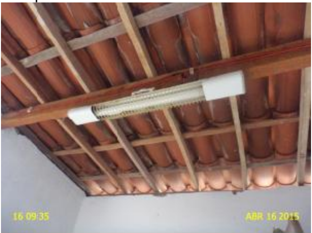
Foto 11 – ETE: casa de apoio ao operador sem iluminação.
