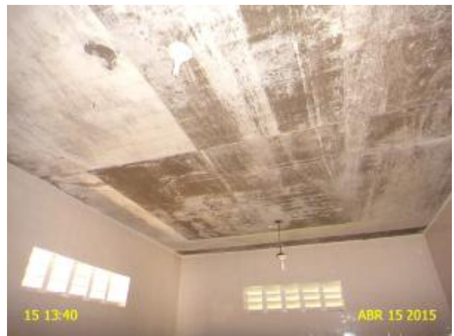
Foto 6 – EEAT-01: ausência de iluminação.
