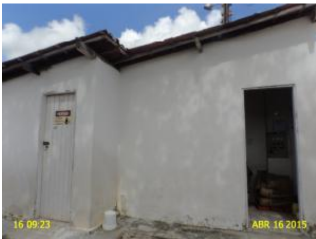
Foto 7 – EEE: ausência de identificação.
