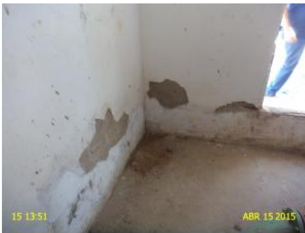
Foto 5 – EEAT-02: parede deteriorada.
