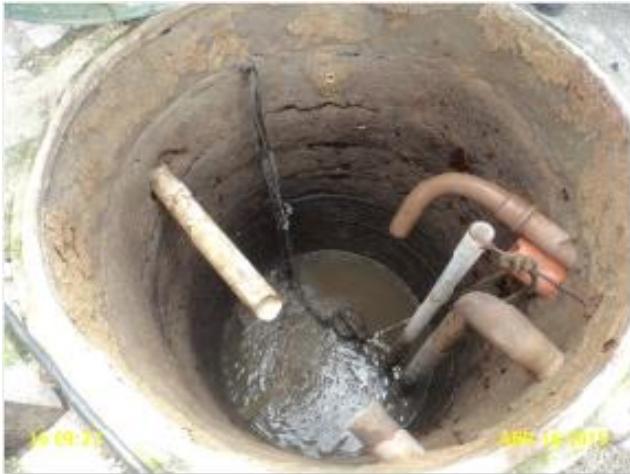
Foto 1 – EEE: sem bomba reserva.
