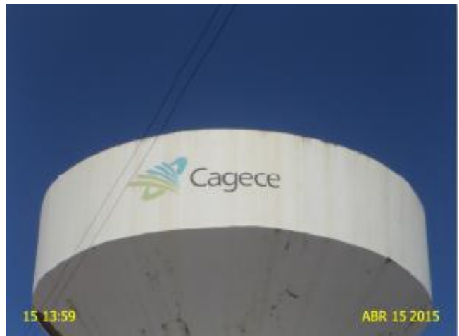
Foto 4 – REL-01: ausência de para-raios e sinalização noturna.
