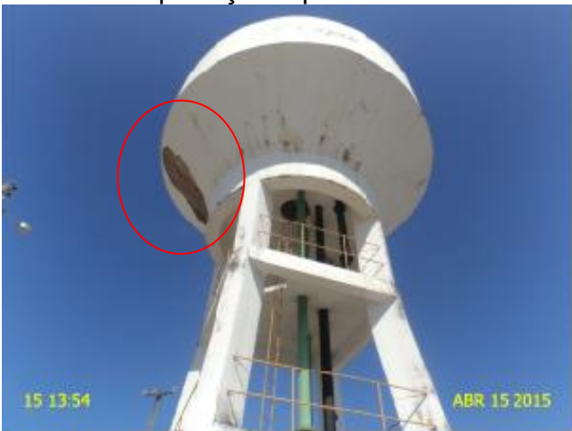
Foto 17 – REL-01: estrutura deteriorada.
