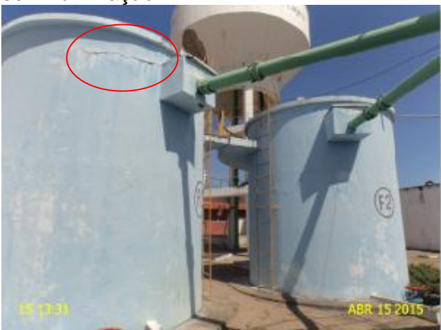
Foto 13 – Filtro 01: estrutura deteriorada.
