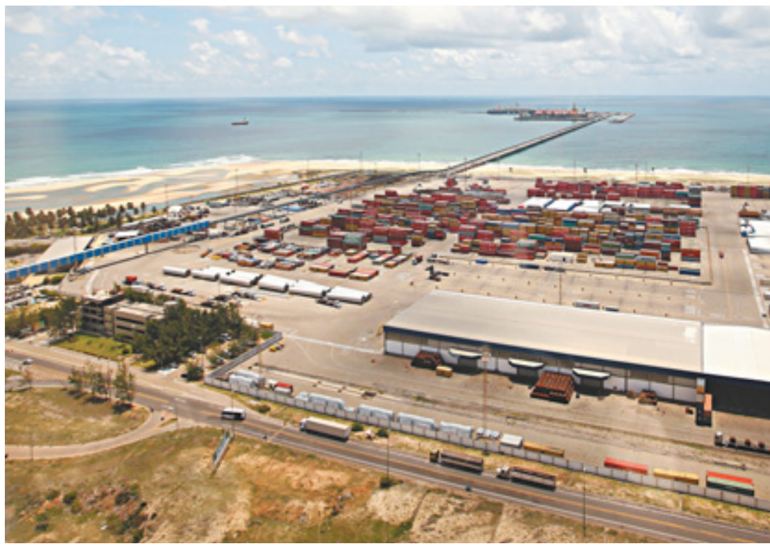
O esgoto gerado pelos prédios da empresa, administradora do Porto do Pecém, é hoje captado e levado a uma estação de tratamento, na qual a água é filtrada e usada para abastecer as bacias sanitárias e os jardins da companhia. FOTO: MARILIA CAMELO
