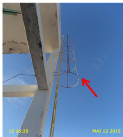
**Foto 22** – REL-01: guarda-corpo em processo de corrosão.
