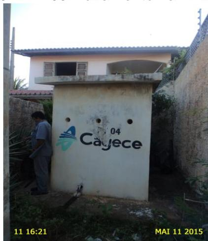
**Foto 12** – PT-04: casa de abrigo do QC com pintura deteriorada.
