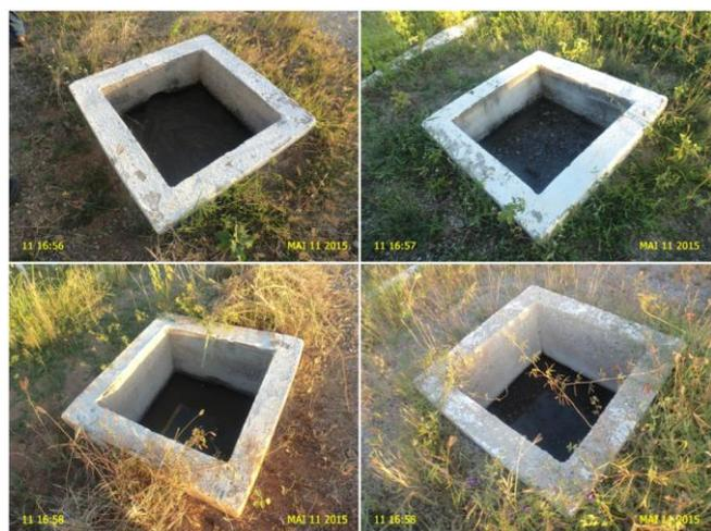
**Foto 19** – ETE: caixas de passagem sem tampa ou grade de proteção.
