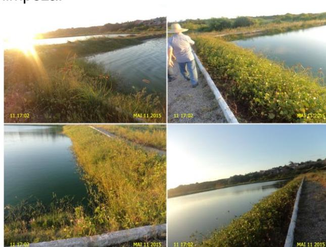
**Foto 20** – ETE: lagoa facultativa sem placa de proteção dos taludes e com presença de vegetação.
