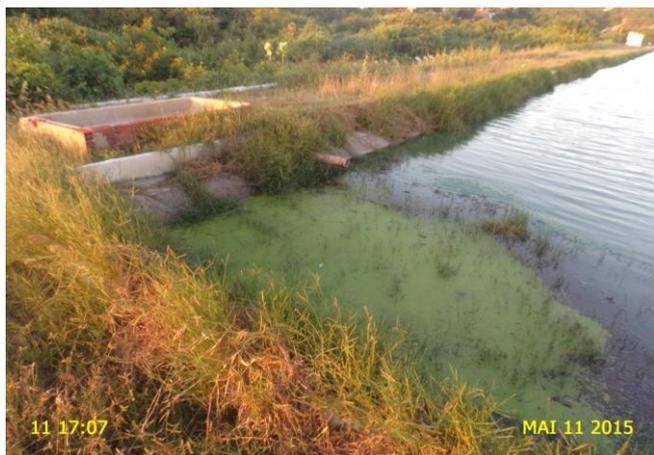
**Foto 21** – ETE: lagoa de maturação sem placas de proteção dos taludes, presença de sobrenadantes e de vegetação .
