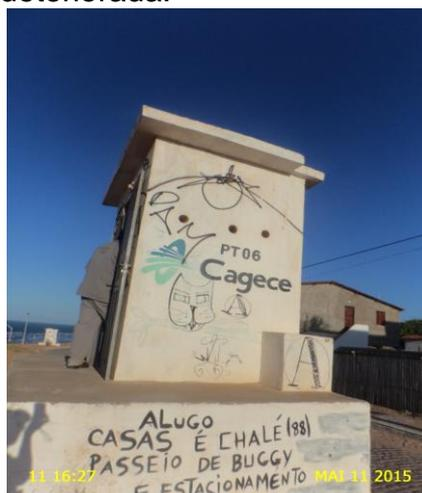
**Foto 14** – PT-06: casa de abrigo do QC com pintura deteriorada.
