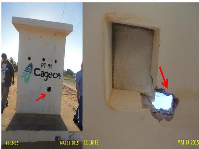
**Foto 11** – PT-01: casa de abrigo do QC com estrutura danificada e pintura deteriorada.
