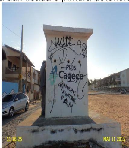
**Foto 13** – PT-05: casa de abrigo do QC com pintura deteriorada.
