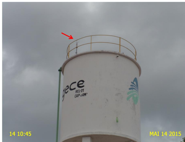
Foto 2 – REL-01: ausência de sinalizador noturno.
