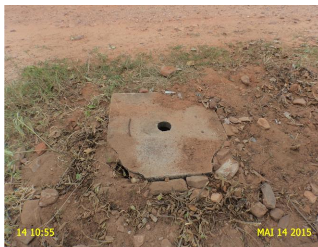
Foto 4 – RDA: registro de descarga com caixa danificada localizado na Rua do Grupo.
