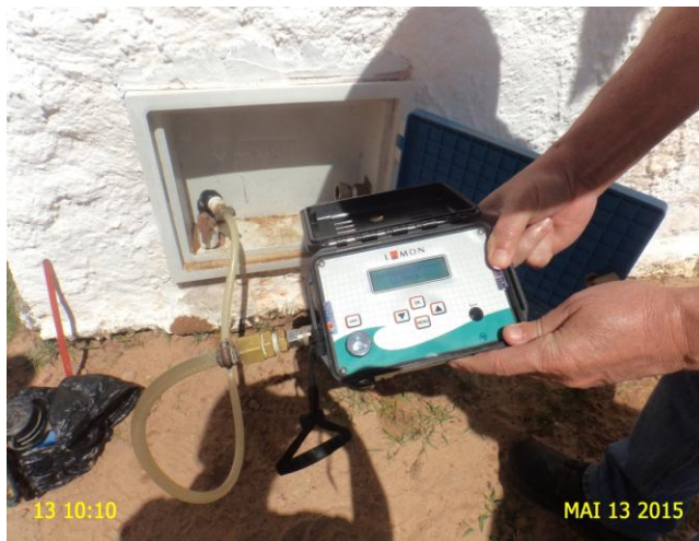
Foto 1 – Aparelho datalogger instalado no endereço localizado na Rua São Paulo (Igreja).
