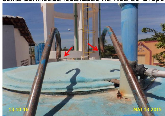
Foto 6 – RAP-01: escada de acesso em processo de corrosão e sem fixação.
