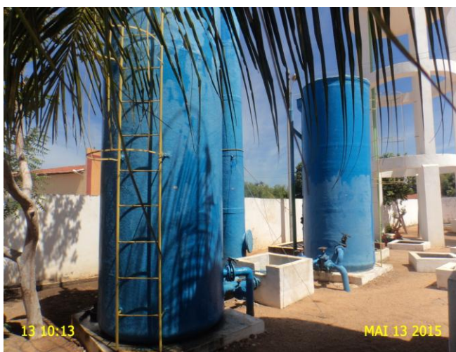
Foto 3 – ETA: os filtros não são dotados de identificação.
