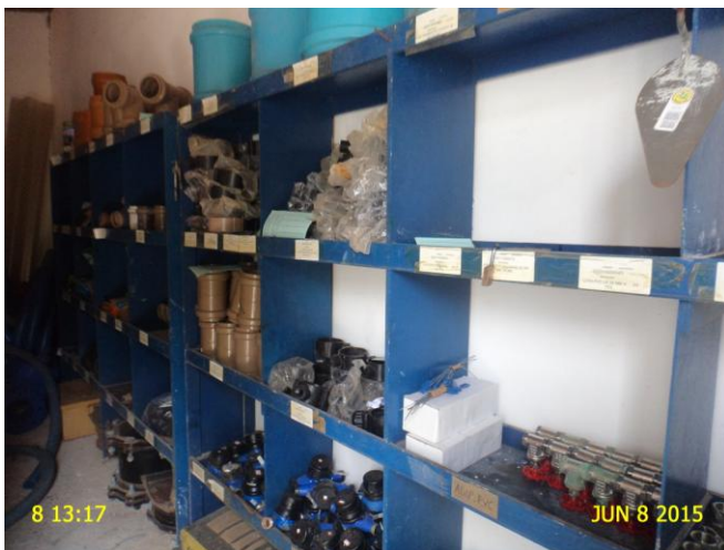
Foto 4 - Almojarifado: ausência de extintor de incêndio.
