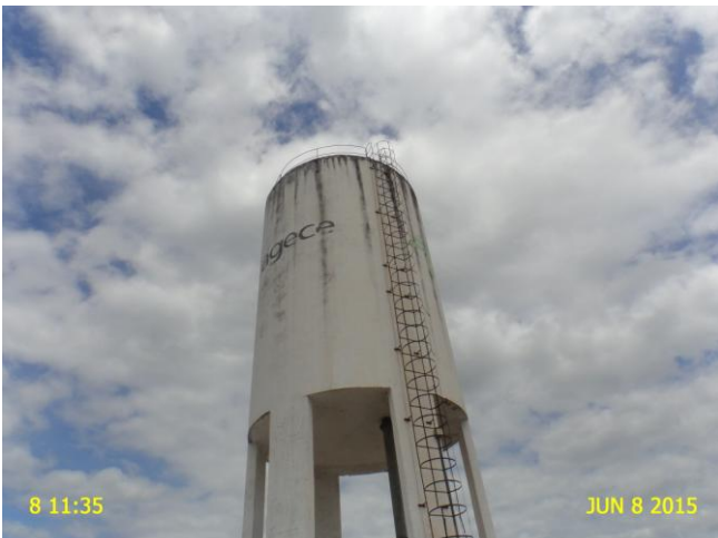
Foto 28 - REL-01: guarda corpo e escada em corrosão, pintura deteriorada e sem identificação.
