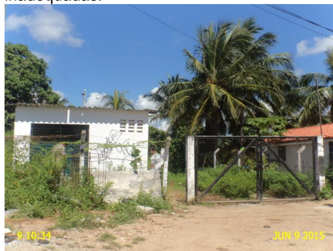
Foto 13 - EEE-02: sem identificação e cerca de delimitação danificada.
