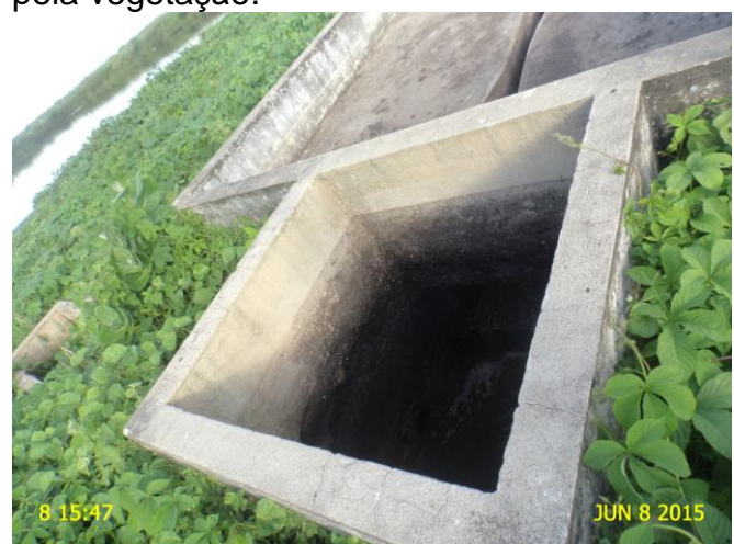
Foto 19 - ETE: caixa de inspeção sem tampa ou grade de proteção.
