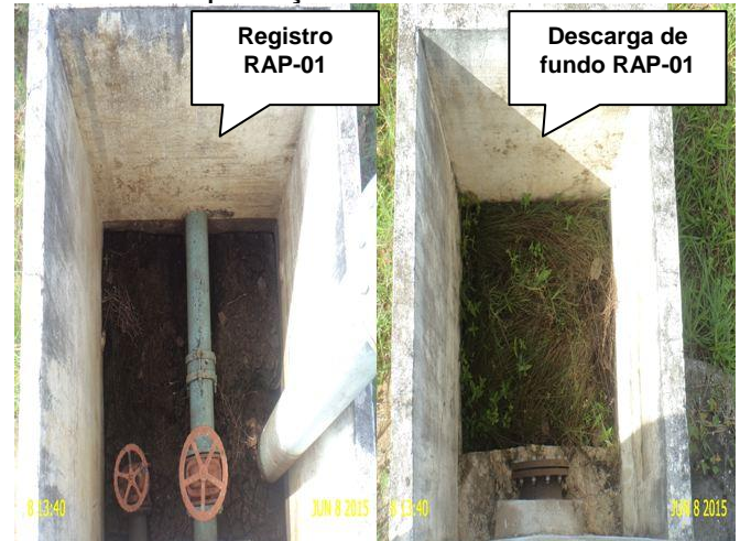
Foto 25 - RAP-01: caixas de inspeção sem tampa ou grade de proteção.
