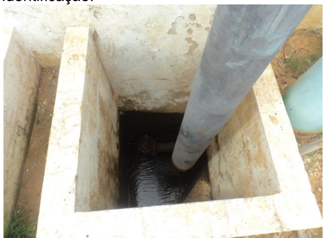
Foto 31 - RSE-01: vazamento no registro de descarga de fundo.
