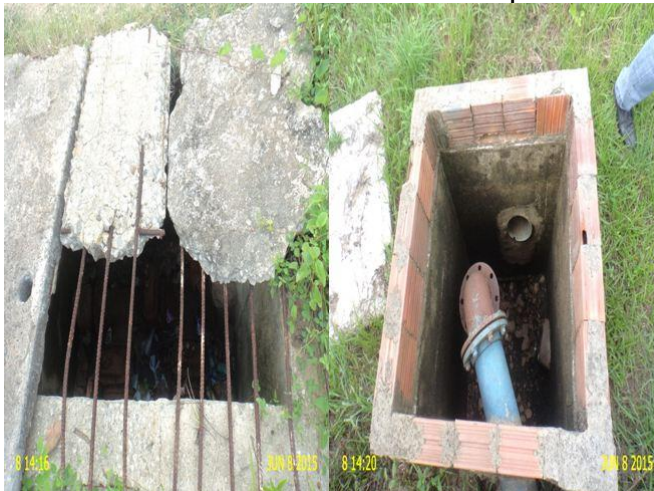
Foto 24 - REL-02 (Umarituba): caixas dos registros de descarga e da descarga de fundo com tampas danificadas e descobertas.
