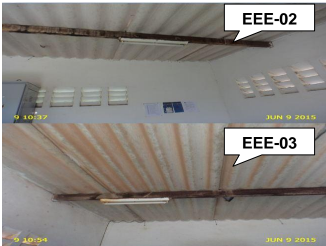
Foto 16 - EEE-02 e EEE-03: iluminação com defeito.
