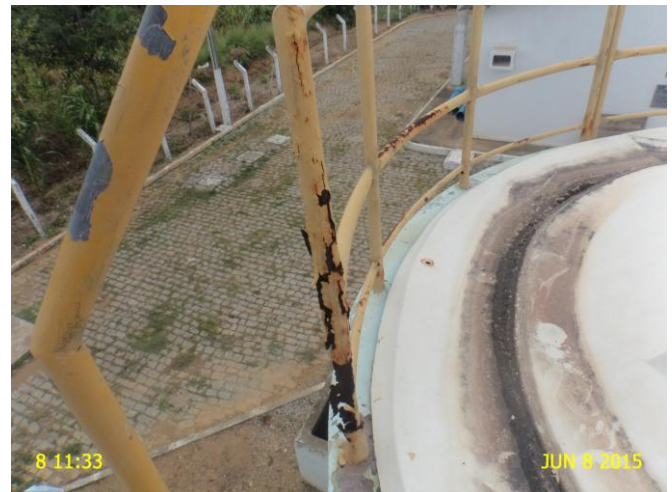
Foto 7 - Filtros: guarda-corpo em processo de corrosão.
