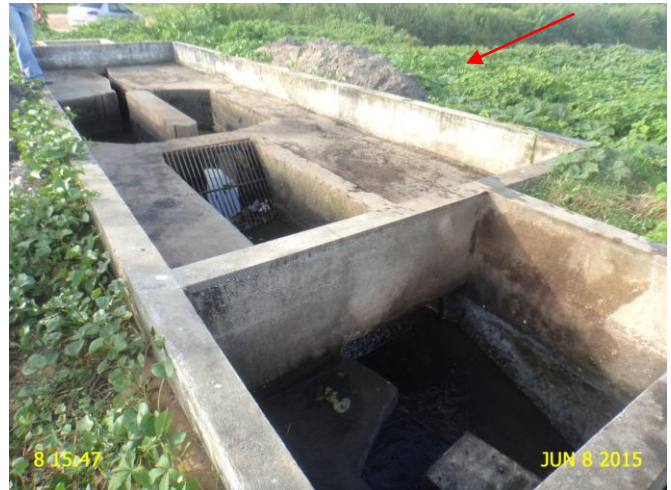
Foto 2 - ETE: ausência de leitos de secagem.
