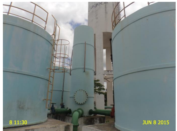
Foto 5 – Filtros F-01, F-02, F-03: pintura deteriorada no filtro e nas escadas.
