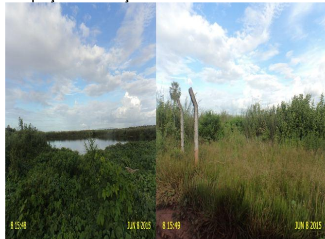
Foto 17 - ETE: lagoas LF (2), LF (3), LM (1), LM (2) e LM (3) sem acesso/ área tomada pela vegetação.
