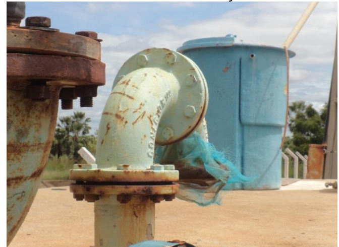
Foto 23 - REN-01: tubulação de ventilação com tela de proteção danificada.
