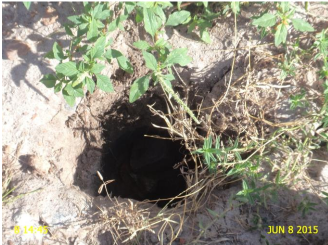
Foto 22 - RDA: Registro de Descarga sem caixa na Rua Estevão Rafael Procópio.
