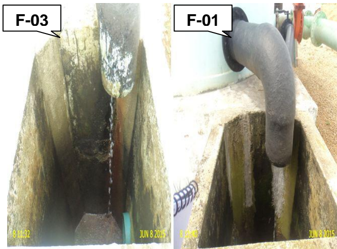
Foto 8 - F-01 e F-03: vazamento no registro.
