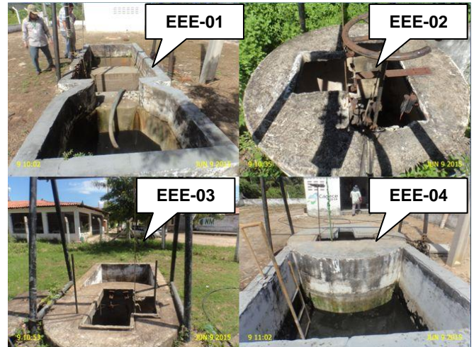
Foto 15 - EEE-01, EEE-02, EEE-03 e EEE-04: poços de sucção descobertos.
