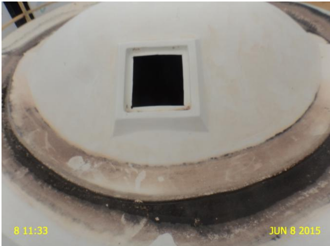
Foto 1 - F-02: sem tampa de inspeção e acúmulo de água na cobertura.
