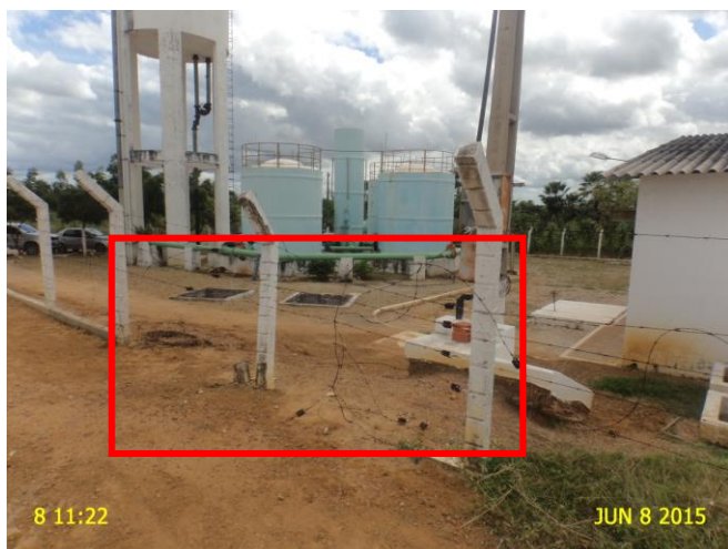
Foto 10 - ETA: cerca de delimitação danificada.
