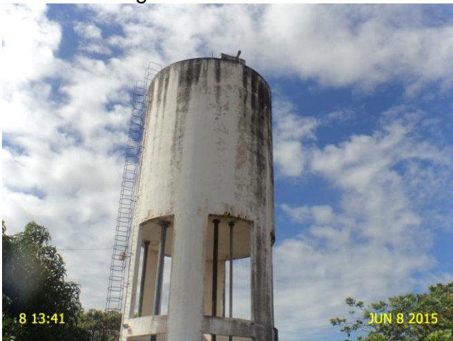
Foto 3 - REL -03 (São Gonçalo do Amarante): ausência de identificação, pintura deteriorada e ausência de guarda-corpo na laje de cobertura.
