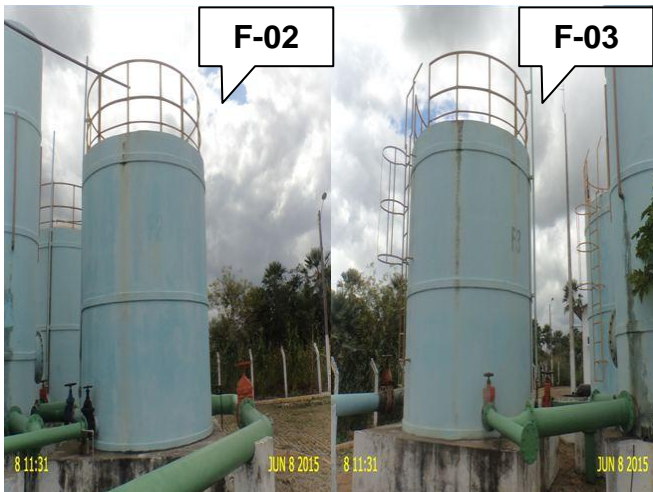
Foto 6 – Filtros F-02 e F-03: identificação pouco visível.
