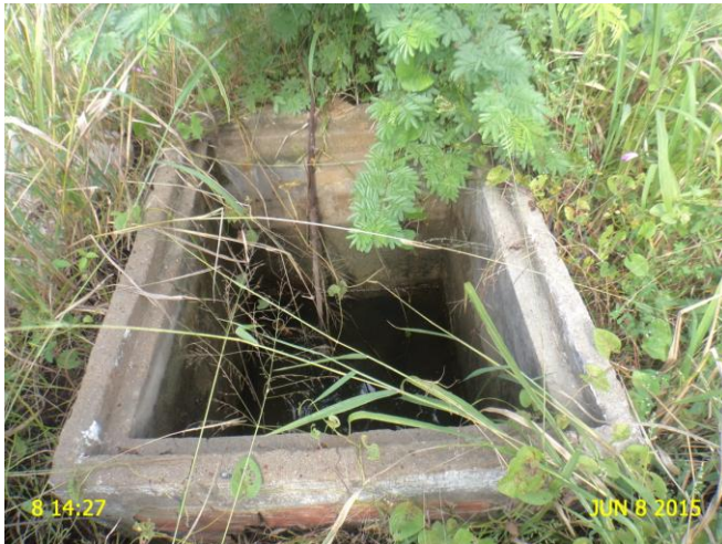
Foto 32 - AAT: registro de descarga sem tampa e com vazamento.
