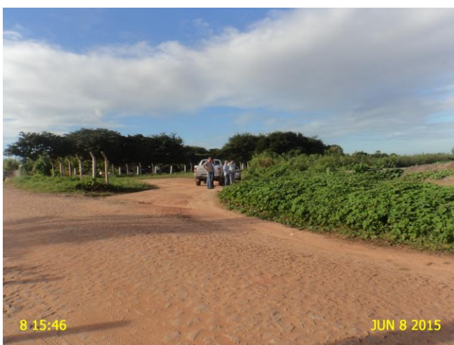
Foto 18 - ETE: ausência de identificação e cerca de delimitação danificada.
