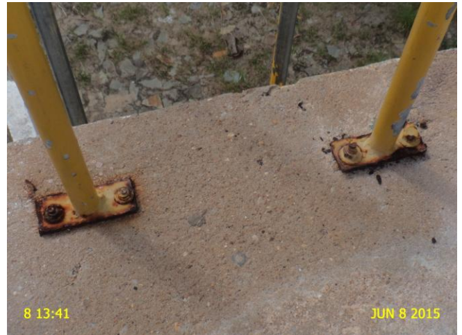
Foto 27 - RAP-01: escada sem fixação na estrutura do reservatório.
