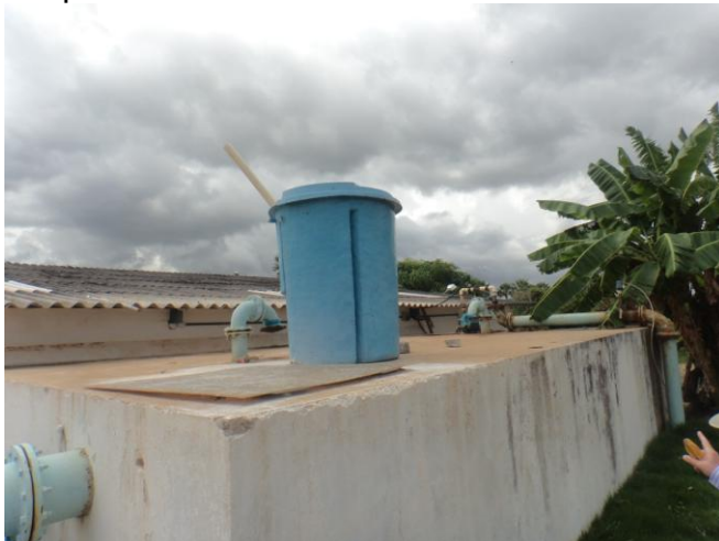
Foto 34 - RSE-01: tampa de inspeção sem vedação.
