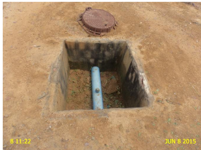
Foto 9 - ETA: caixa do medidor proporcional sem tampa ou grade de proteção.
