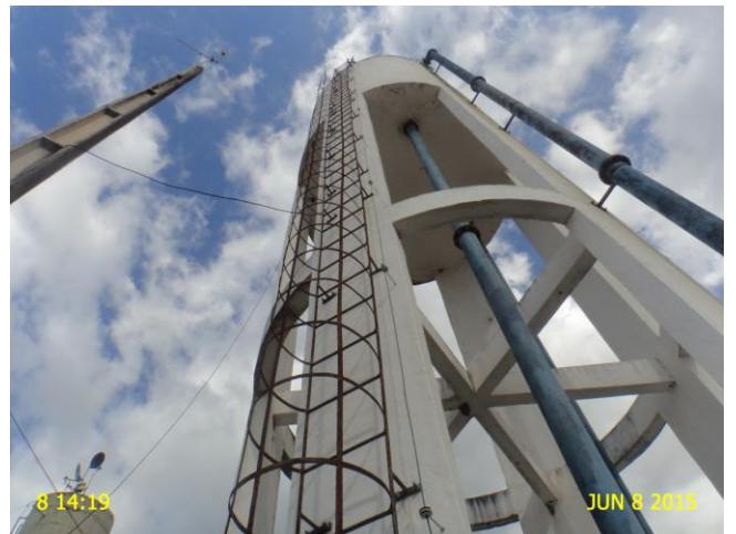
Foto 29 - REL-02: guarda corpo e escada em corrosão, pintura deteriorada e sem identificação.
