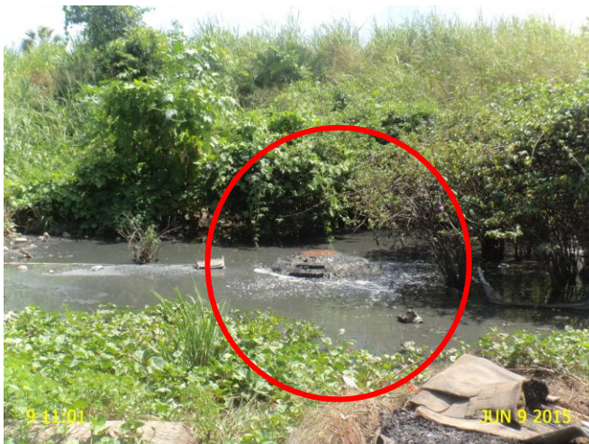
Foto 20 - RCE: extravasamento de esgoto no PV ao lado da EEE-04.
