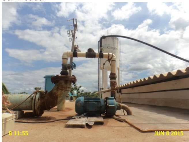
Foto 12 - EEAT-03 (Catuana): sem proteção adequada.
