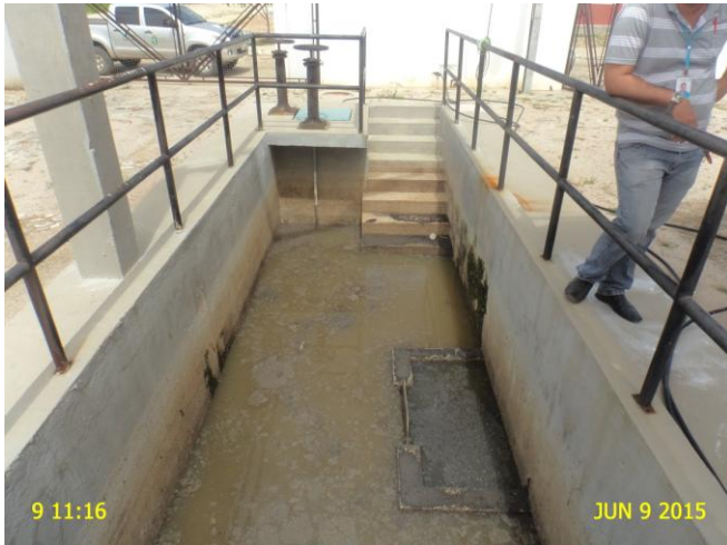
Foto 14 - EEE-05: gradeamento submerso.
