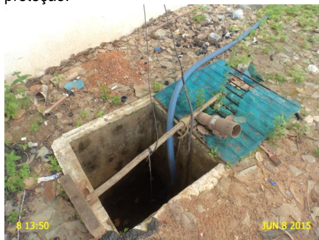
Foto 11 - EEAT-04: instalações elétricas inadequadas.
