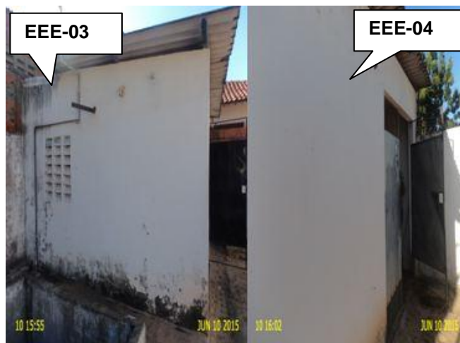
Foto 20 - EEE-03 e EEE-04: ausência de identificação.
