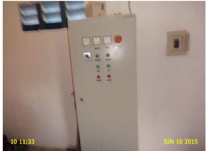
Foto 2 - EEAT-02: Quadro de Comando sem horímetro.
