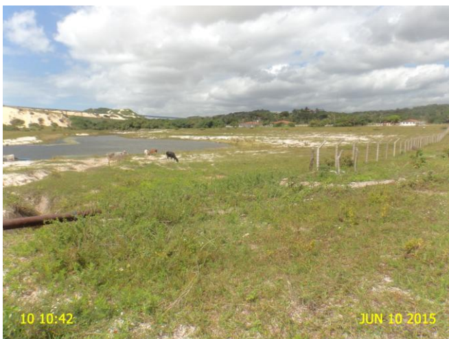
Foto 46 - Captação superficial: ausência de sinalização.
