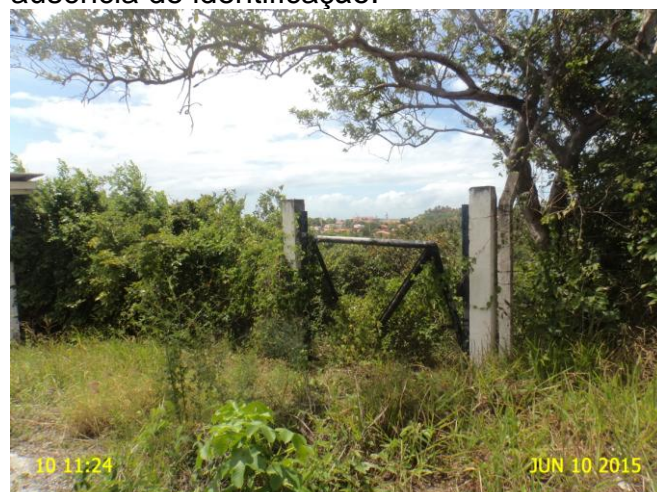
Foto 42 - RAP-02 e RAP-03: cerca e portão de delimitação danificados na área dos reservatórios.
