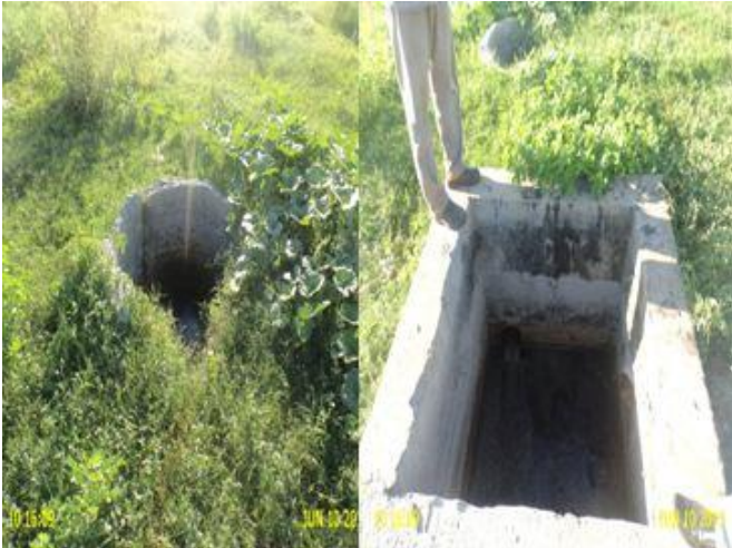
Foto 25 - ETE: caixas de recepção e chegada de esgoto bruto sem tampas.
