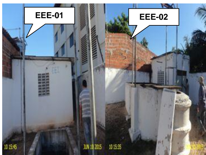
Foto 21 - EEE-01 e EEE-02: identificação pouco visível.
