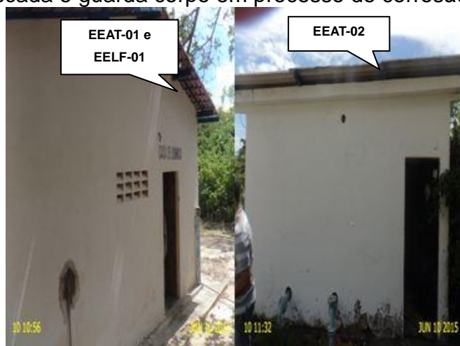
Foto 16 - EEAT-01, EELF-01 e EELF-02: ausência de identificação.
