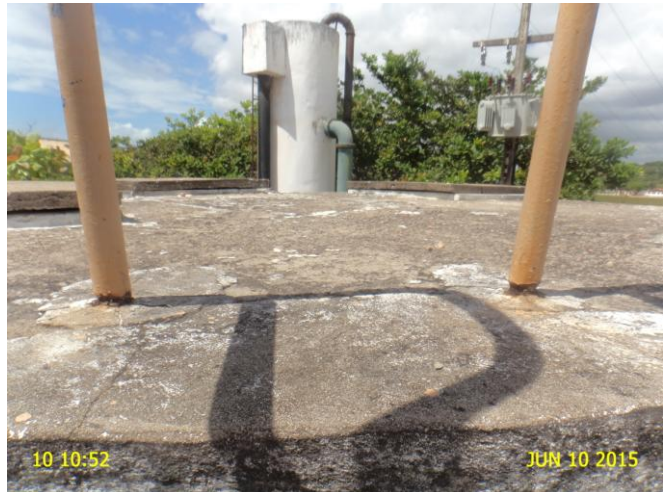
Foto 8 - F-01: escada sem fixação na estrutura do filtro.
