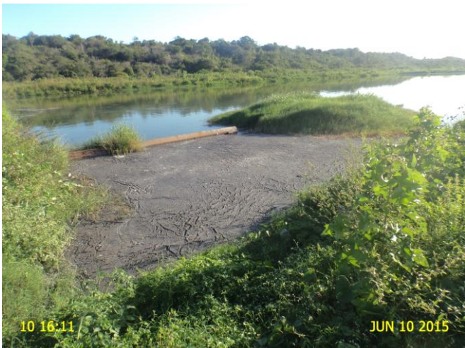
Foto 29 - ETE: acúmulo de sobrenadantes na LF (1).
