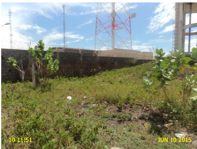
Foto 5 - REL-01: área sem cerca ou muro de delimitação.
