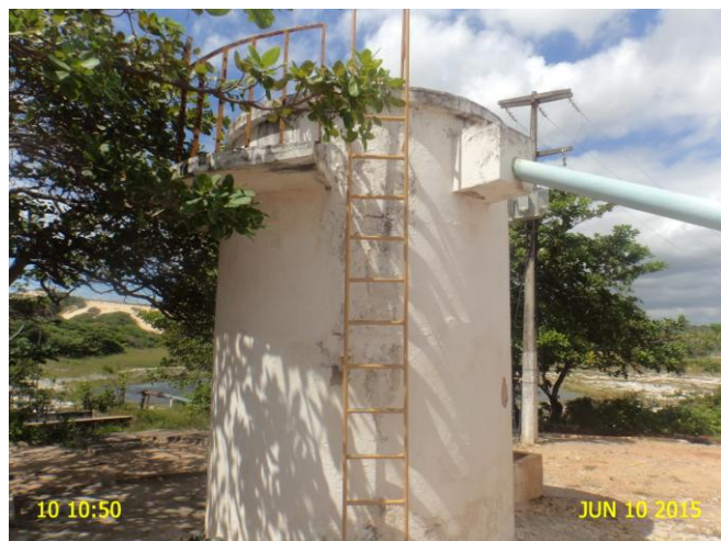
Foto 14 - Torre de Nível: pintura deteriorada, escada e guarda corpo em processo de corrosão.
