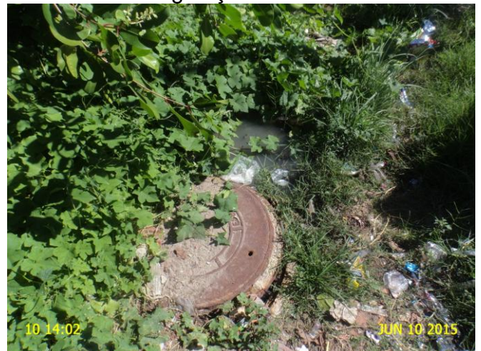
Foto 30 - RCE: PV Rua Laureano Sampaio - extravasamento.
