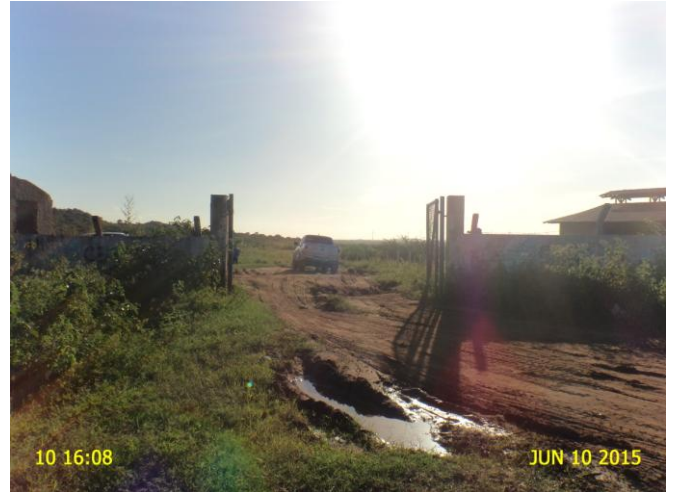
Foto 26 - ETE: ausência de identificação.
