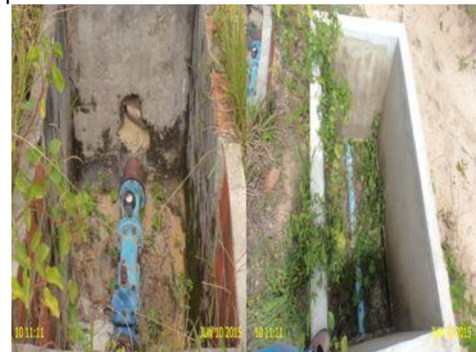
Foto 12 - ETA: caixas sem tampa ou caixa de proteção.
