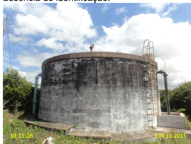
Foto 40 - RAP-03: pintura deteriorada e ausência de identificação.
