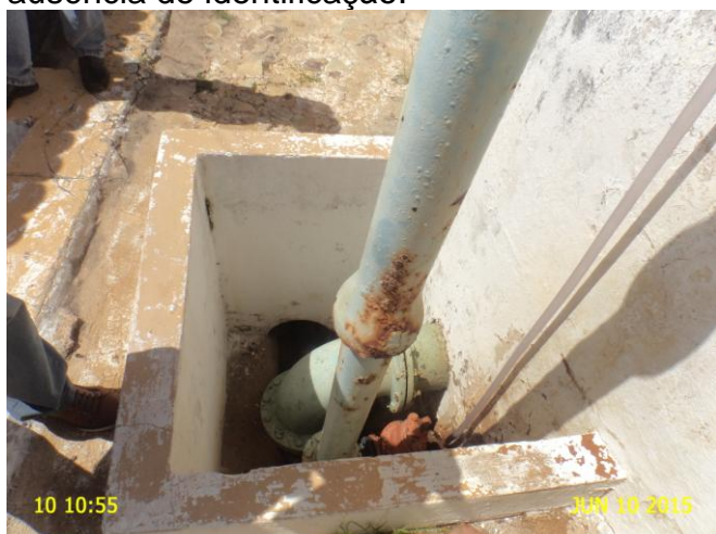
Foto 41 - RAP-01: tubo extravasor em processo de corrosão.
