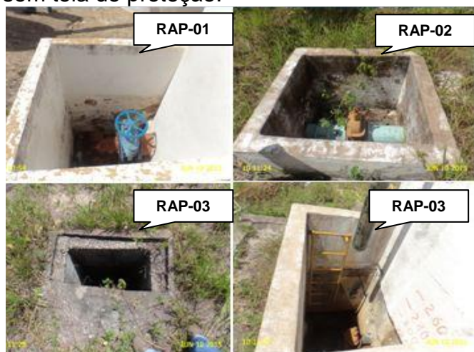
Foto 35 - RAP-01, RAP-02 e RAP-03: caixas de inspeção sem tampas ou grades.
