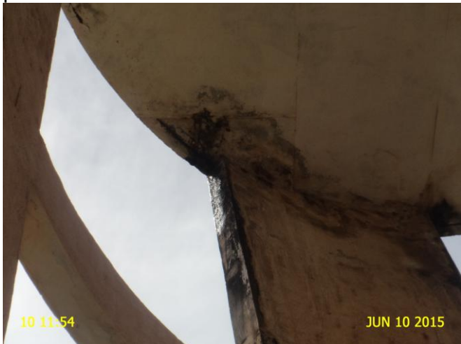
Foto 45 - REL-01: sinais de vazamento.
