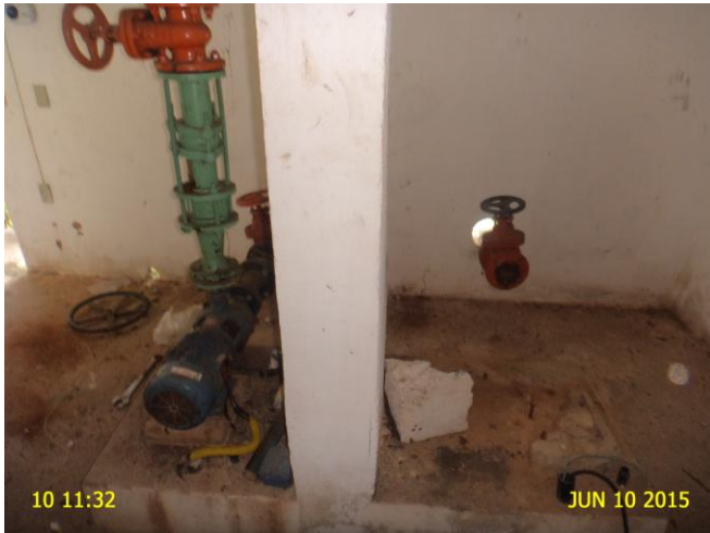
Foto 1 - EEAT-02: ausência de bomba reserva.
