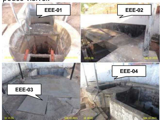
Foto 23 - EEE-01, EEE-02, EEE-03 e EEE-04: poços de sucção descobertos.
