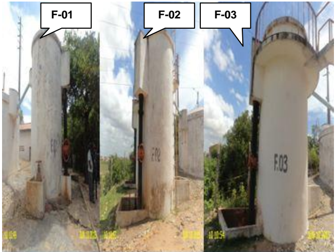
Foto 9 - F-01, F-02 e F-03: pintura deteriorada.
