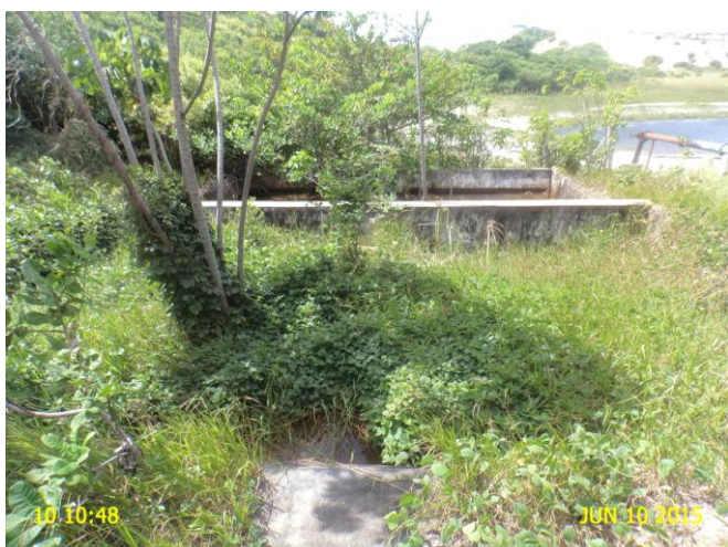
Foto 15 - ETA: os leitos de secagem estão desativados.
