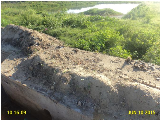
Foto 3 - ETE: ausência de leitos de secagem.
