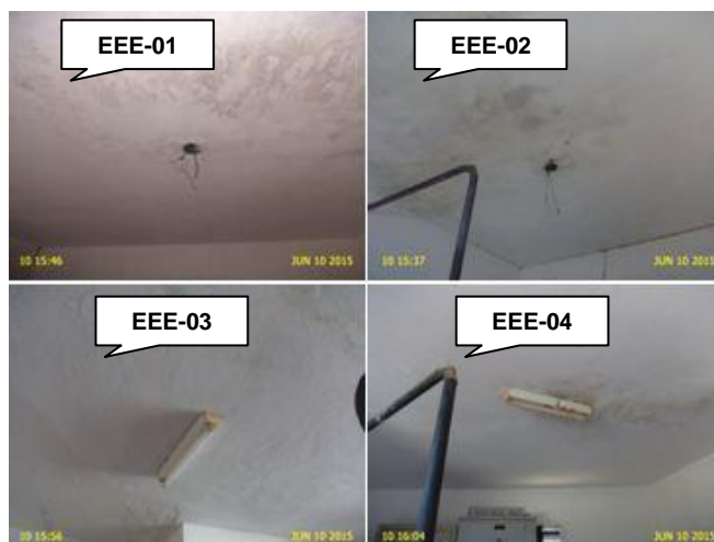
Foto 24 - EEE-01, EEE-02, EEE-03 e EEE-04: iluminação com defeito.
