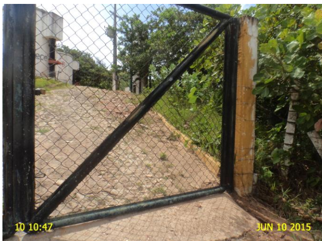
Foto 13 - ETA: portão danificado.
