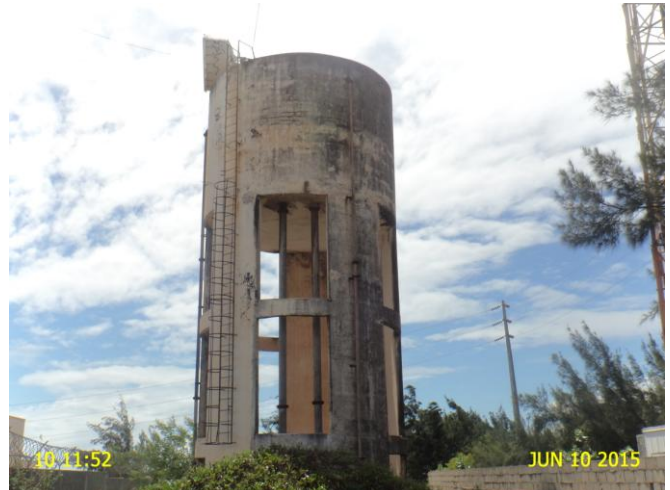
Foto 4 - REL-01: pintura deteriorada, sem identificação, escada em corrosão, ausência de guarda-corpo.
