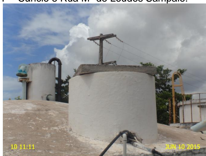
Foto 34 - RAP-01: tampa de inspeção sem vedação.
