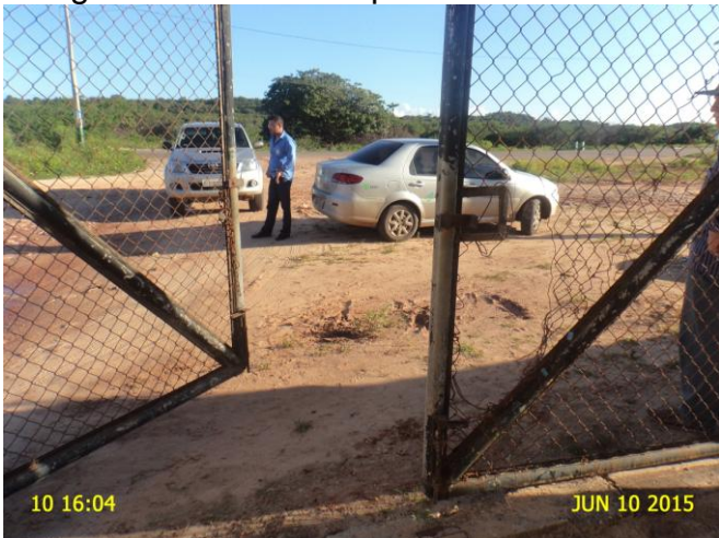
Foto 27 - ETE: portão danificado.
