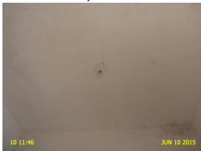
Foto 18 - EERD-01: iluminação com defeito.
