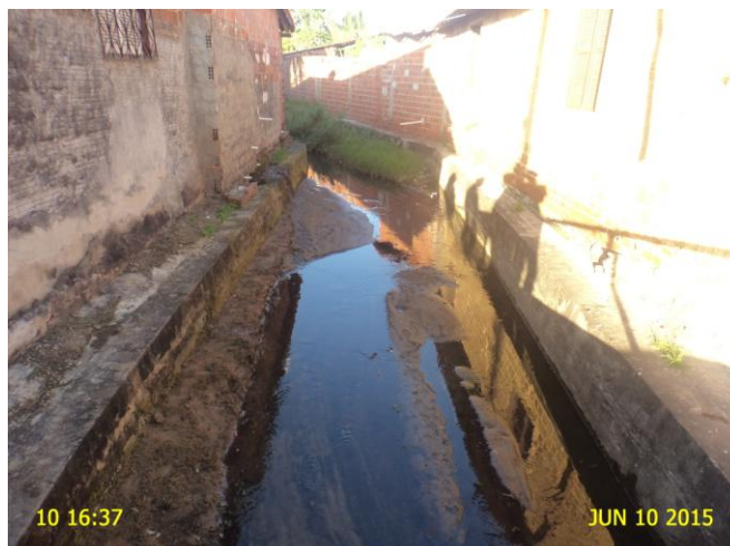
Foto 48 - Rua Pescador José Venâncio: Lançamento de esgoto à céu aberto.
