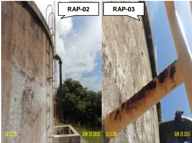
Foto 43 - RAP-02 e RAP-03: escadas em processo de corrosão.
