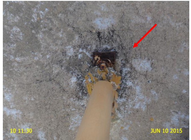
Foto 44 - RAP-03: escada sem fixação na estrutura do reservatório.
