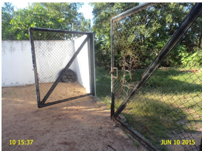
Foto 19 - EEE-02: portão danificado.
