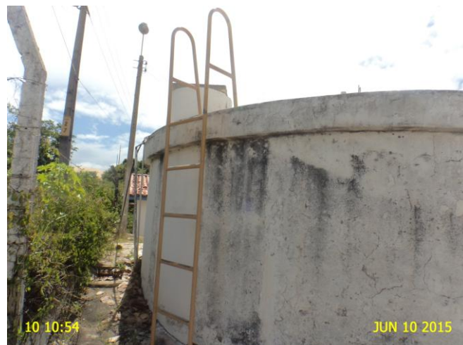
Foto 38 - RAP-01: pintura deteriorada e ausência de identificação.
