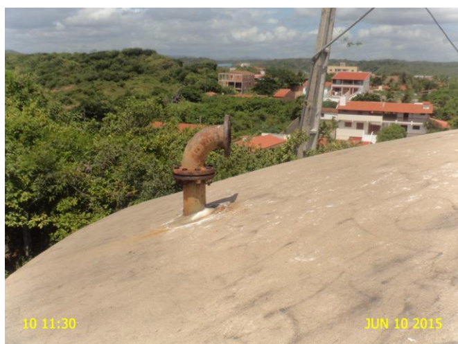
Foto 33 - RAP-03: tubulação de ventilação sem tela de proteção.
