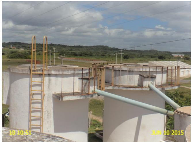
Foto 10 - F-02 e F-03: guarda corpo em processo de corrosão.
