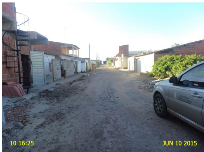
Foto 31 – RCE: Rua Nogueira Costa - área crítica de extravasamentos e obstruções.
