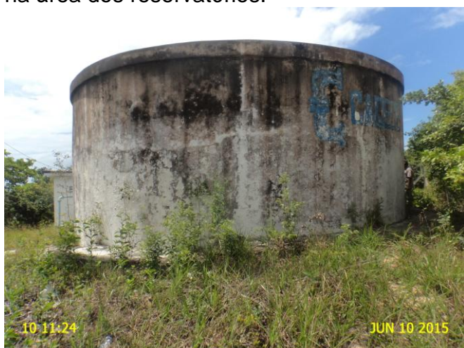
Foto 39 - RAP-02: pintura deteriorada e ausência de identificação.
