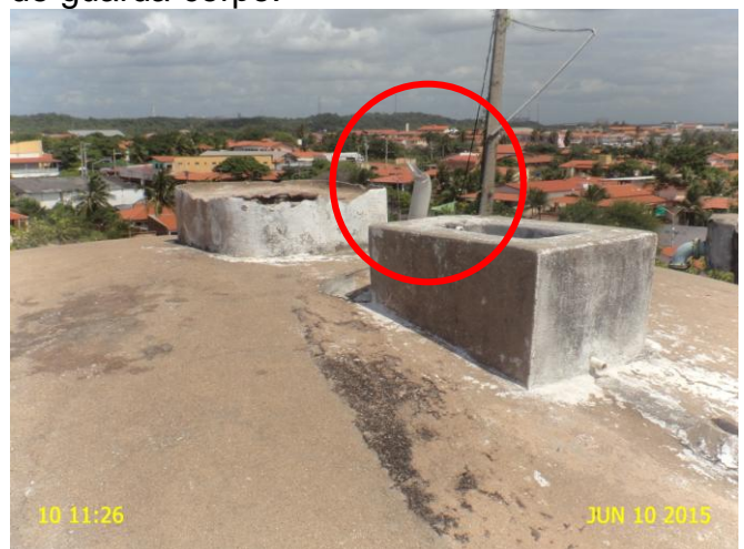
Foto 6 - RAP-02: tubulação de ventilação inadequada e ausência de tampa.
