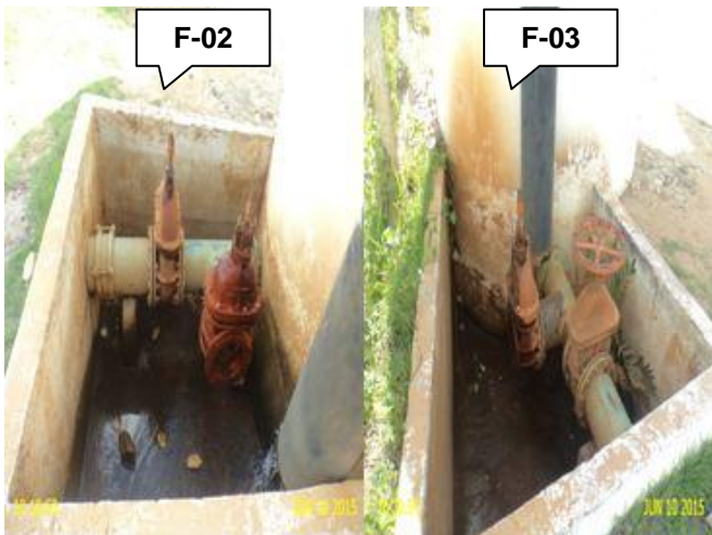
Foto 11 - F-02 e F-03: vazamento nos registros.
