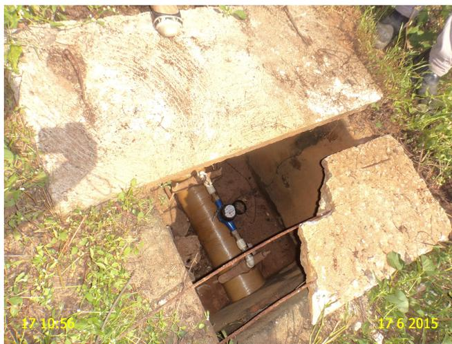
**Foto 4** – AAB: caixa de inspeção com tampa danificada.
