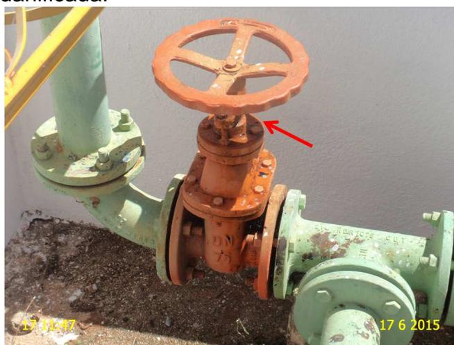
**Foto 6** – AAT: registro na saída do *Booster* com vazamento.
