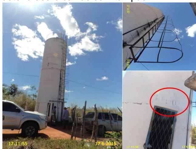
**Foto 13** – REL-02: identificação pouco visível, pintura deteriorada e escada de acesso com corrosão.
