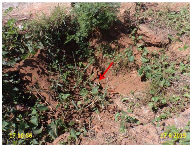
**Foto 5** – AAB: estação pitométrica sem caixa de inspeção.
