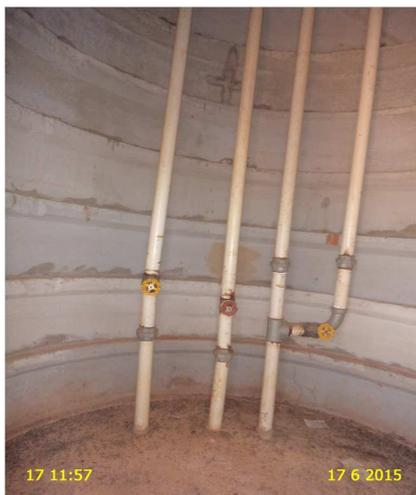
**Foto 3** – REL-02: sem medidor de nível.
