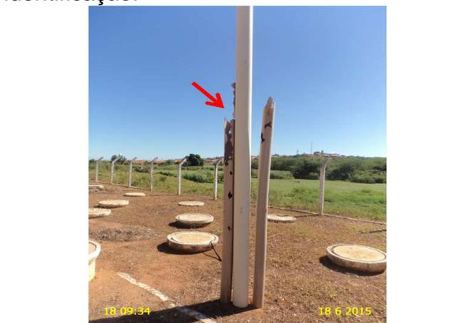
**Foto 9** – ETE-05: tubulação de ventilação deteriorada.
