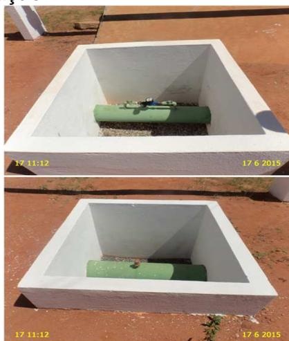
**Foto 12** – ETA: caixas de inspeções sem tampa ou grade de proteção.
