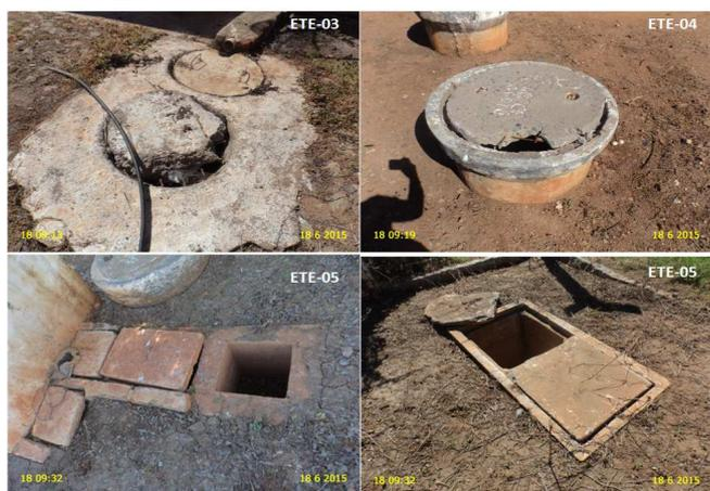
**Foto 8** – ETEs: decanto digestores com tampas danificadas e caixas de inspeções sem tampa.
