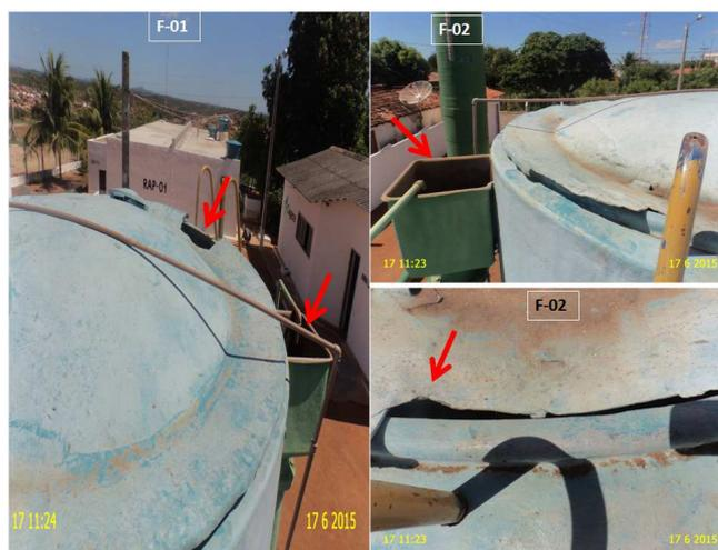
**Foto 11** – ETA: filtros F-01 e F-02 com tampa deteriorada e calhas sem tampas.
