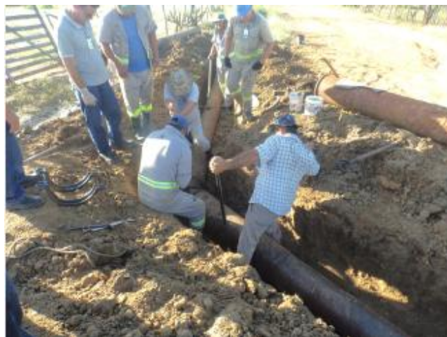
Foto 2 – Ocorrência operacional nº 0687/UNBAJ.
