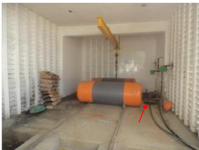
Foto 3 – Casa de química: bombas na área de dosagem do cloro gasoso.
