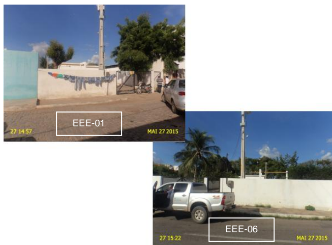
Foto 14 – EEE-01 e EEE-06: ausência de identificação.
