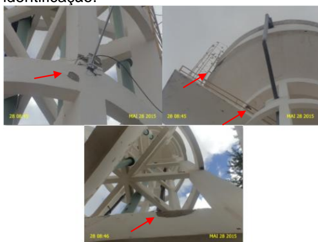
Foto 16 – REL-01: reboco deteriorado.
