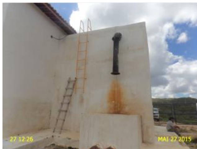
Foto 15 – RAP Arneiroz II: ausência de identificação.
