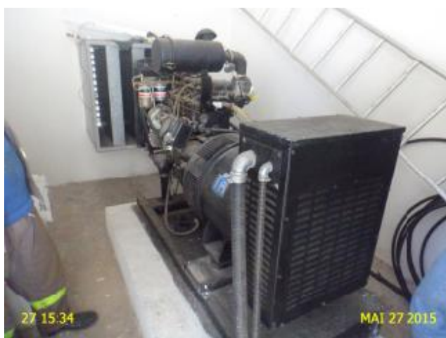
Foto 13 – EEE-01: grupo gerador de energia elétrica sem bateria.
