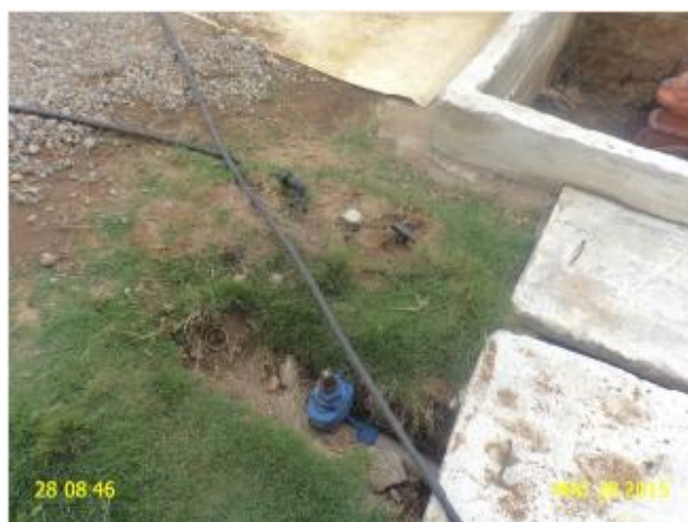
Foto 9 – ETA: registro e medidor sem caixa de inspeção.
