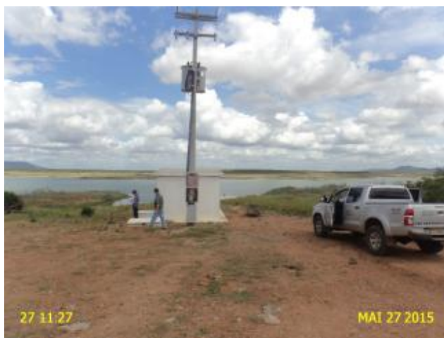
Foto 17 – Captação: ausência de sinalização identificadora.
