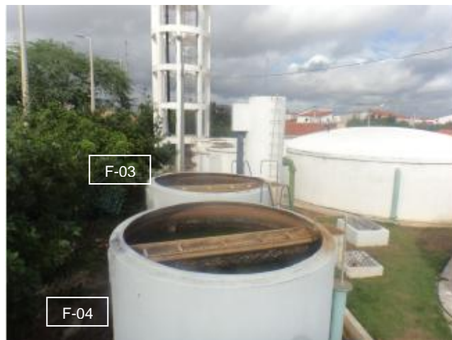
Foto 6 – Filtros F-03 e F-4: ausência de tampas.
