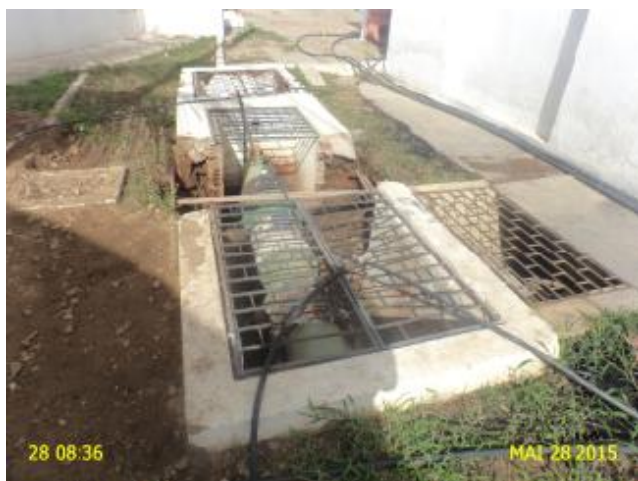
Foto 8 – AAT: caixa de inspeção deteriorada.
