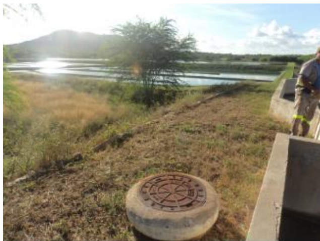
Foto 5 – ETE: ausência de iluminação.
