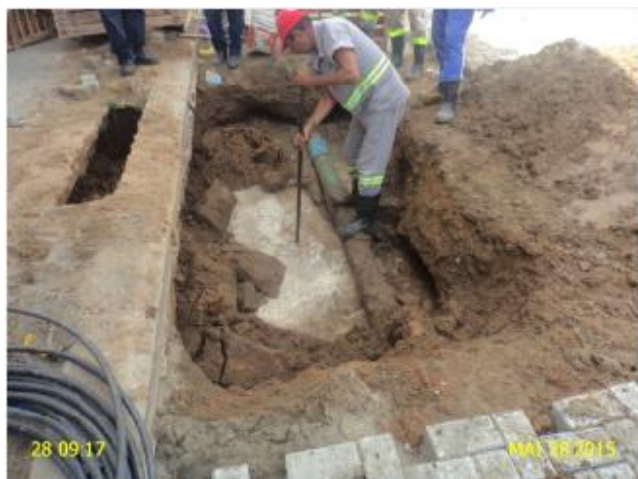
Foto 1 – Ocorrência operacional nº 0686/UNBAJ.
