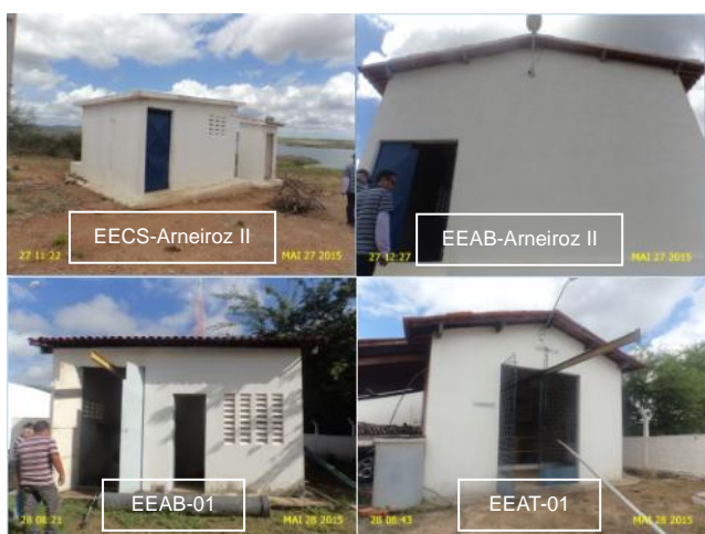
Foto 10 – Elevatórias de água: ausência de identificação.
