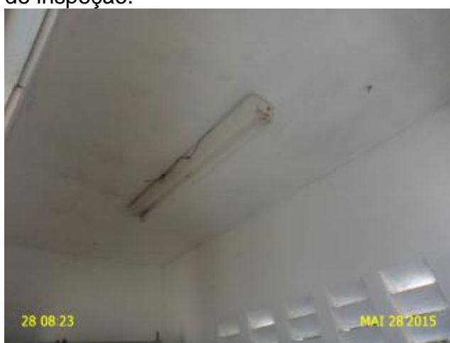
Foto 11 – EEAB-01: sem iluminação.
