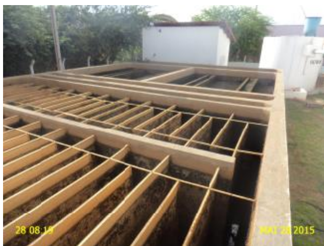
Foto 7 – Floco decantador: ausência de passarelas com guarda-corpo.
