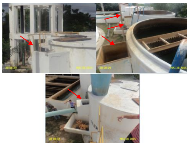
Foto 4 – Filtros: ausência de tampas nas calhas de saída de água.
