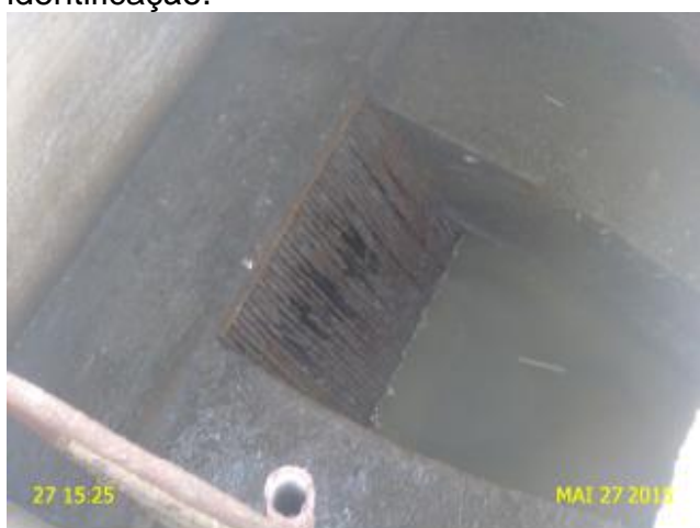
Foto 12 – EEE-06: gradeamento danificado.
