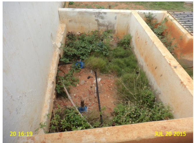
Foto 4 - REL-01: caixa de inspeção sem tampa ou grade protetora.
