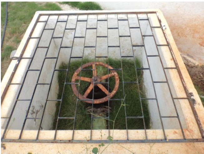
Foto 3 - REL-01: vazamento no registro.
