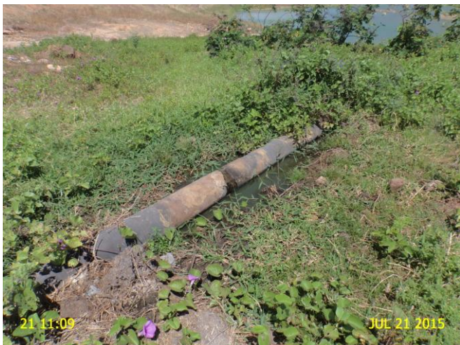
Foto 7 - AAB: vazamento próximo à catação.
