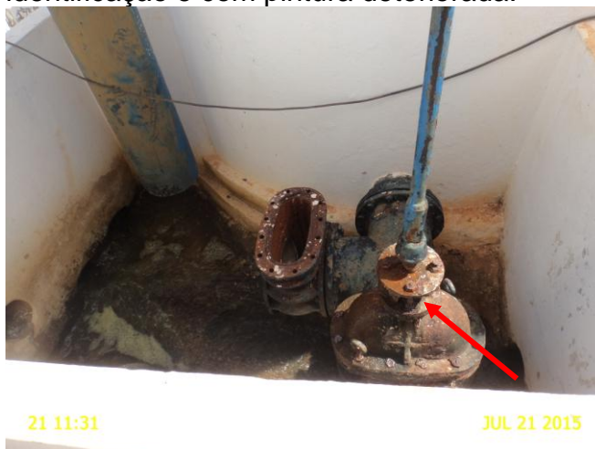
Foto 12 - F-01: vazamento no registro.
