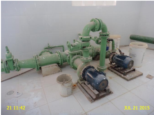
Foto 3 - EEAT-01 e EEAT-02: ausência de bomba reserva instalada.
