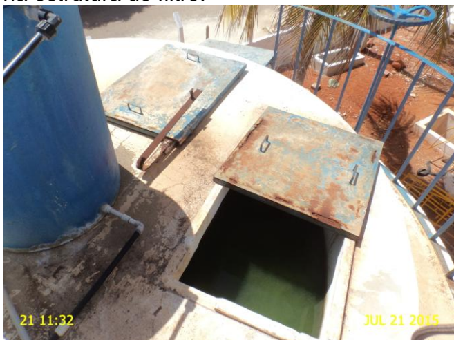
Foto 11 - F-02: tampa sem vedação.
