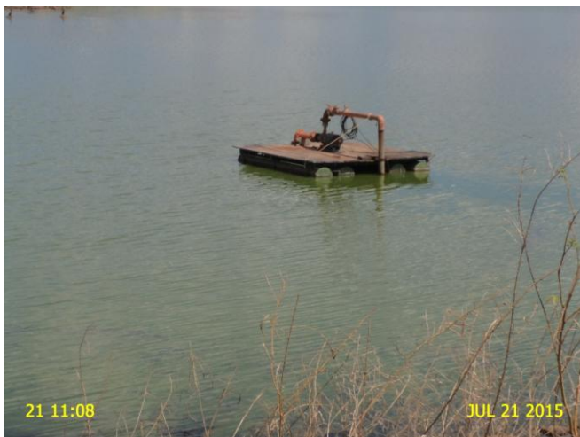
Foto 1 - EECS-01: ausência de bomba reserva instalada.
