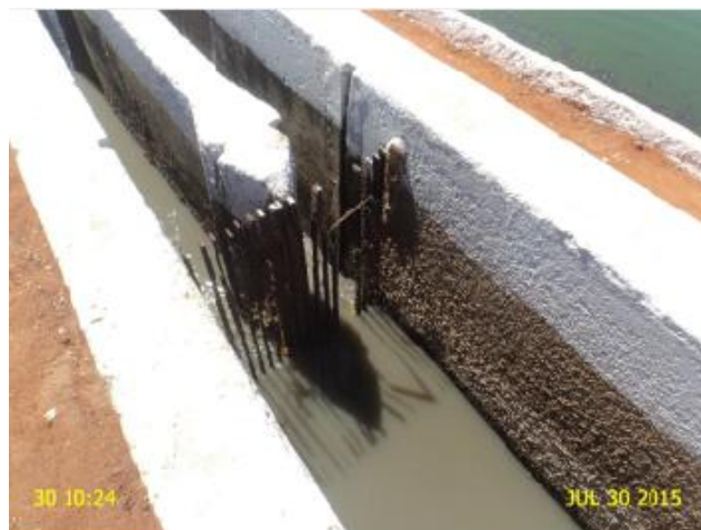
Foto 17 – ETE: gradeamento deteriorado.
