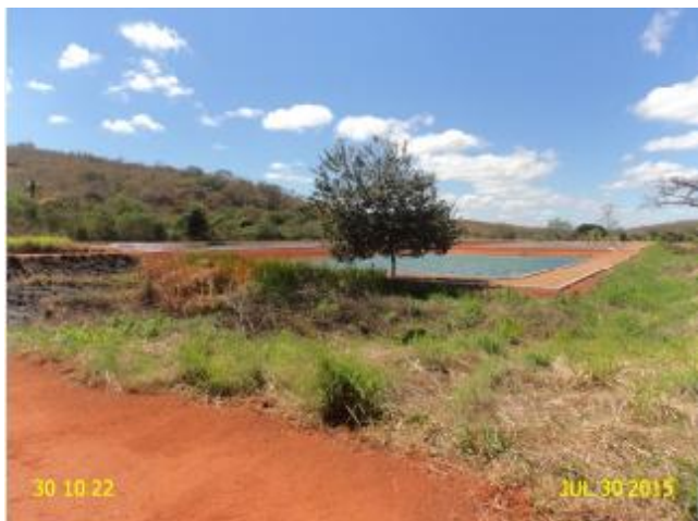
Foto 3 – ETE: ausência de instalações para iluminação.
