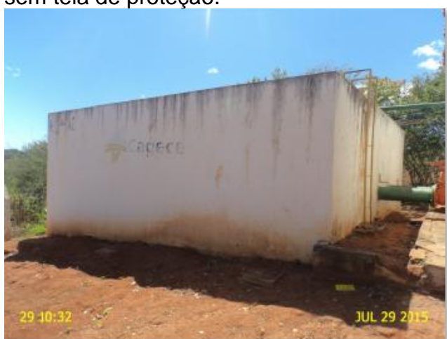
Foto 24 – RAP-02: pintura deteriorada e ausência de identificação.
