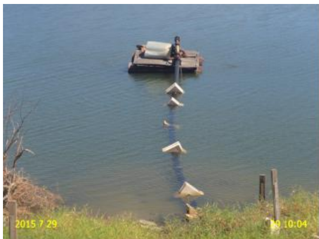
Foto 1 – EE-CS/EE-01: ausência de bomba reserva.
