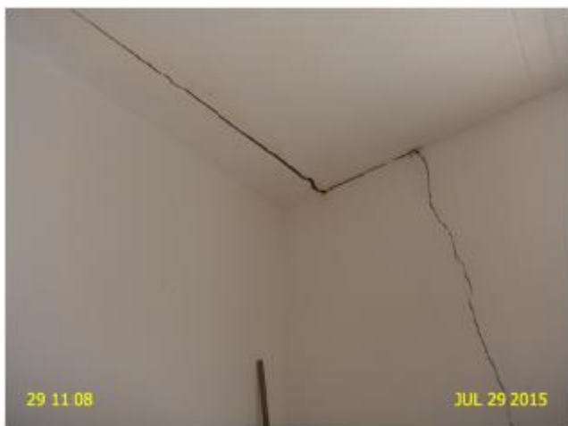
Foto 16 – EE-04: rachadura na estrutura.
