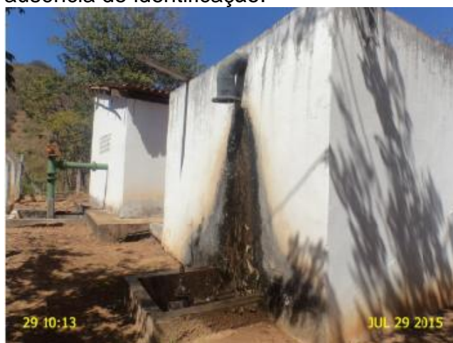
Foto 26 – RAP-02: ocorrência de extravasamento e pintura deteriorada.
