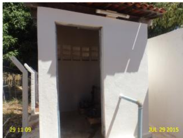
Foto 9 – EE-05: ausência de identificação.
