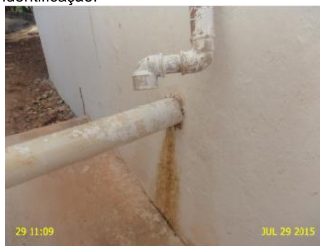
Foto 27 – RAP-03: vazamento na estrutura da tubulação.
