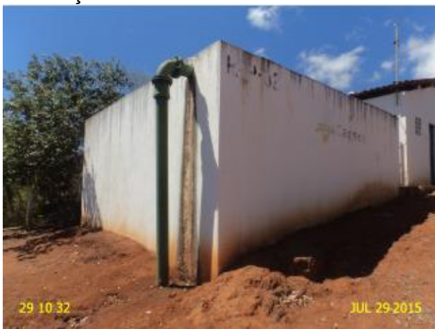
Foto 5 – RAP-02: ausência de medidor de nível.
