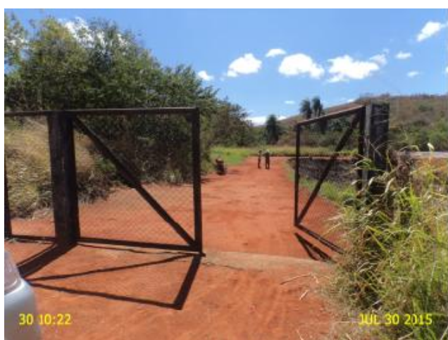
Foto 18 – ETE: ausência de identificação.
