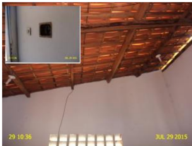
Foto 11 – EE-03: ausência de iluminação.
