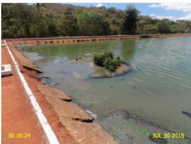
Foto 20 – ETE: acúmulo de sobrenadantes com formação de ilha na LF.
