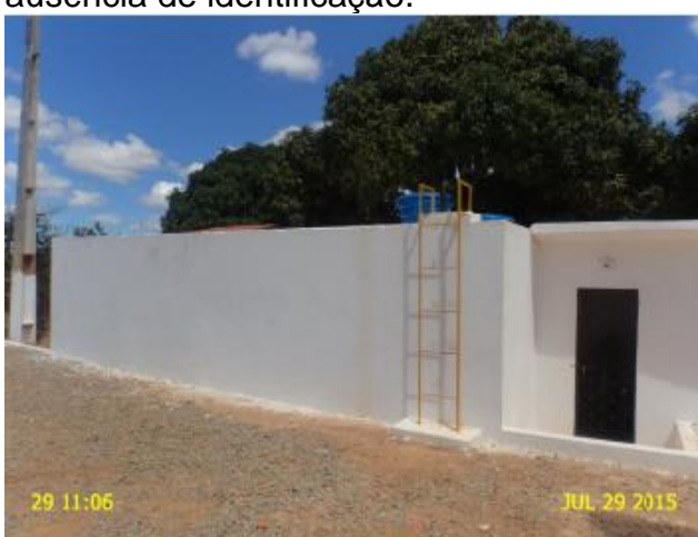
Foto 25 – RAP-03: ausência de identificação.
