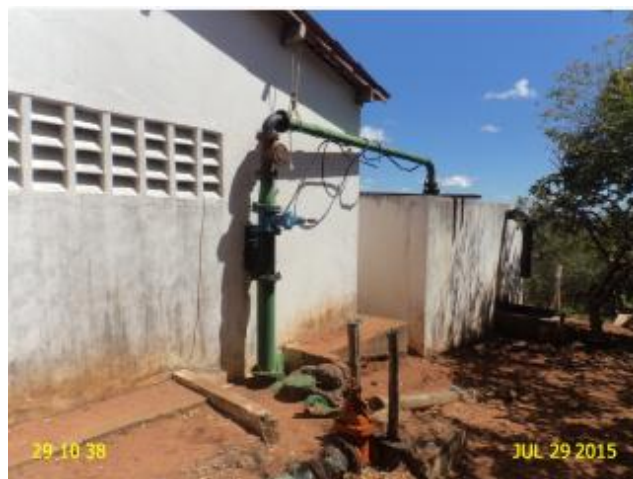
Foto 2 – EE-03: ausência de bomba submersa reserva.
