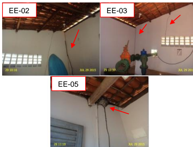
Foto 15 – EE-02, EE-03 e EE-05: cupins.
