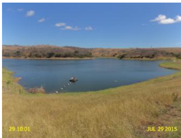
Foto 30 – Captação: ausência de identificação da área.
