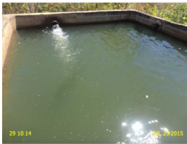
Foto 4 – RAP-01: ausência de controle de nível.
