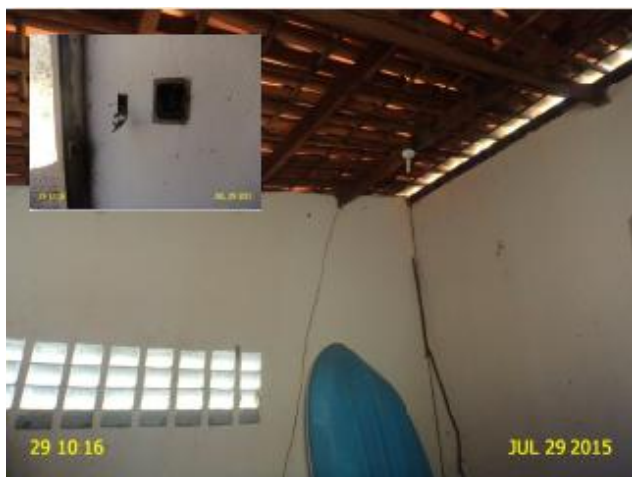
Foto 10 – EE-02: ausência de iluminação.
