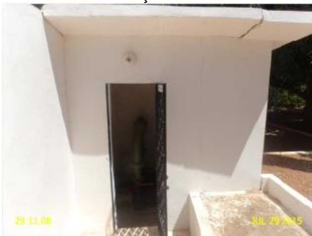
Foto 8 – EE-04: ausência de identificação.
