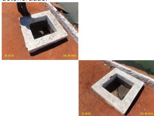
Foto 21 – ETE: caixas de inspeção sem tampa.
