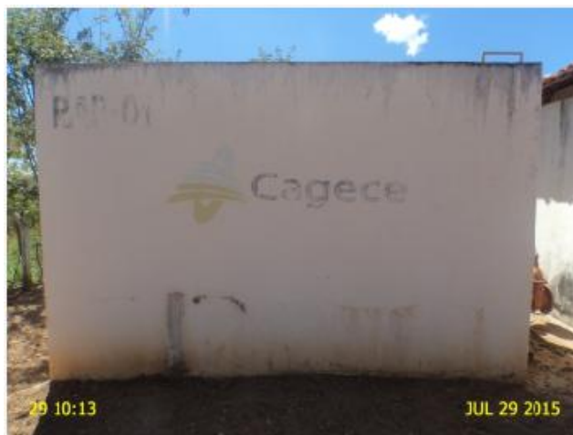
Foto 23 – RAP-01: pintura deteriorada e ausência de identificação.
