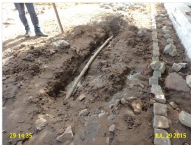
Foto 32 – RAP-03: vazamento Rua José Carneiro Almeida, nº 92.
