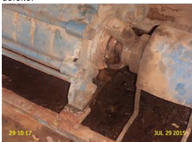
Foto 14 – EE-02: vazamento na gaxeta da bomba.
