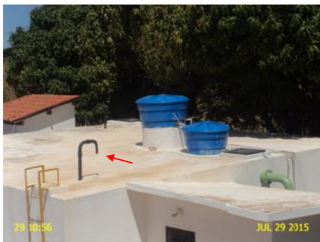
Foto 22 – RAP-03: tubulação de ventilação sem tela de proteção.
