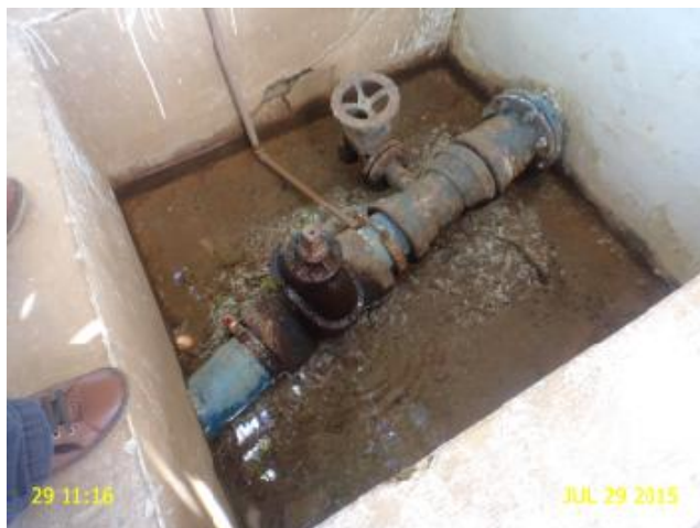
Foto 28 – RAP-03: vazamento no registro.
