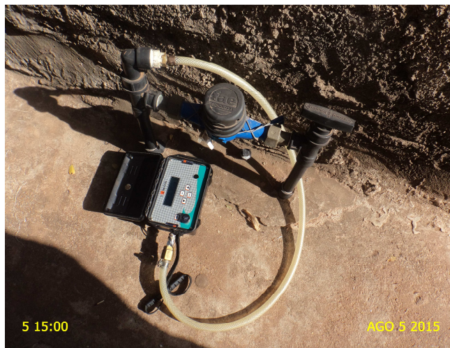
Foto 10 – Aparelho datalogger instalado no endereço localizado na Rua do Alto, nº 168.
