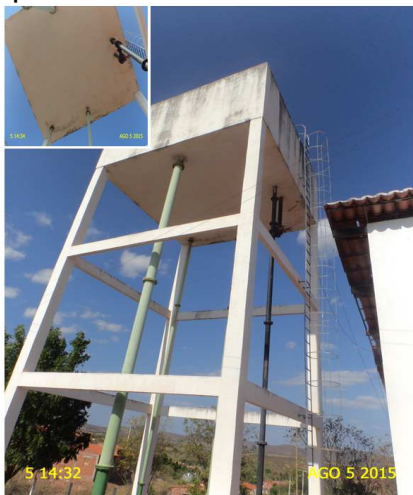
Foto 7 – REL-01: pintura deteriorada e sinais de infiltração na laje.
