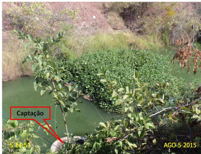
Foto 13 – EECS-01: inadequadas condições de limpeza.
