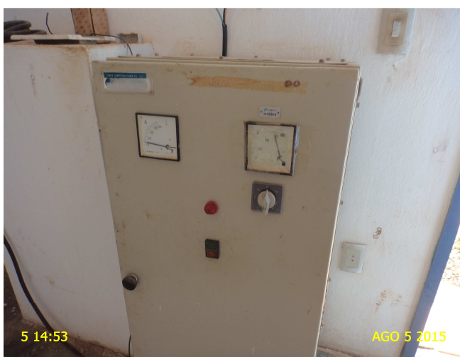
Foto 1 – EECS-01: quadro de comando sem horímetro.
