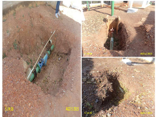
Foto 6 – ETA: macromedidor e estações pitométricas sem caixa de inspeção.
