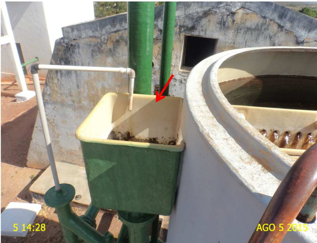
Foto 3 – F-01: ausência de tampa de proteção na calha de saída da água tratada.
