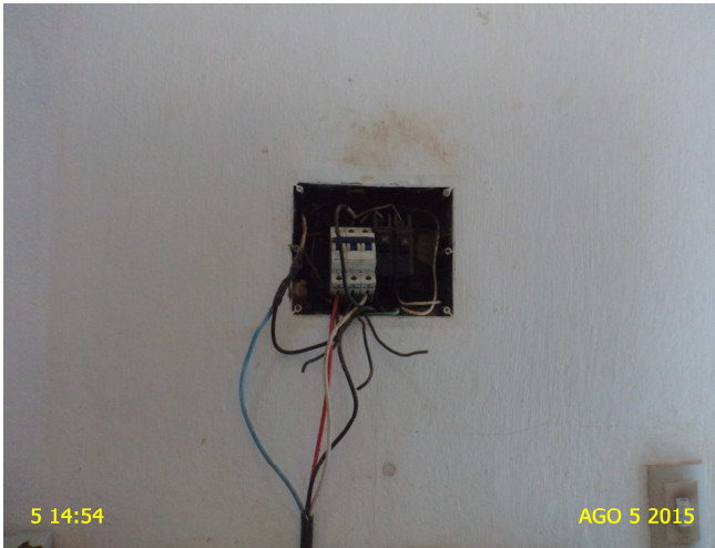
Foto 5 – EECS-01: quadro de força com fiação exposta.
