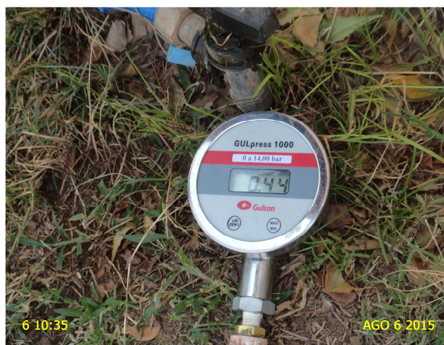
Foto 12 – Medição de pressão na Rua Estrada para Lima Campos, s/n.
