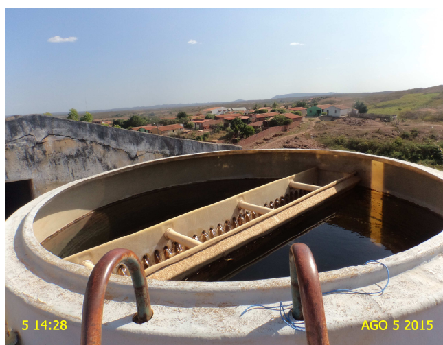
Foto 2 – F-01: ausência de tampa.
