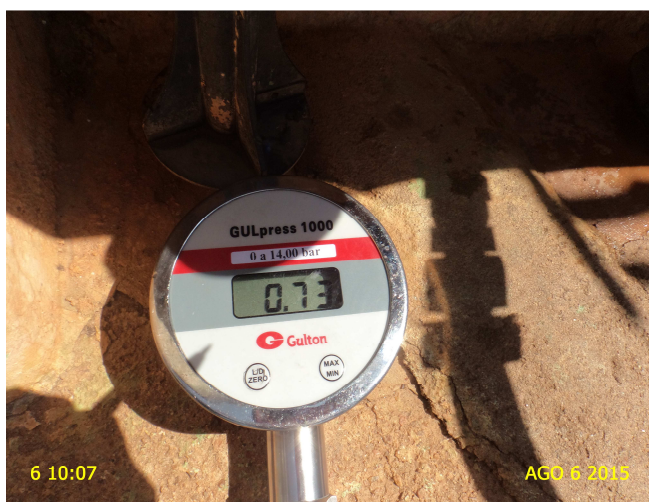
Foto 11 – Medição de pressão na Rua Vila Campos, nº 396.
