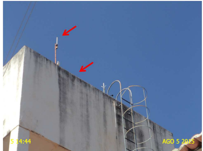
Foto 4 – REL-01: ausência de guarda-corpos na laje de cobertura e ausência de sinalizador noturno.
