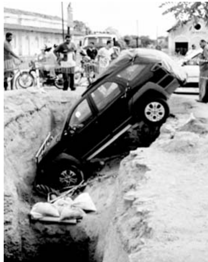
Iniciadas em 2008, as obras do Sanear II causaram muitos transtornos em Quixadá, levando alguns prejuízos à população. Houve muitas reclamações
