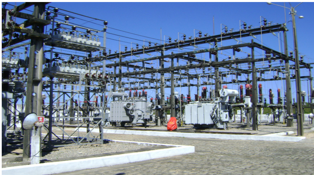
Figura 2 – Subestação da Coelce fiscalizada pela Arce Fonte: Arce
