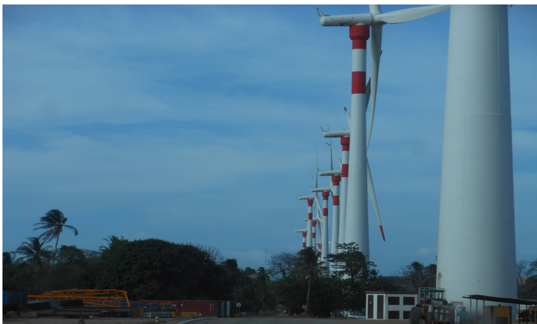
Figura 1 – Parque eólico de Trairi-CE Fonte: Arce
