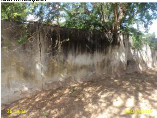
Foto 32 – REN-01 e EERD-02: rachadura no muro.
