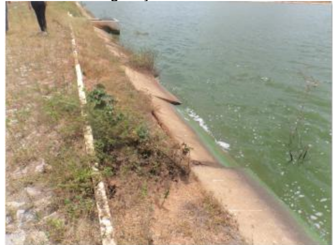
Foto 21 – ETE Maranguape: placas deterioradas no talude da LF4.
