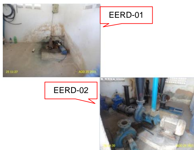
Foto 2 – EERD-01 e EERD-02: ausência de bomba reserva.
