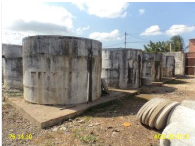
Foto 34 – ETE Alto dos Bílias: decantadores e filtros sem identificação, pintura deteriorada, rachaduras, vazamentos e ausência de escada de acesso à laje.
