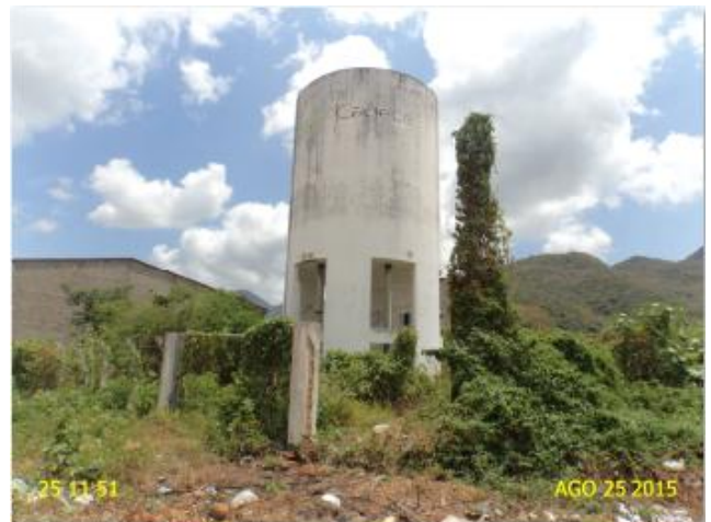
Foto 31 – REL-01: cerca de delimitação danificada.
