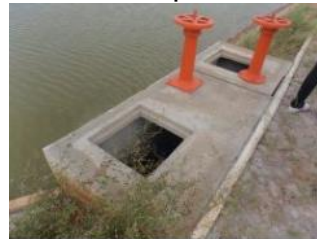
Foto 23 – ETE Pedro Câmara: portão danificado, pintura e reboco deteriorados.
