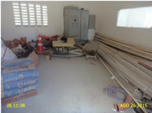
Foto 12 – EEE-02: materiais armazenados na área da elevatória dificultando o acesso ao quadro de comando.
