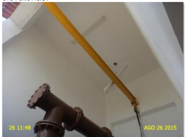
Foto 15 – EEE-03: ausência de iluminação elétrica.
