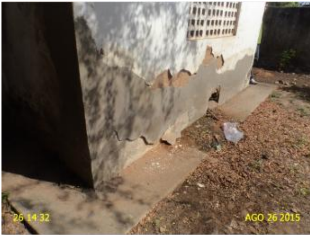
Foto 5 – REN-01: ausência de tubulação de ventilação.
