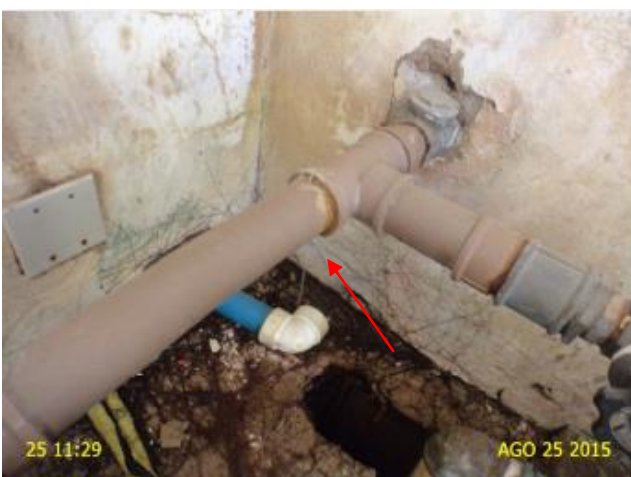
Foto 10 – EERD-01: vazamento na tubulação.
