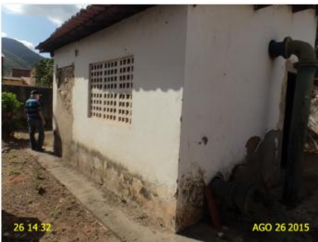
Foto 30 – REN-01 e EERD-02: ausência de identificação.
