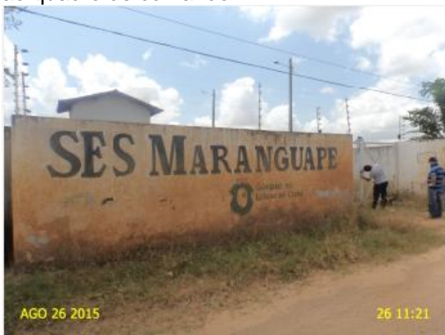
Foto 14 – EEE-01: pintura deteriorada.
