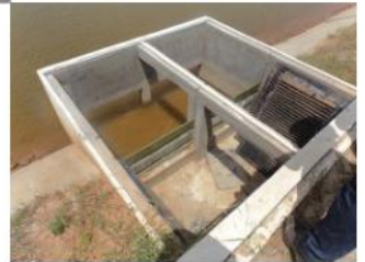
Foto 25 – ETE Maranguape: ausência de tampas nas caixas de inspeção da LM1.
