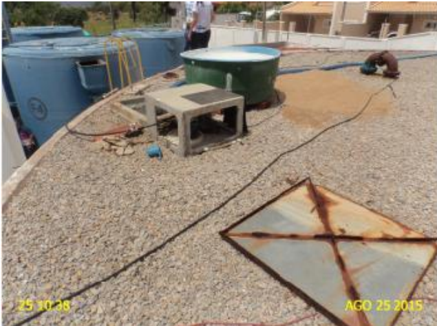
Foto 28 – RAP-01: tampa em processo de corrosão.
