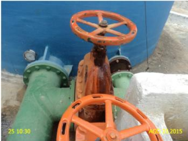
Foto 6 – F-02: vazamento no registro.
