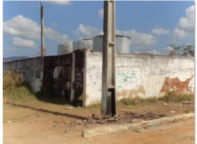
Foto 23 – ETE Pedro Câmara: portão danificado, pintura e reboco deteriorados.
