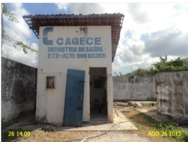
Foto 16 – ETE Alto dos Biliás: casa de apoio ao operador deteriorada, sem porta e iluminação elétrica.
