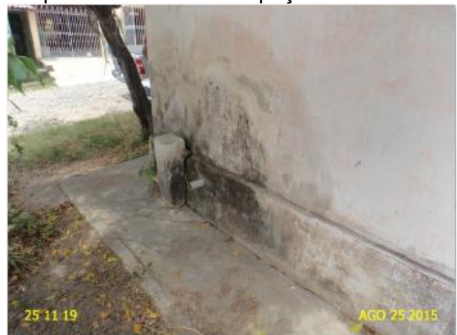
Foto 27 – RSE-01: tubulação de ventilação sem tela de proteção.
