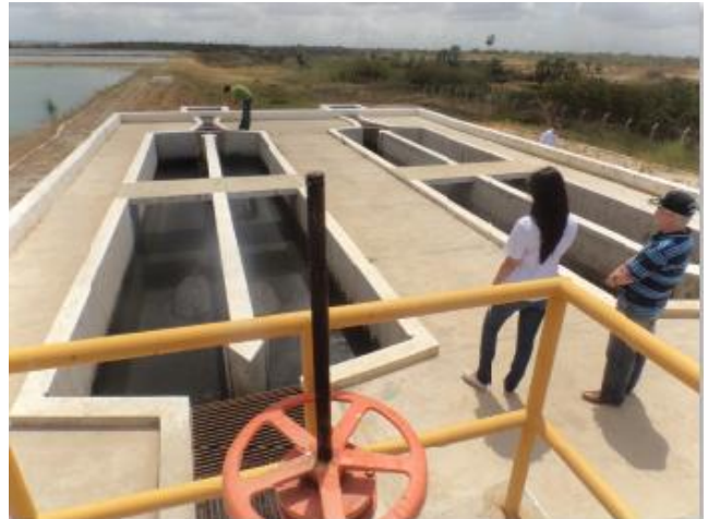
Foto 4 – ETE Maranguape: ausência de instalações de iluminação elétrica.
