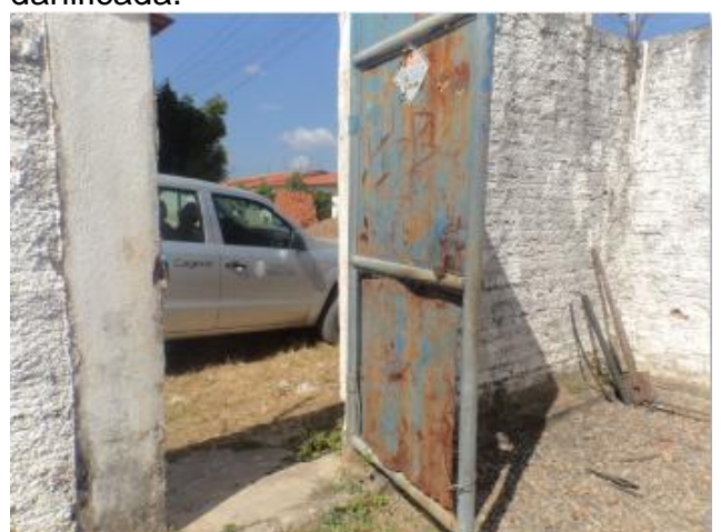
Foto 33 – ETE Alto dos Bílias: portão deteriorado.
