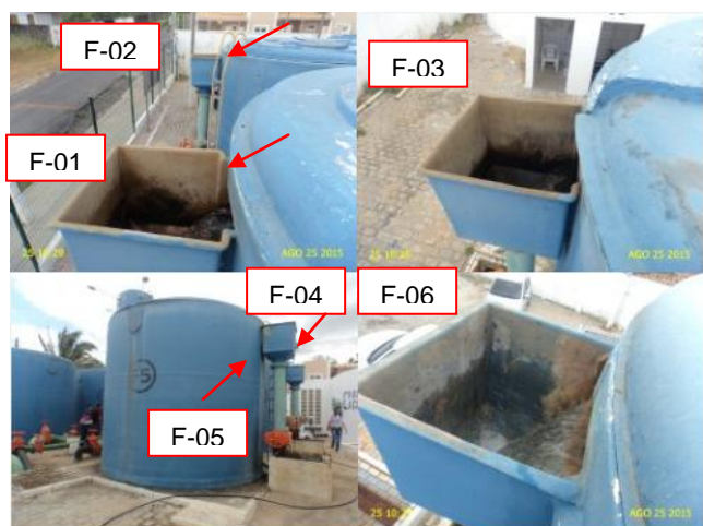
Foto 1 – F-01, F-02, F-03, F-04, F-05 e F-06: calhas de água sem tampa.
