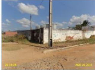
Foto 22 – ETE Maranguape e ETE Pedro Câmara: ausência de identificação.
