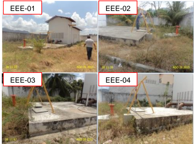
Foto 13 - EEE-01, EEE-02, EEE-3 e EEE-04: excesso de vegetação na área das elevatórias.
