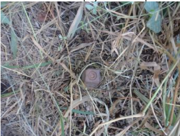
Foto 26 – RDA: registro sem caixa na Av. Senador Almir Pinto (Ponte do Limão).
