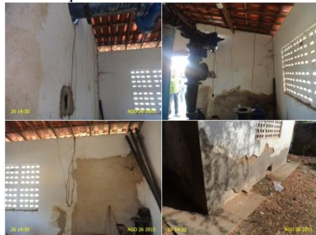
Foto 9 – EERD-02: estrutura deteriorada.
