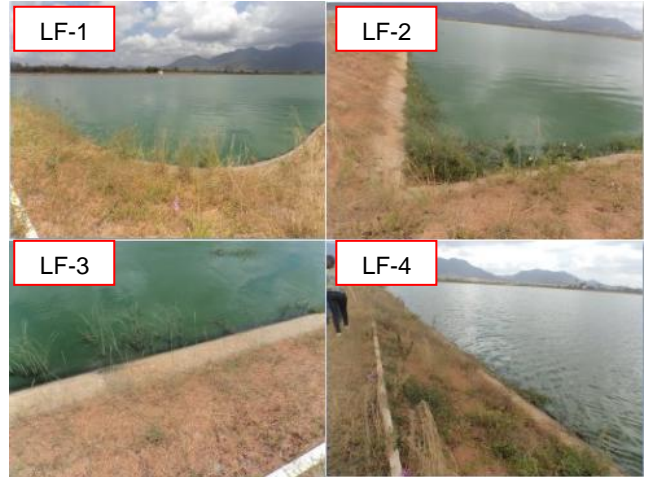
Foto 19 – ETE Maranguape: lagoas com excesso de vegetação.
