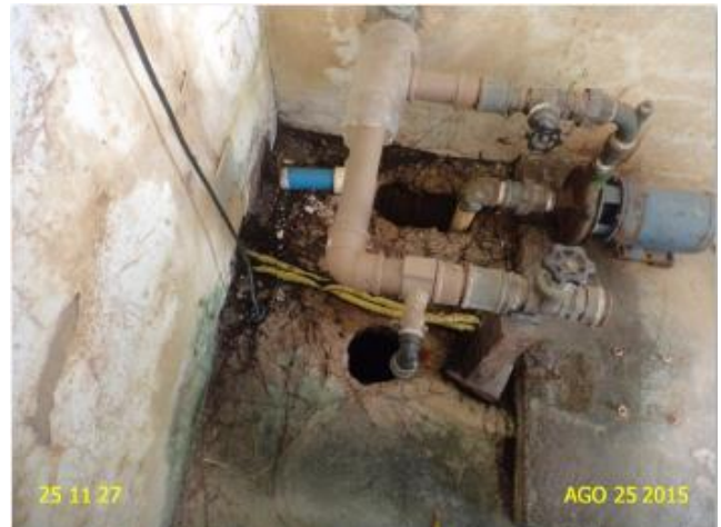
Foto 29 – RSE-01: estrutura deteriorada na entrada da tubulação da elevatória de água EERD-01.
