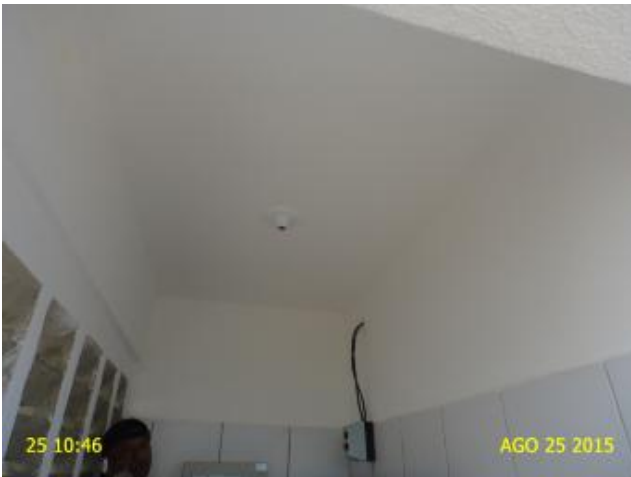
Foto 8 – EERD-3: ausência de iluminação elétrica.
