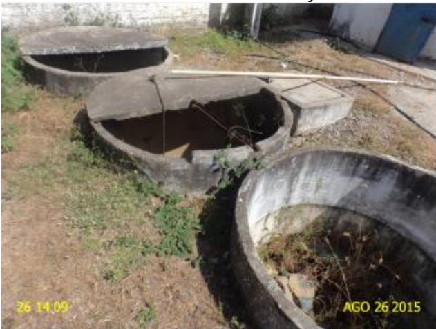
Foto 24 - ETE Alto dos Bílias: ausência de medidor de vazão e poços sem tampa.
