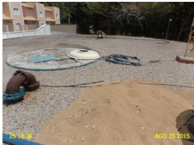
Foto 35 – RAP-01: materiais armazenados na laje de cobertura.
