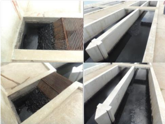
Foto 18 – ETE Maranguape: gradeamento e caixas de areia com acúmulo de lodo.
