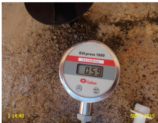
Foto 16 – Medição de pressão na Rua da Jurema (528-SMS) – Acampamento.
