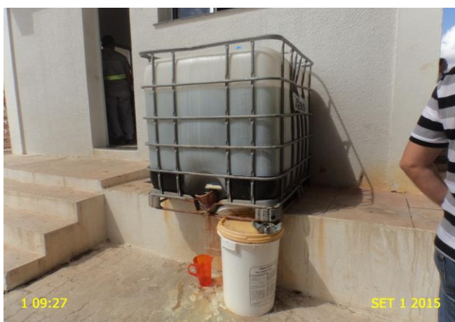
Foto 6 – ETA: produto químico armazenado ao ar livre.
