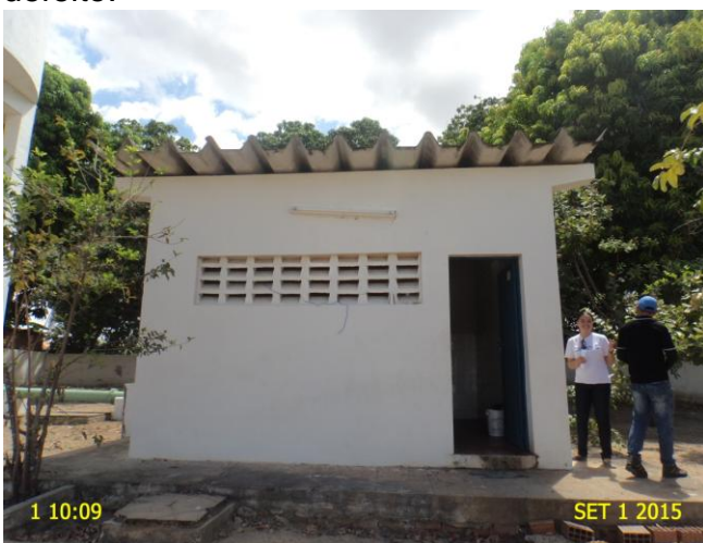
Foto 12 – EEAT-03: sem identificação.
