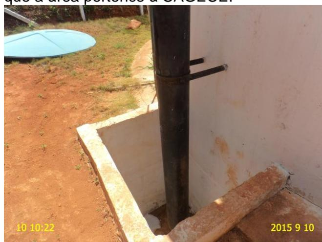
**Foto 13** - RAP-01: caixa de inspeção sem tampa ou grade protetora.
