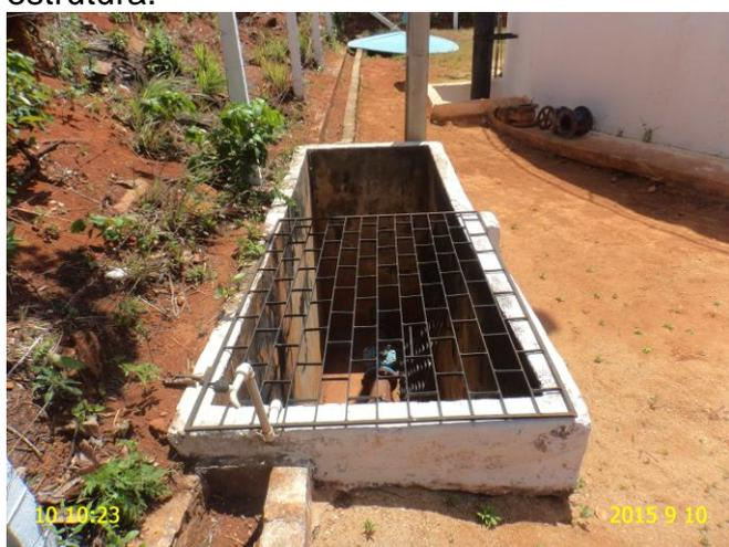
**Foto 10** - ETA: caixa do macromedidor parcialmente sem grade protetora.
