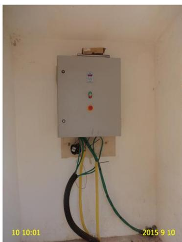
**Foto 6** – EECS-01: amperímetro e voltímetro não instalados.
