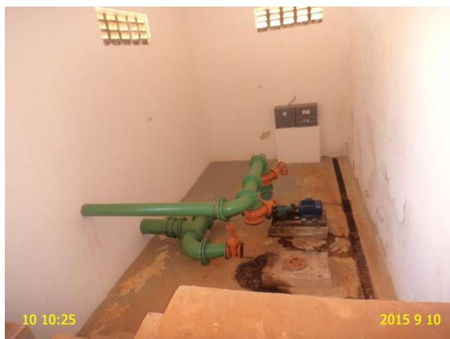
**Foto 7** – EELF-01: ausência de bomba reserva instalada.
