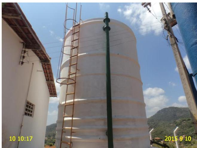
**Foto 8** - Decantador: ausência de identificação e escada sem fixação na estrutura.
