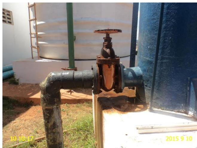
**Foto 9** - Torre de nível: vazamento no registro.
