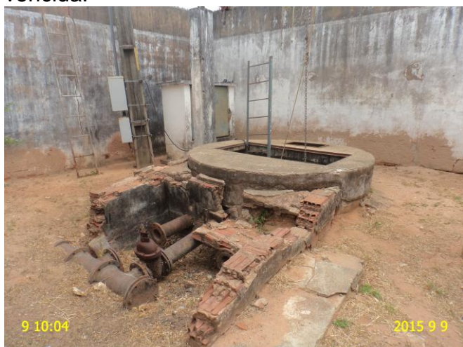
Foto 15 - EEE: poço de sucção sem tampa.
