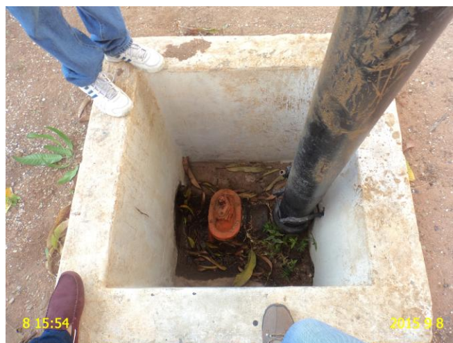
Foto 26 - REL-01: caixa de inspeção sem tampa ou grade protetora e registro sem vedação.
