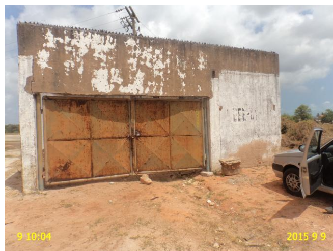
Foto 14 - EEE: identificação pouco visível, pintura do muro deteriorada e portão em processo de corrosão.
