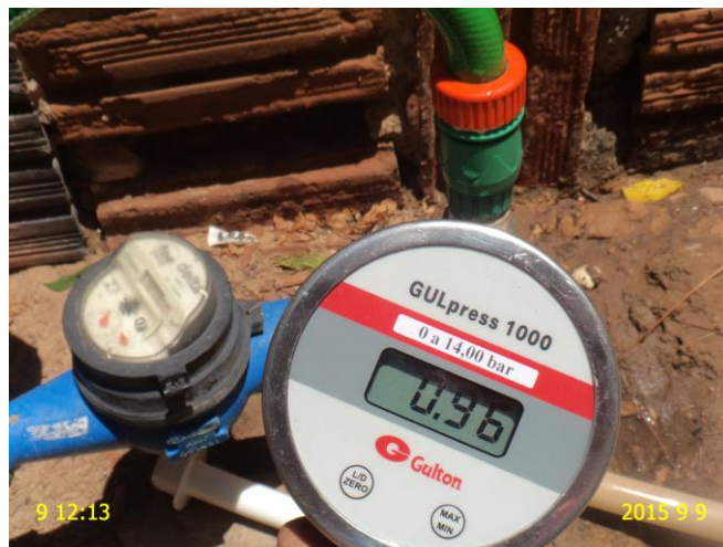
Foto 2 - Medição de pressão instantânea na rede de distribuição: Rua Santo Antônio, 432.
