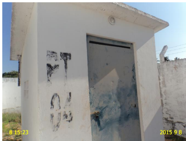
Foto 4 - PT-04: ausência de iluminação elétrica e identificação pouco visível.
