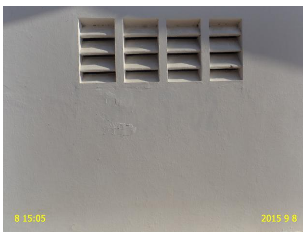
Foto 30: EEAT-01 e EEAT-02: identificação pouco visível.
