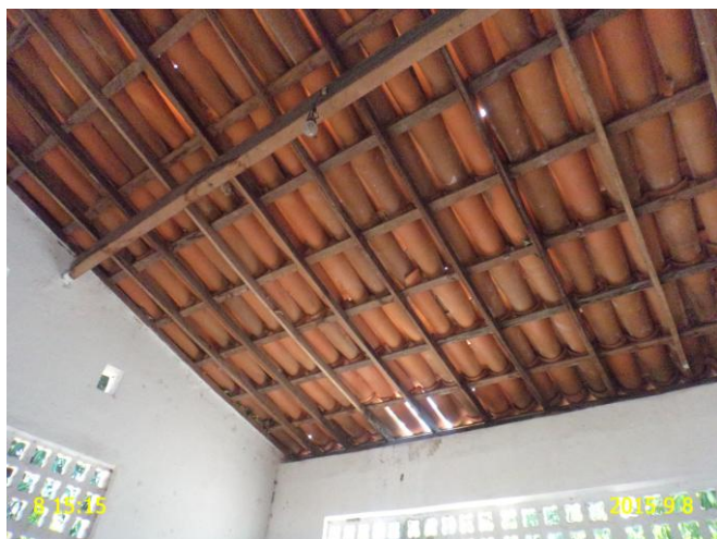
Foto 3 - PT-02: iluminação elétrica com defeito.
