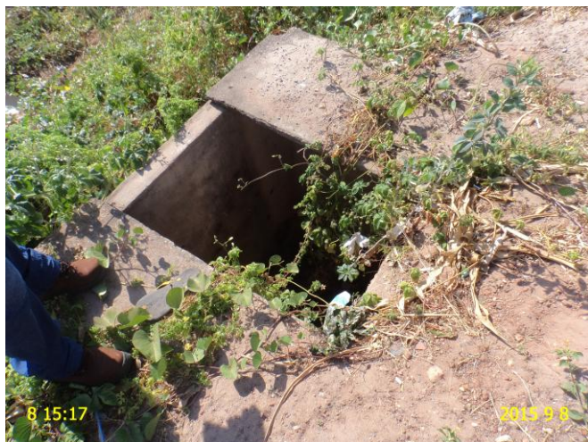
Foto 7 - AAT: caixa de inspeção sem tampa ou grade protetora.
