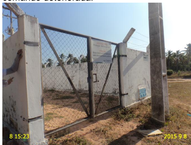
Foto 10 : PT-04: portão de acesso com grade danificada.
