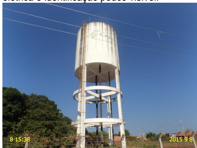
Foto 6 - REL-02: pintura deteriorada, ausência de sistemas de medição e controle de nível e ausência de sinalização noturna de obstáculos.
