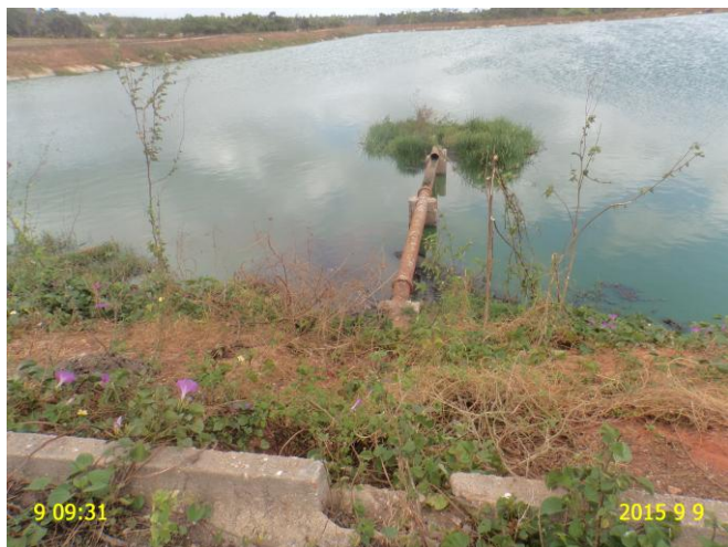
Foto 19 - ETE: tubulação de chegada do esgoto bruto na LF-01 danificada.
