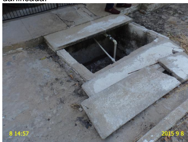
Foto 12 - ETA: caixa de inspeção com tampa danificada.
