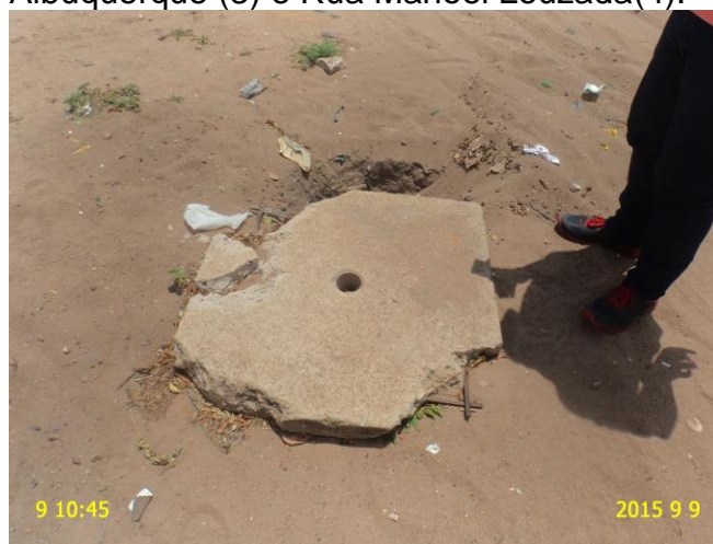
Foto 22 - RDA: registro de manobra com tampa danificada - Bairro Bailarina.
