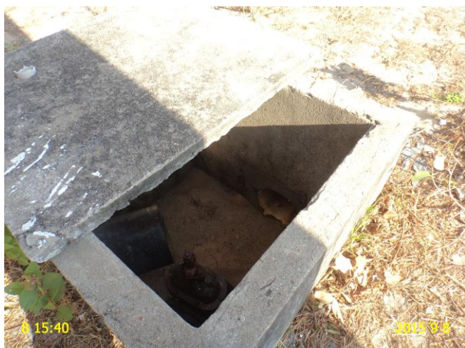
Foto 25 - REL-02: caixa de inspeção com tampa danificada.
