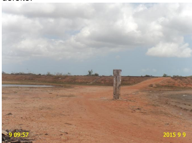
Foto 5 - ETE: ausência de delimitação, identificação, iluminação elétrica e edificação de apoio para o operador.
