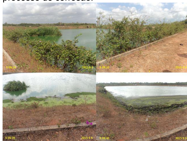
Foto 16 - ETE: vegetação excessiva e acúmulo de sobrenadantes nas Lagoas Facultativas LF-01 e LF-02.
