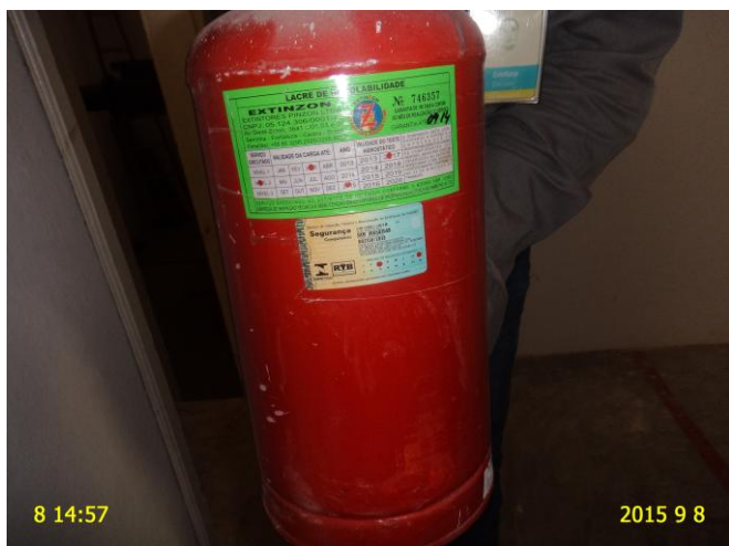
Foto 13 - Casa de bombas: extintor de incêndio com data de validade da recarga vencida.
