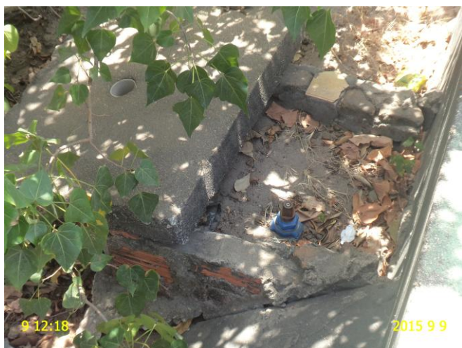
Foto 21 - RDA: registro de descarga com tampa descoberta - Rua Santo Antônio.
