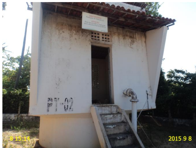
Foto 8 - PT-02: identificação pouco visível e pintura da casa de abrigo do quadro de comando deteriorada.
