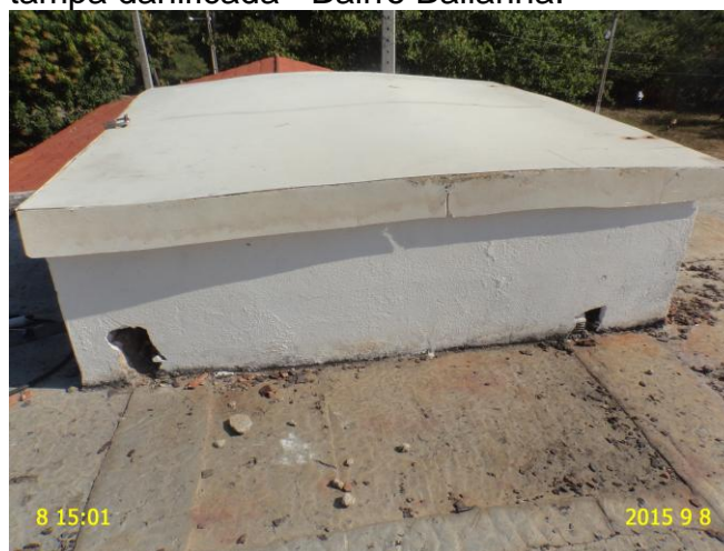
Foto 24 - RAP-01: tampa de inspeção sem vedação.
