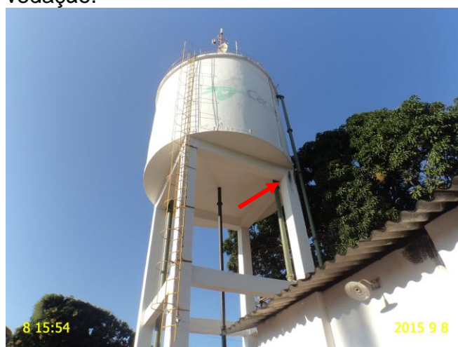
Foto 28 - REL-01: sinais de vazamento na estrutura.
