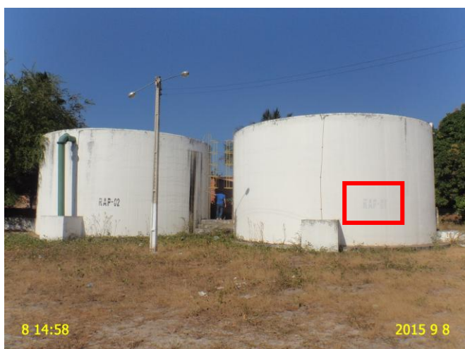
Foto 27 - RAP-01 e RAP-02: identificação pouco visível (RAP-01) e pintura deteriorada (RAP-01 e RAP-02).
