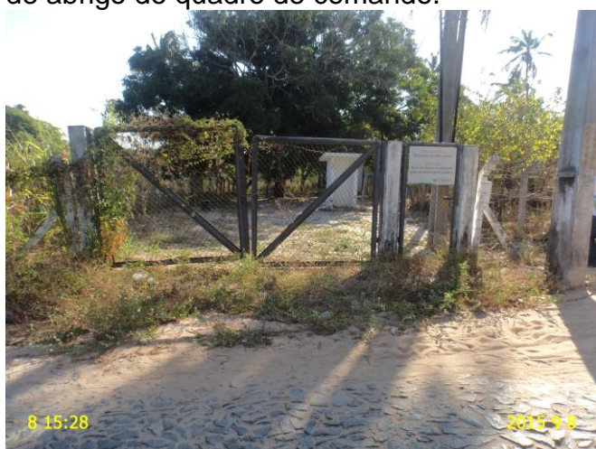
Foto 11 - PT-03: portão de acesso e cerca de delimitação da área danificados.
