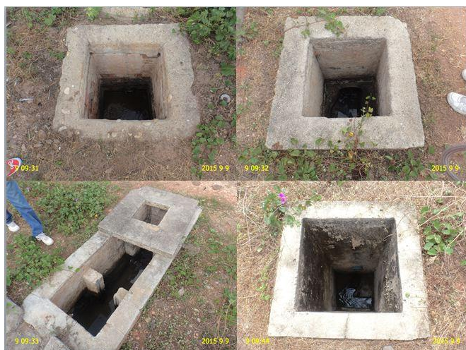
Foto 17 - ETE: caixas de inspeção/passagem sem tampas.
