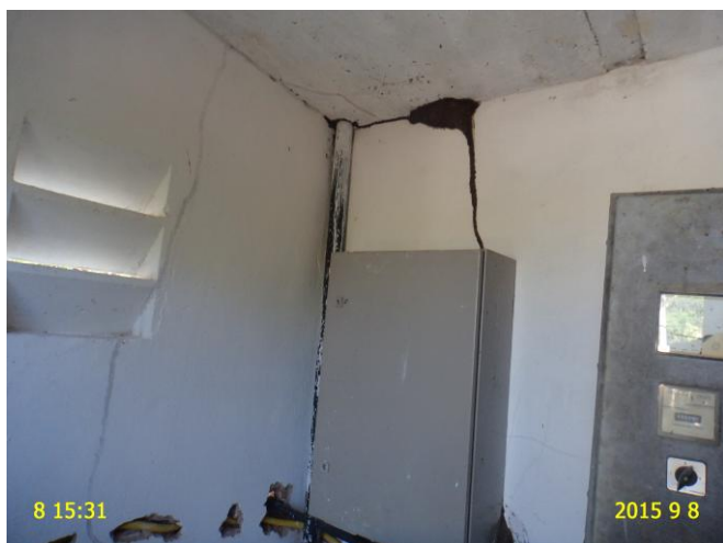
Foto 9 - PT-03: presença de cupins na casa de abrigo do quadro de comando.
