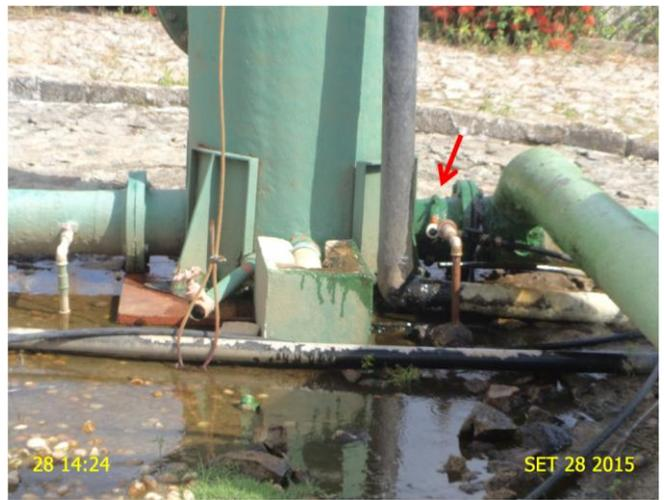
**Foto 6** – AAB: torre de nível com vazamento.
