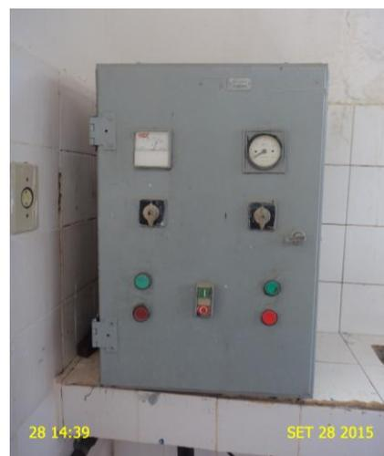
**Foto 2** – EELF-01: quadro de comando sem horímetro.
