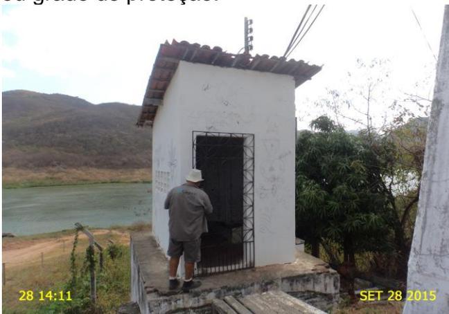
**Foto 7** – EECS-01: casa do quadro de comando com pintura deteriorada.
