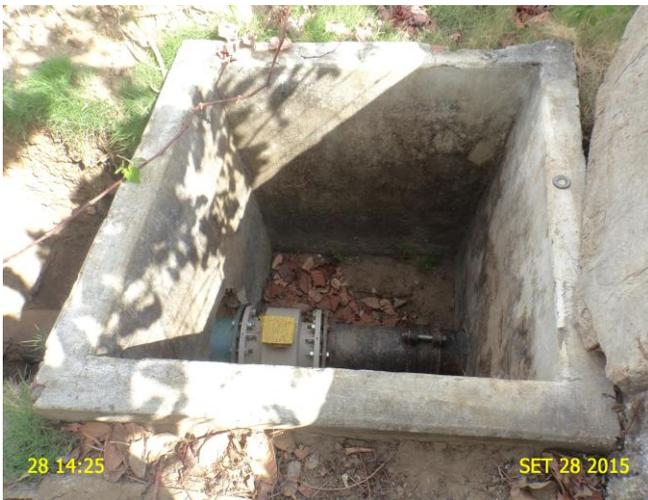
**Foto 5** – AAB: caixa de inspeção sem tampa ou grade de proteção.
