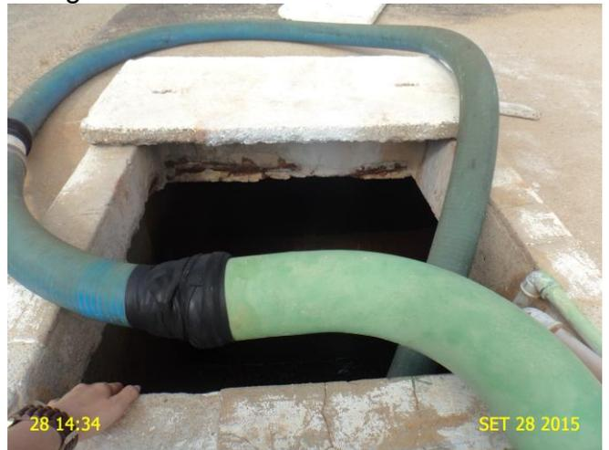
**Foto 20** – RAP-01: tampa de inspeção inadequada.
