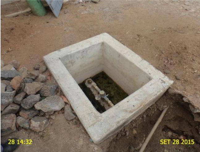
**Foto 17** – ETA: macromedidor desativado sem tampa ou grade de proteção e com acúmulo de água.
