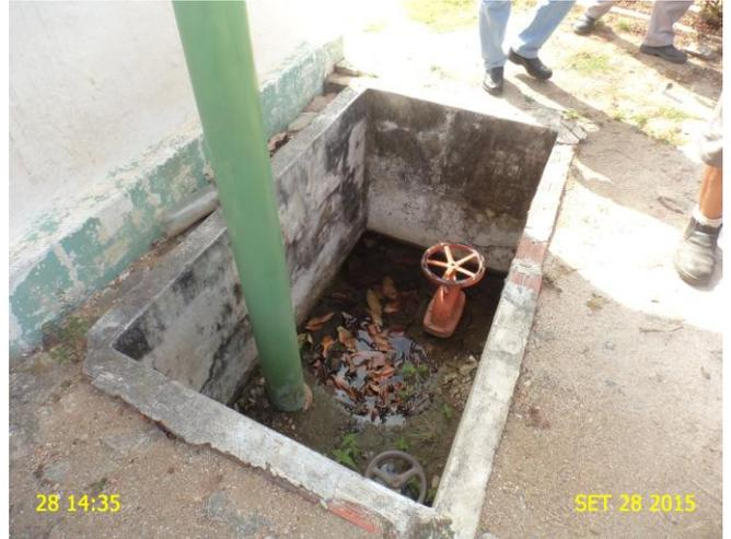
**Foto 18** – RAP-01: caixa de registro sem tampa ou grade de proteção e com acúmulo de água.
