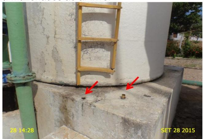
**Foto 10** – F-01: escada sem fixação na estrutura do filtro.
