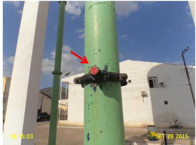
**Foto 4** – REL-01: ausência de medidor de nível.
