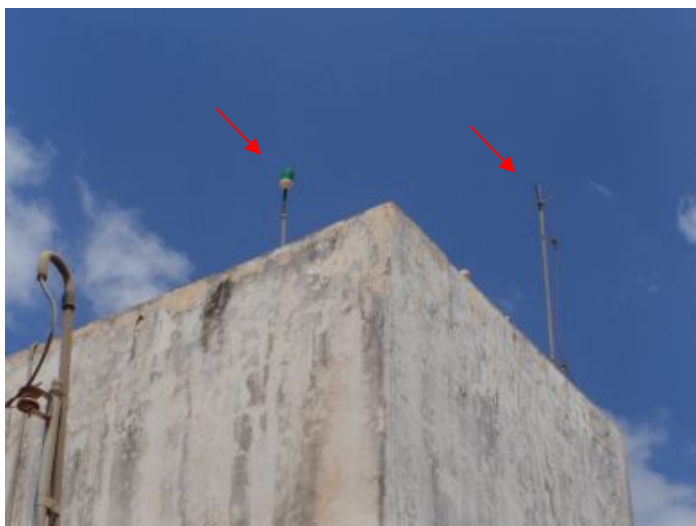
Foto 2 – REL-03: sinalizador noturno e para-raios.
