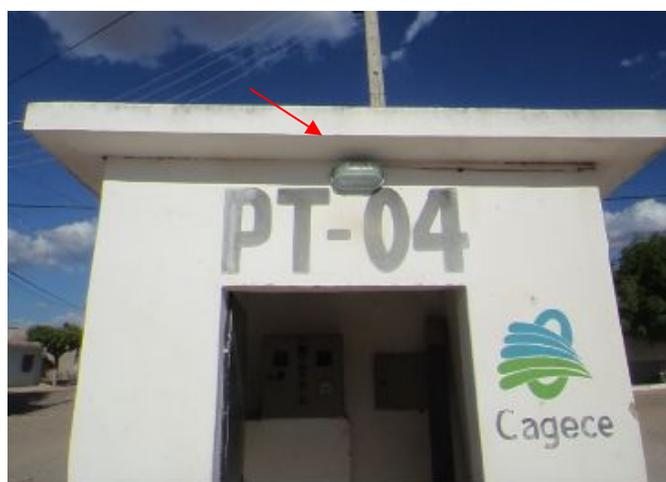
**Foto 3** – PT-04: instalação elétrica externa para iluminação.
