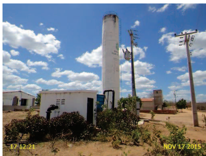
Foto 2 - RAP já existente na localidade de Pedra Preta I, operando.
