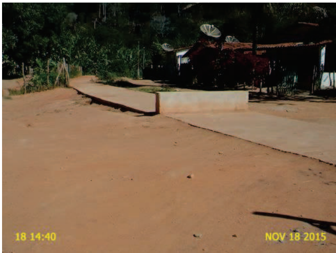
Foto 2 - Obra de drenagem do Sítio Bastiões concluída.
