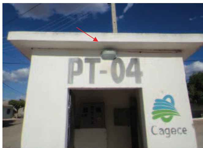
Foto 3 – PT-04: instalação elétrica externa para iluminação.
