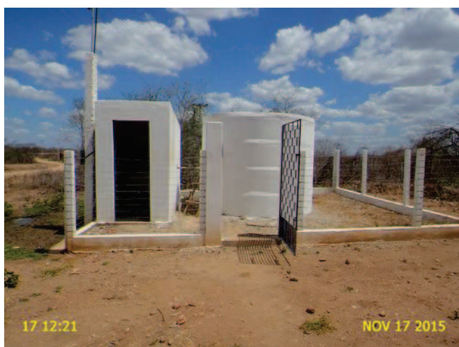
Foto 1 – Novo RAP da localidade de Pedra Preta I, concluído e em funcionamento.
