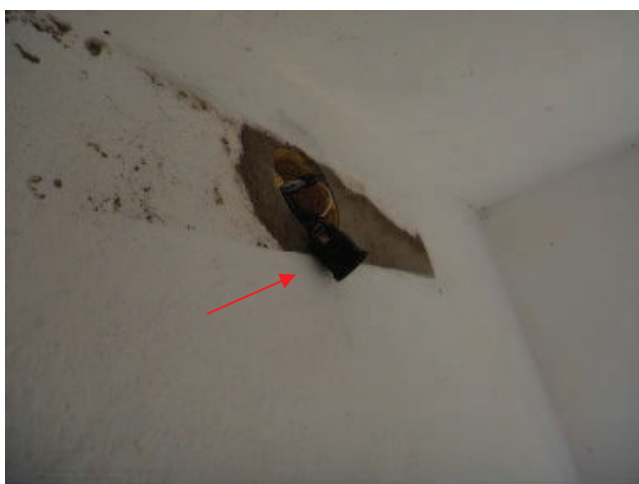
Foto 2 – PT-04: instalação elétrica interna para iluminação.
