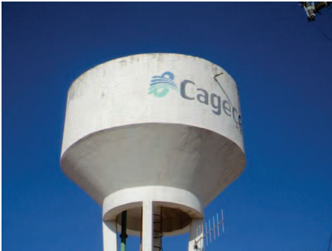
Foto 2 - REL-01: Pintura adequada.
