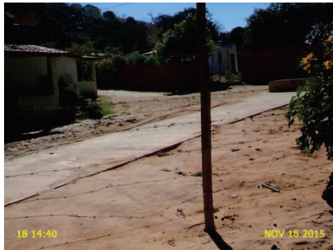
Foto 3 - Obra de drenagem do Sítio Bastiões concluída.
