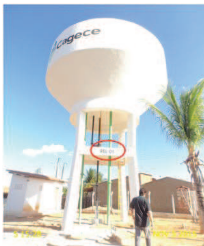
Foto 2 – REL-01: identificado e em bom estado de conservação e manutenção.
