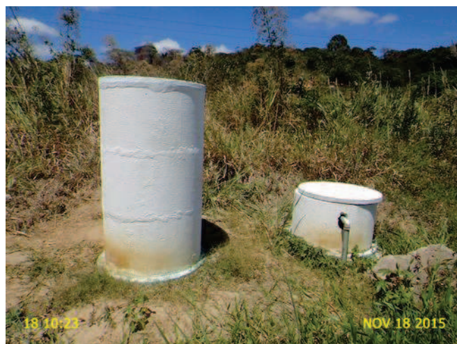
Foto 3 - Captação subterrânea e reservatório na localidade de Coquinhos.
