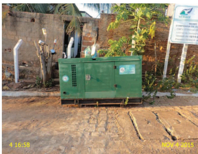
Foto 3 – Grupo gerador a ser instalado.
