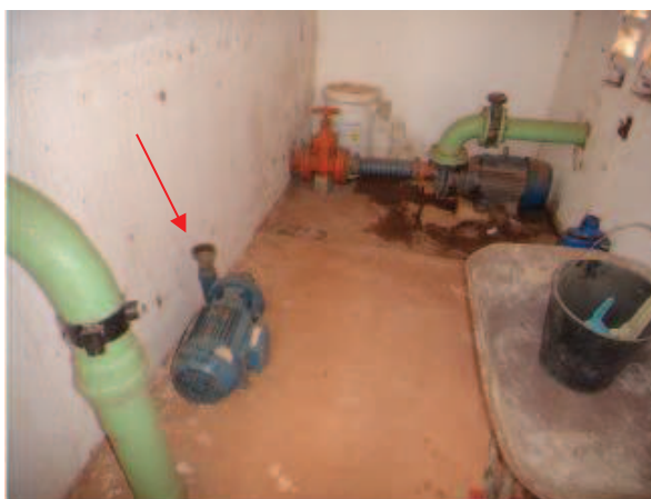
Foto 2 – EEAT-01: bomba reserva.
