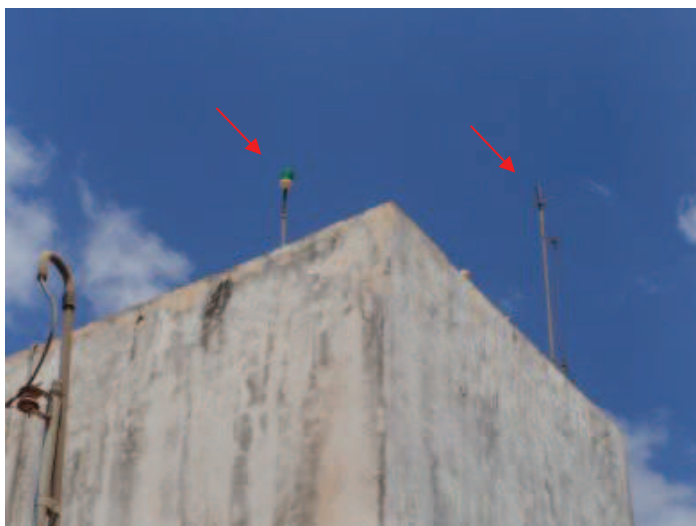
Foto 2 – REL-03: sinalizador noturno e para-raios.
