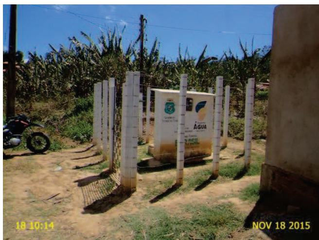
Foto 2 - Captação subterrânea na localidade de Aningas.
