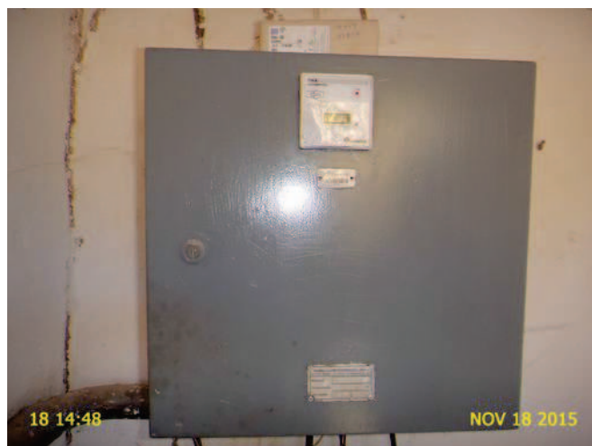
Foto 5 - EEPR-01: Quadro de Comando com horímetro instalado.
