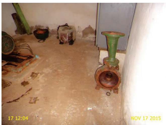
Foto 3 – EEPR-01: CMB necessidade de instalação.
