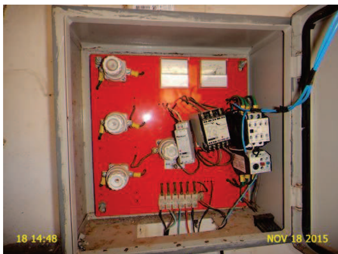
Foto 4 - EEPR-01: Quadro de comando com amperímetro e voltímetro instalados.
