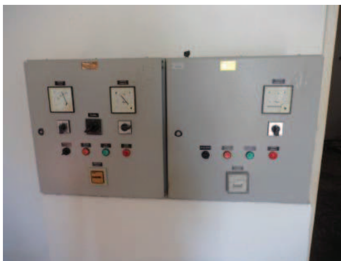
Foto 2 – EEAT-02: quadro de comando com voltímetro.
