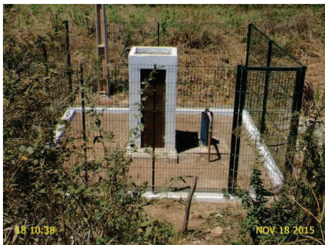
Foto 4 - Poço perfurado pela Prefeitura que está sendo usado pela CAGECE para abastecer a Sede do Município de Aratuba.
