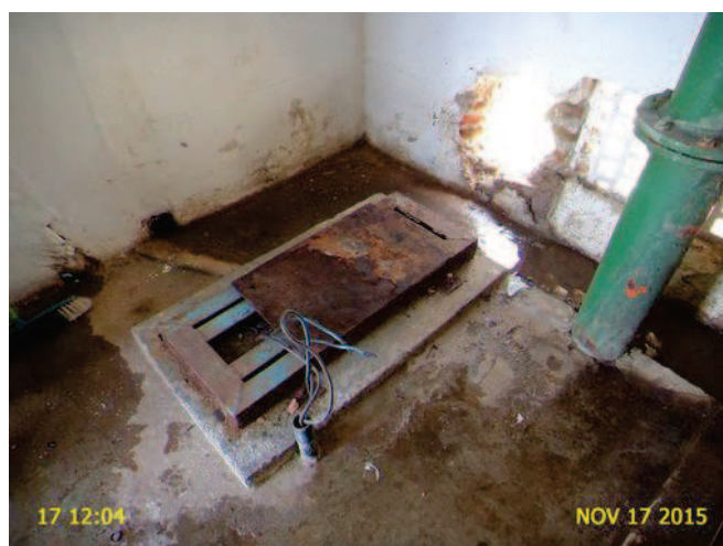
Foto 4 – EEPR-01: CMB necessidade de instalação.
