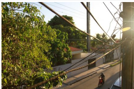
No São João do Tauape, a fiação de energia passa por dentro de uma árvore e está sem isolamento, diz o morador Marcos
