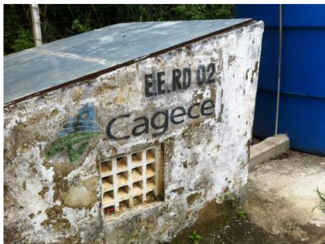
Foto 12 - EERD-02: Pintura deteriorada.
