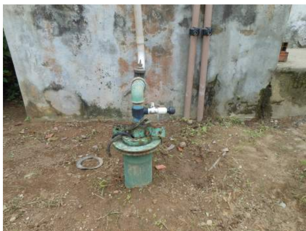
Foto 19 – PT-02: identificação pouco visível.
