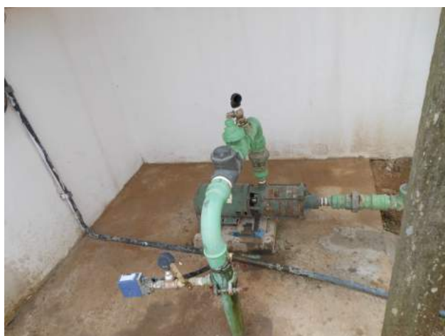
Foto 21 – EEAT-01: identificação pouco visível.
