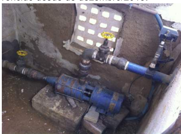
Foto 10 - EERD-02: reboco deteriorado.
