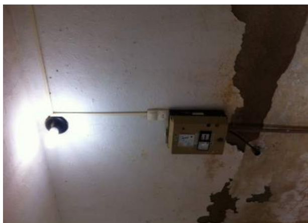
Foto 9 - EERD-01: reboco deteriorado.
