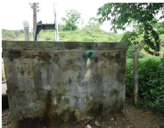
Foto 16 - RAP-04: sem identificação, pintura deteriorada e infiltração.
