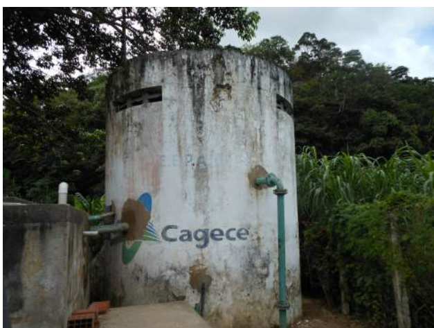
Foto 20 – EEPA-01: identificação pouco visível.
