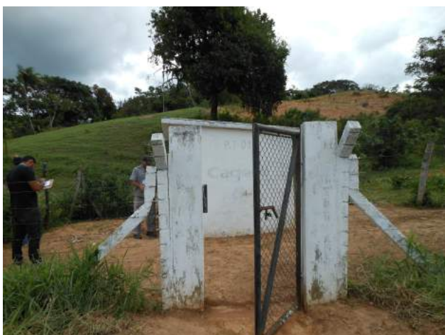
Foto 18 – PT-01: identificação pouco visível.
