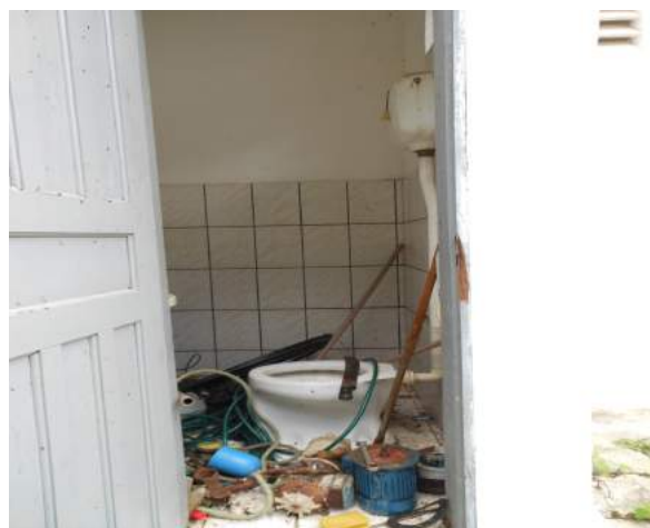
Foto 14 - Banheiro da ETE: encontra-se em mal condição de conservação, servindo como armazenamento de materiais.
