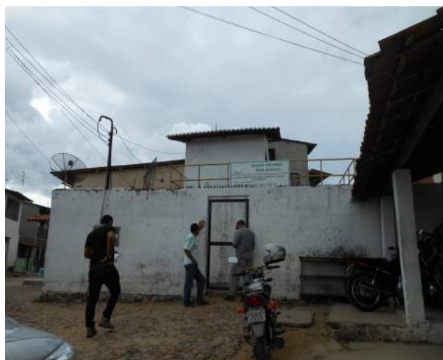
Foto 15 - RAP-01: sem identificação.
