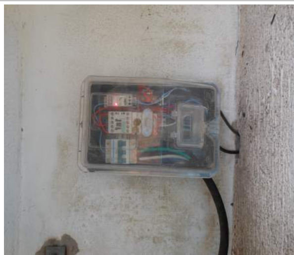
Foto 2 - PT-05: ausência de horímetro.
