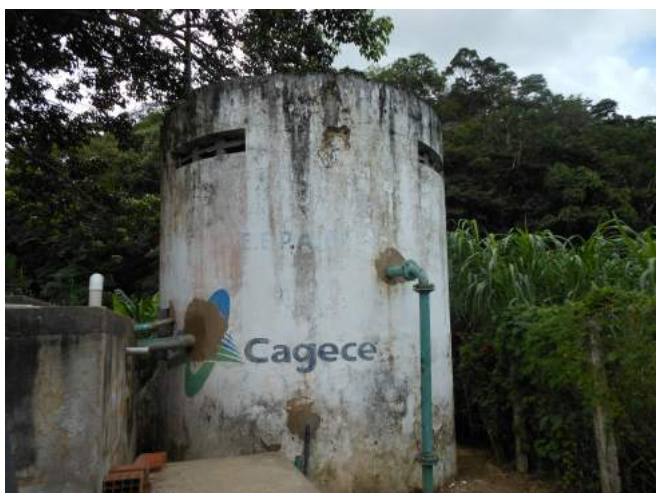
Foto 11 - EEPA-01: pintura deteriorada.
