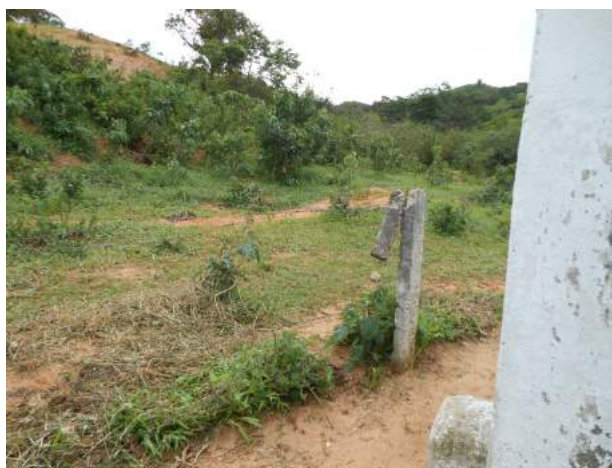
Foto 3 - PT-01: cerca danificada.
