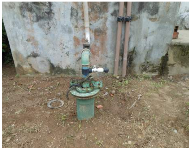
Foto 6 - PT-02: a laje de proteção encontra-se soterrada.
