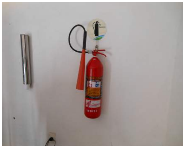
Foto 8 - extintor de incêndio: encontra-se vencido desde de dezembro/2015.
