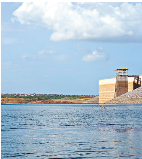
O Açude Castanhão, reservatório que vem salvando Fortaleza do racionamento, possui, atualmente, 9,3% de sua capacidade hídrica ( FOTO: ELLEN FREITAS )
