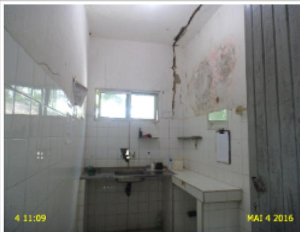
**Foto 14** - ETA: existe rachaduras na parede de laboratório.
