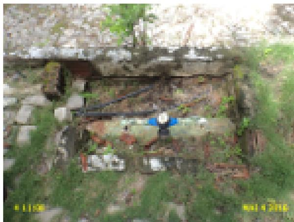
**Foto 22** - RAP-01: caixa sem tampa ou grade na área do Reservatório.
