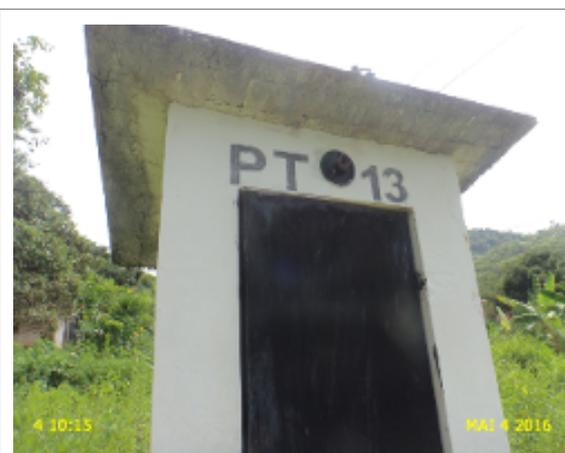
**Foto 01** - PT-13 : ausência de tampa na abertura do poço.
