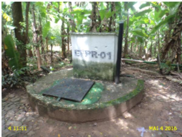
**Foto 35** – EEPR-01: identificação pouco visível e com pintura deteriorada.
