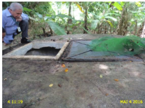
**Foto 40** - Fonte-05: tampa inadequada
