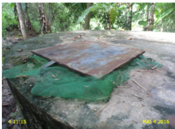
**Foto 39** - Fonte-04: tampa inadequada.
