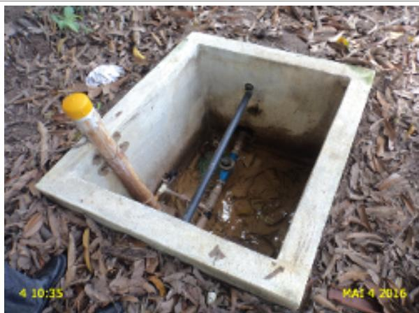
**Foto 25** – PT-15: caixa do medidor da AAB sem tampa ou grade.
