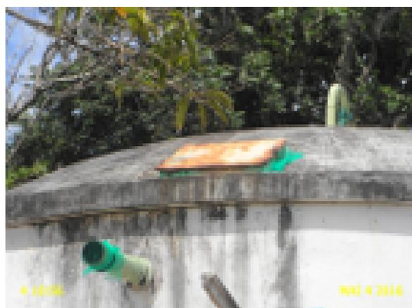
**Foto 20** - RAP-02: tampa 1 em processo de corrosão
