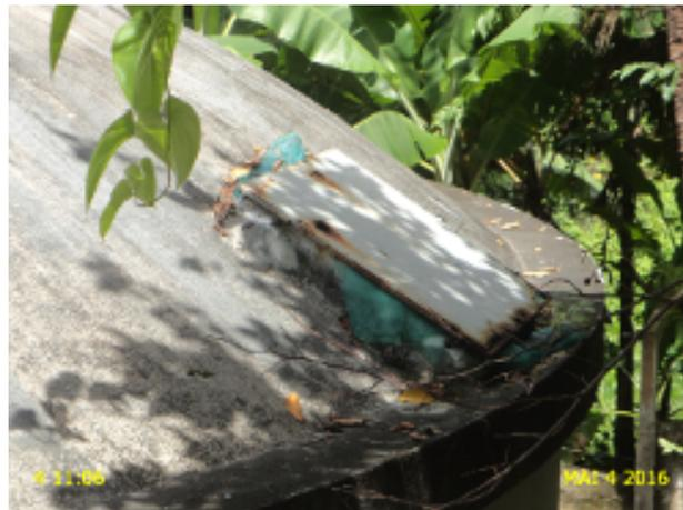
**Foto 18** - RAP-01: tampa 2 em processo de corrosão.
