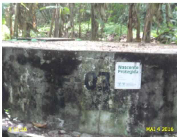
**Foto 28** - Fonte-03: Pintura deteriorada.
