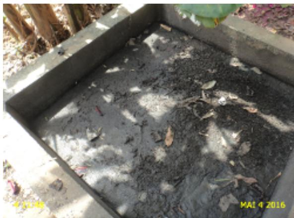
**Foto 17** - EEE-01: leito de secagem necessitando de limpeza.
