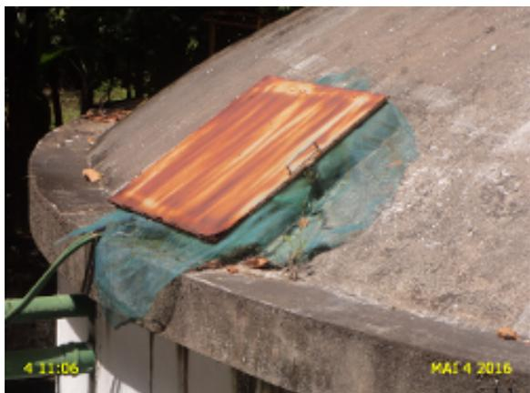
**Foto 19** - RAP-01 - tampa em processo de corrosão.
