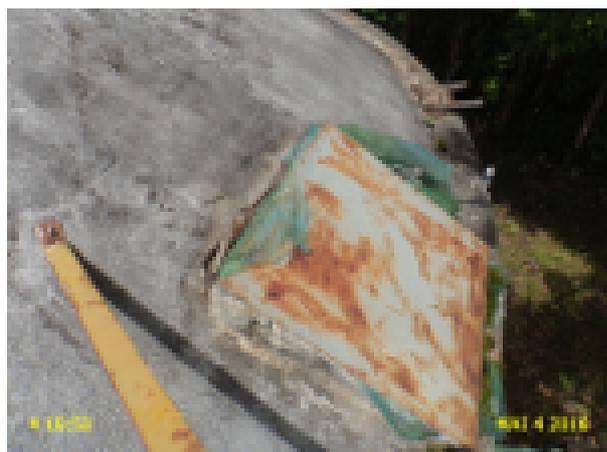
**Foto 21** - RAP-02: tampa 2 em processo de corrosão.
