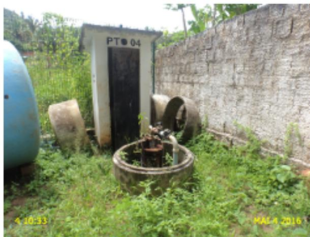
**Foto 09** - PT-04: área tomada por vegetação e sem placa de identificação.
