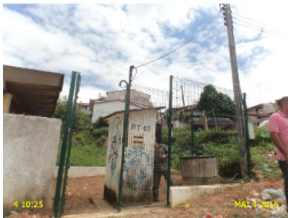
**Foto 11** - PT-03: área sem placa de identificação e pintura deteriorada.
