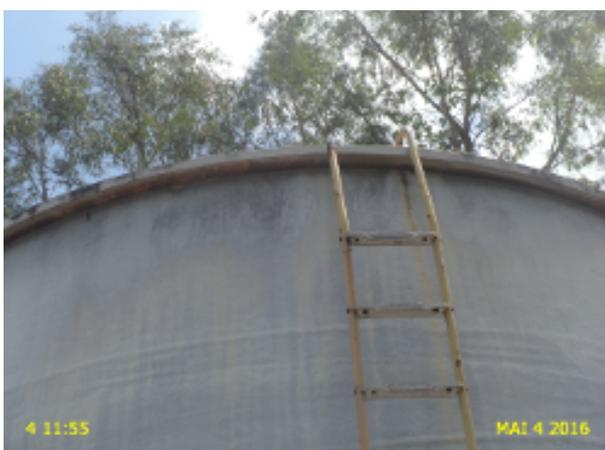
**Foto 34** - ETE: reator uasb com escada danificada.
