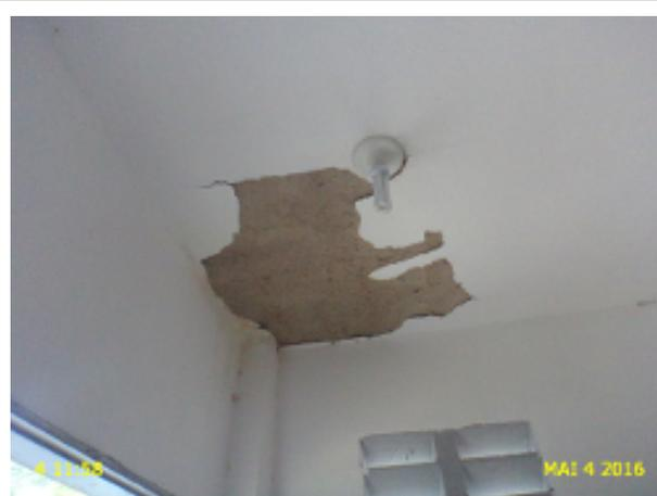
**Foto 32** - ETE: casa dos sopradores com reboco deteriorado.
