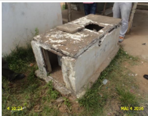
**Foto 27** - PT-02: Identificação apagada porta sem fixação adequada e pintura deteriorada.
