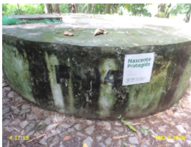
**Foto 29** – Fonte-04: pintura deteriorada.
