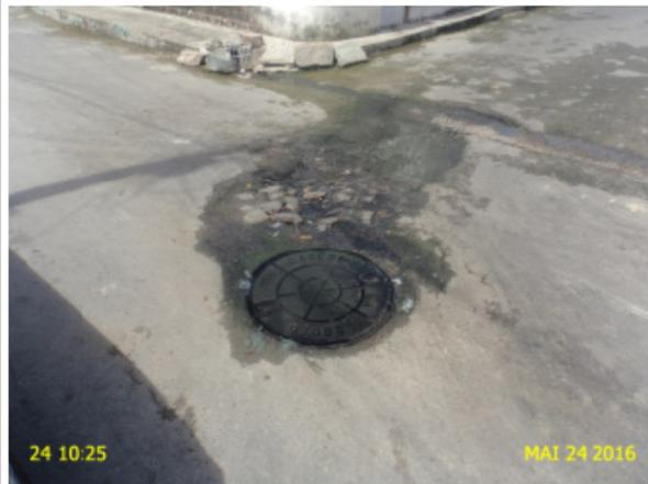
**Foto 06** - Extravasamento de esgoto na Travessa Francisca Castro dos Santos.
