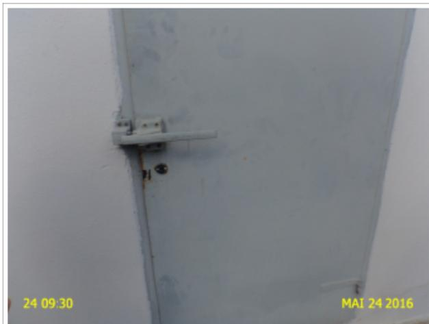
**Foto 07** - EEE-10: fechadura da porta da casa do grupo gerador de energia elétrica danificada.
