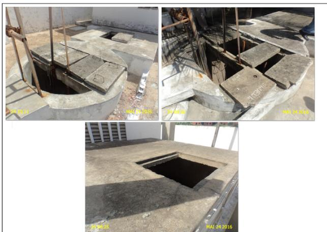
**Foto 13** - EEE-03, EEE-07 e EEE-10: poços de sucção sem tampas adequadas.
