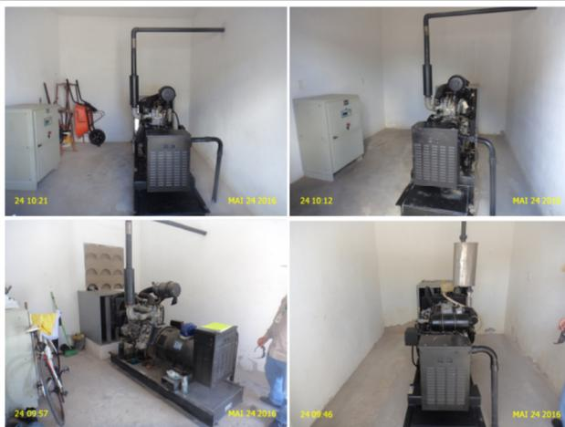
**Foto 08** - EEE-02, EEE-03, EEE-07 e EEE-09: grupo gerador de energia elétrica sem óleo diesel.
