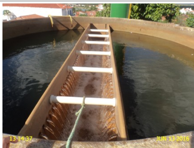
Foto 2 – Filtro F-02: ausência de tampa.
