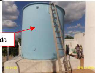
Foto 5 – Filtro F-02: escada sem fixação adequada na estrutura.
