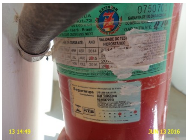
Foto 6 – EEAT-01: validade da carga maio/2015.
