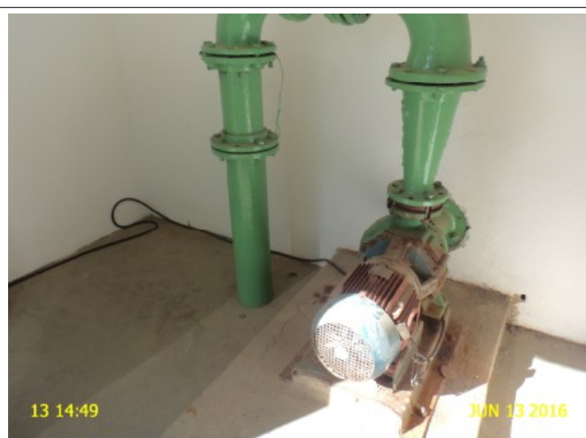
Foto 1 – EEAT-01: ausência de bomba reserva.
