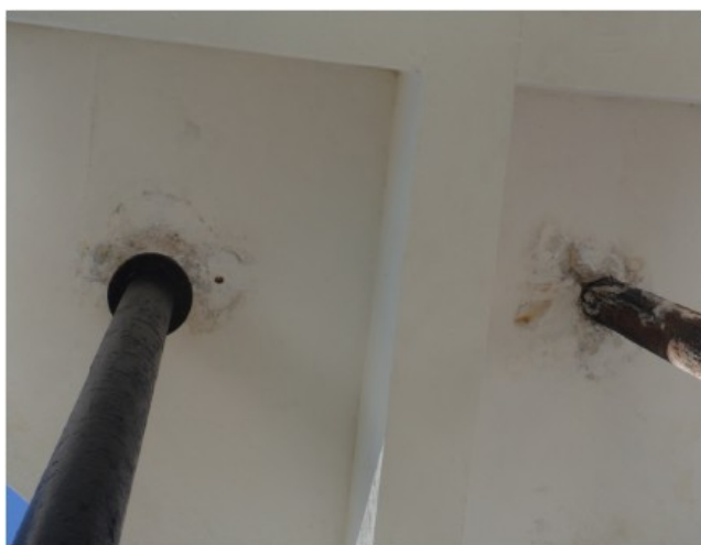
Foto 4 – REL-01: sinais de vazamento.
