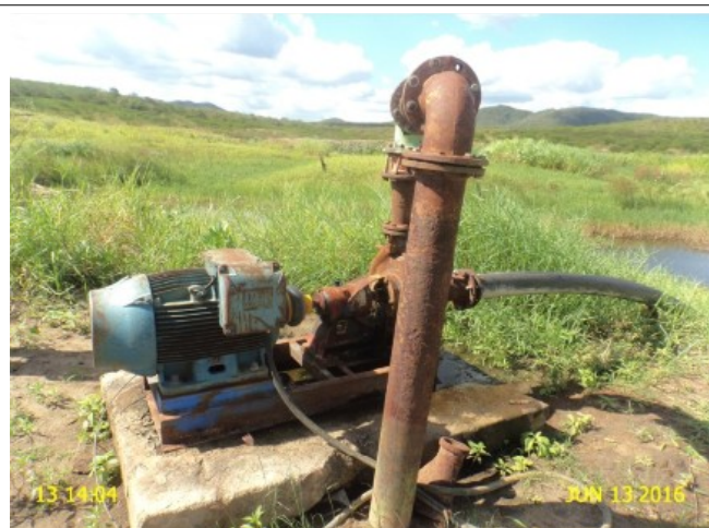
Foto 3 – EECS-01: ausência de bomba reserva.
