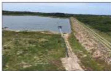
CAPTAÇÃO AÇUDE MALCOZINHADO
