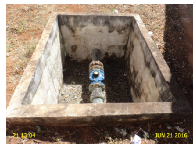
Foto 13 - REL-01: caixa de inspeção sem tampa ou grade protetora.
