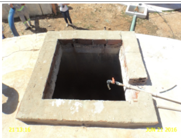
Foto 6 - RAP-03: sem tampa de inspeção.
