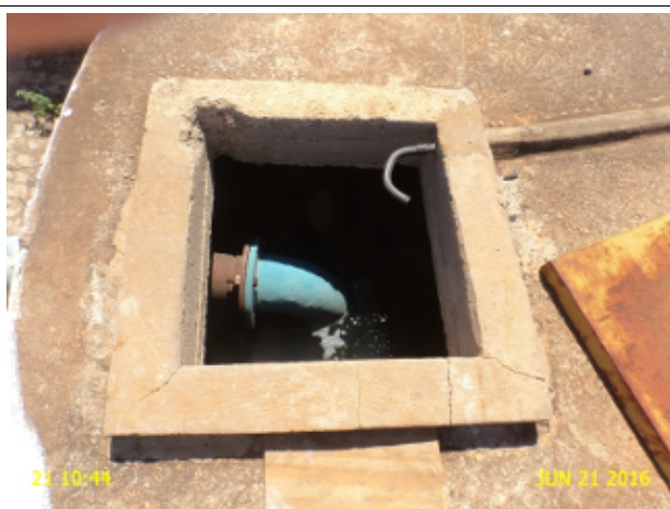
Foto 5 - RAP-02: tampa de inspeção fora do local.
