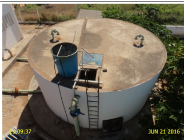
Foto 4 - RAP-01: sem tampa de inspeção.
