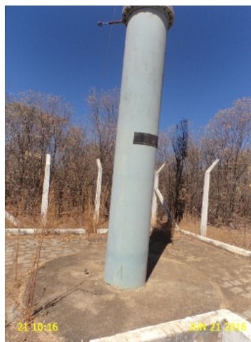
Foto 20 - AAT/Torre de equilíbrio: para-raios sem aterramento.
