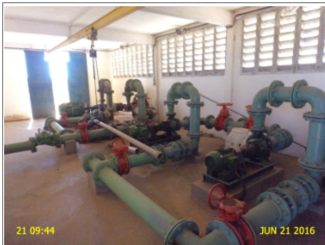
Foto 3 - EEAT-01: sem bomba reserva instalada.
