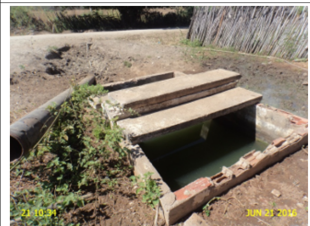
Foto 18 - AAT/Chafariz-02: caixa do medidor proporcional alagada.
