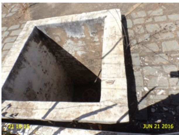
Foto 19 - AAT/Torre de equilíbrio: caixa de inspeção sem tampa ou grade protetora.
