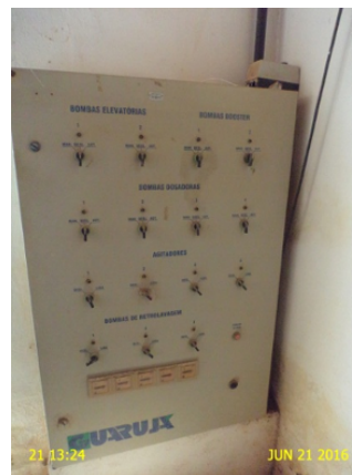
Foto 12 - EEAT-03: Quadro de comando sem amperímetro e voltímetro instalados.
