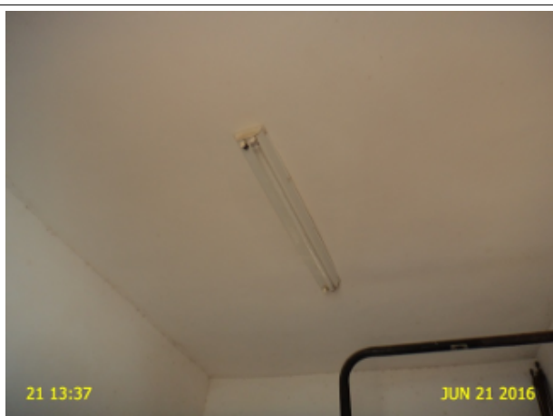
Foto 9 - EEE-01: iluminação da casa de abrigo do grupo gerador de energia elétrica com defeito.
