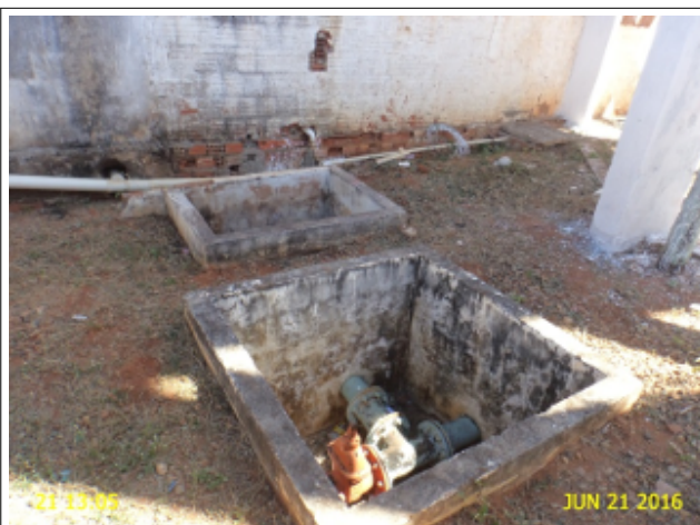
Foto 14 - REL-01: caixa de inspeção sem tampas ou grades protetoras.
