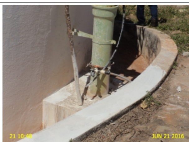
Foto 8 - RAP-02: clorador de pastilha com defeito.
