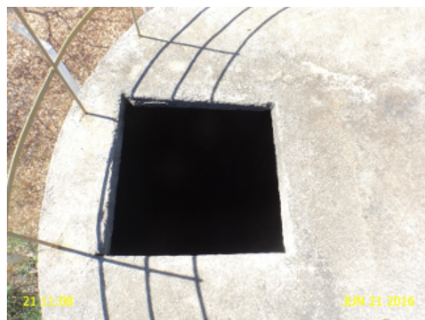
Foto 24 - AAT/CP-02: sem tampa de inspeção.
