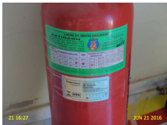
Foto 11 - Comercial/Loja de Atendimento: extintor com data de validade da recarga vencida.
