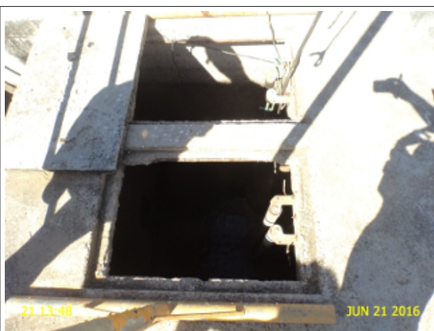
Foto 2 - EEE-02: sem bomba reserva instalada.
