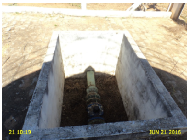
Foto 23 - AAT/CP-01: caixa do medidor proporcional sem tampa ou grade protetora.
