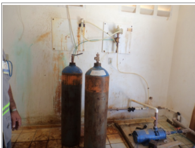
Foto 1 - ETA/Casa de Química: bomba de dosagem instalada na área de armazenamento dos cilindros.
