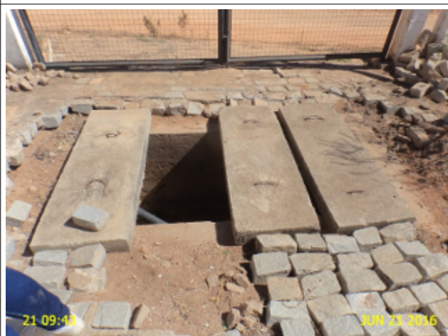
Foto 16 - ETA/Pátio Externo: caixa de inspeção sem tampa ou grade protetora.
