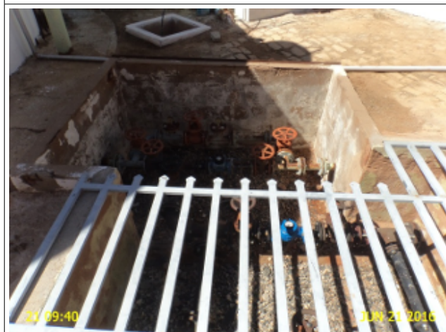
Foto 15 - ETA/Pátio Externo: caixa de inspeção sem tampa ou grade protetora.
