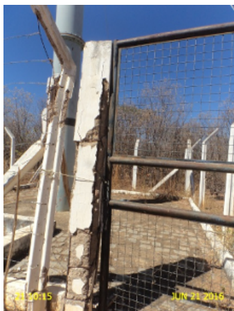
Foto 21 - AAT/Torre de equilíbrio: cerca danificada.
