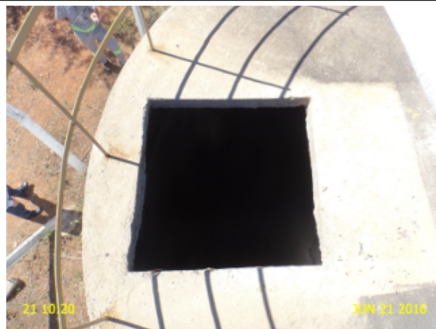
Foto 22 - AAT/CP-01: sem tampa de inspeção.
