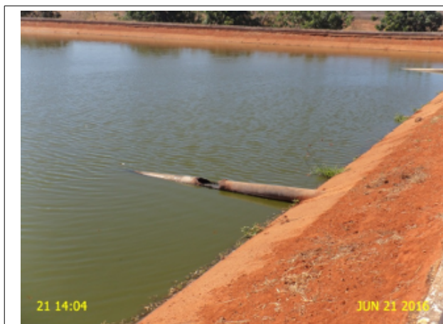
Foto 7 - ETE: tubulação de chegada do esgoto danificada.
