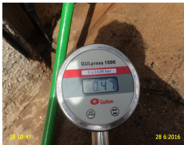
Foto 2 – RDA: Medição de pressão instantânea na rede de distribuição – Rua Cesário, nº 176 – Centro.
