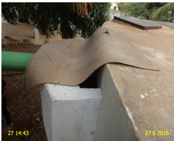
Foto 19 – RAP-01: Tampa de inspeção inadequada.
