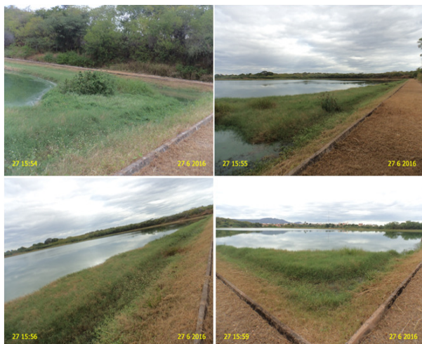
Foto 9 – ETE: Excesso de vegetação dentro da lagoa facultativa.
