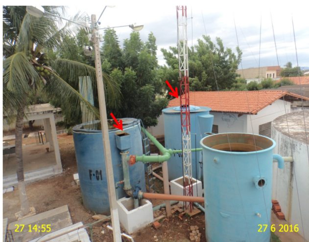
Foto 6 – ETA: Ausência de tampa no filtro F-02 e na calha de saída do F-01.
