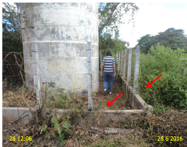
Foto 20 – REL-03: Cerca de delimitação danificada.
