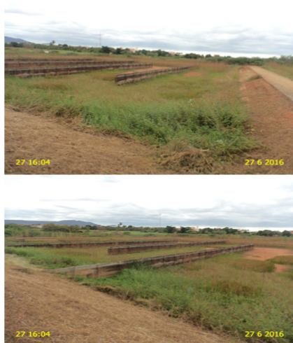
Foto 11 – ETE: Excesso de vegetação na área da lagoa de maturação LM2.
