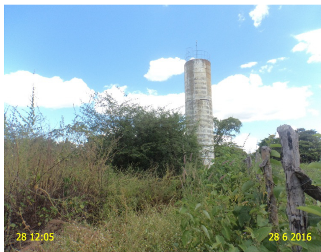
Foto 18 – REL-03: Vegetação excessiva, pintura deteriorada e ausência de identificação.
