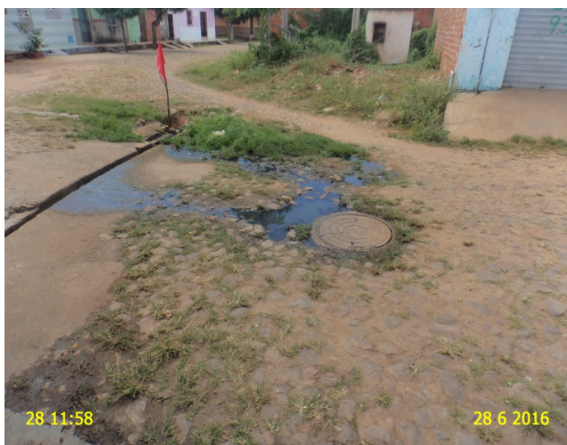
Foto 24 – Esgoto à céu aberto na Rua Lourenço Pereira com Prefeito Gerardo Azevedo.
