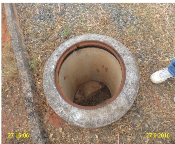
Foto 15 – ETE: Ausência de tampa no poço de inspeção da lagoa de maturação LM2.
