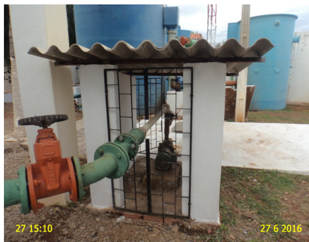
Foto 5 – EEAT-02: Ausência de bomba reserva e identificação.
