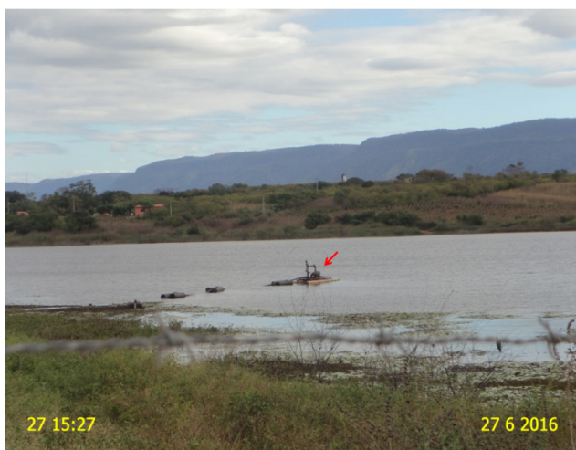
Foto 4 – EECS-01: Ausência de bomba reserva e placa de identificação.
