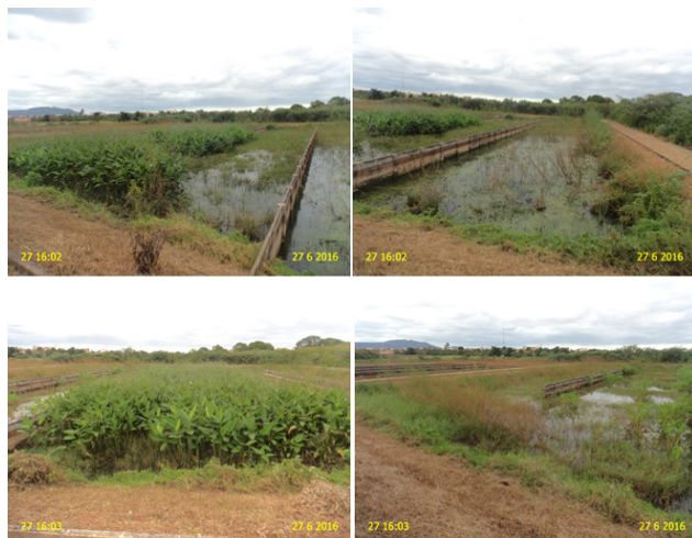
Foto 10 – ETE: Excesso de vegetação dentro da lagoa de maturação LM1.
