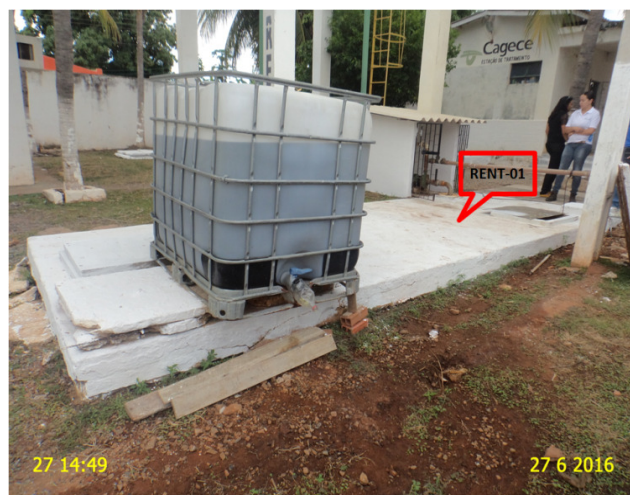
Foto 16 – ETA: Produto químico armazenado ao ar livre e reservatório sem identificação.
