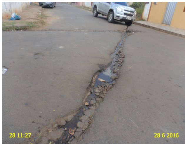
Foto 23 – Esgoto à céu aberto na Rua Lourenço Pereira com Prefeito Gerardo Azevedo.
