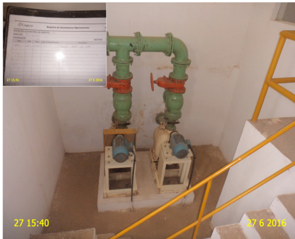
Foto 7 – EEE-01: Bomba reserva com defeito desde o dia 23/04/16.
