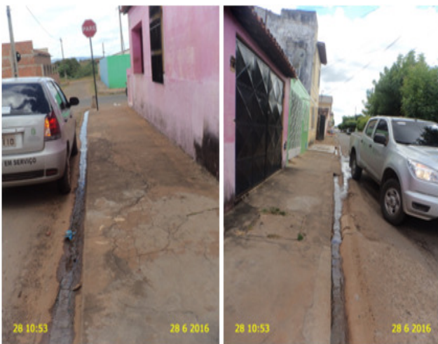
Foto 22 – Esgoto à céu aberto na Rua Raimundo Aquino.
