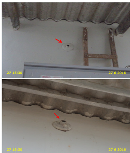
Foto 13 – EECS: Ausência de iluminação.
