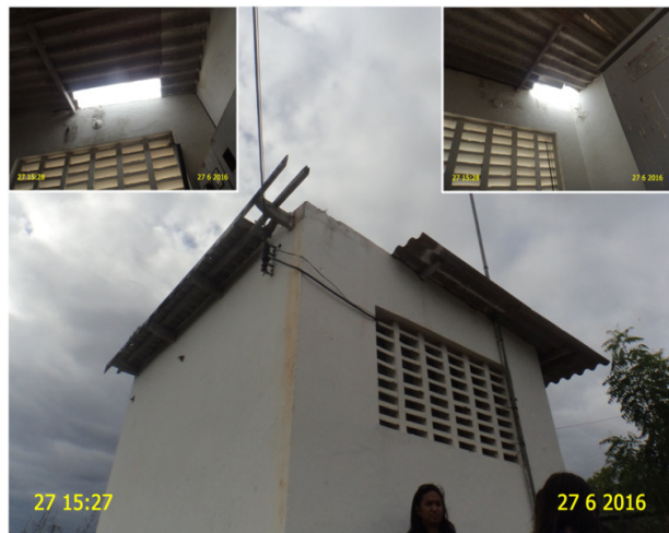
Foto 8 – EECS-01: Casa de abrigo do quadro de comando com telhado danificado.
