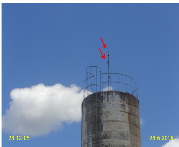
Foto 17 – REL-03: Ausência de sinalizador noturno e para raio danificado.
