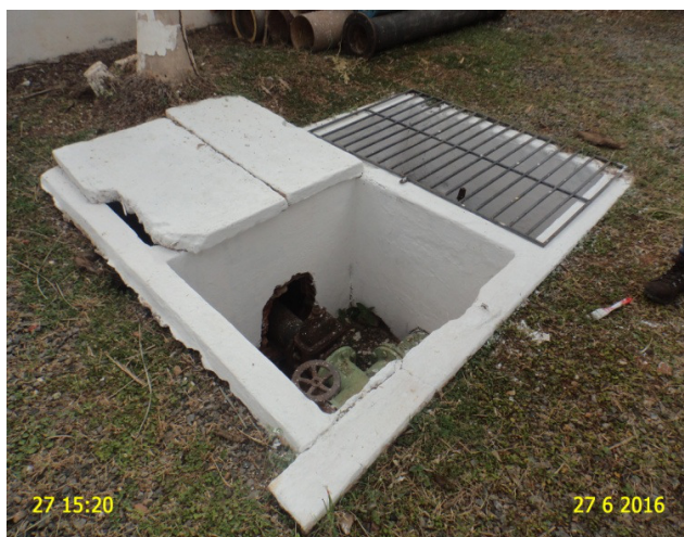
Foto 12 – ETA: Ausência de tampa ou grade na caixa de inspeção.
