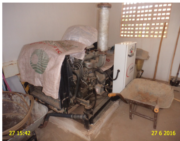
Foto 14 – EEE-01: Gerador de energia elétrica com defeito.
