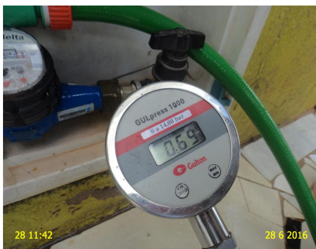
Foto 3 – RDA: Medição de pressão instantânea na rede de distribuição – Rua Gonçalves de Melo Gomes, s/n – Centro.
