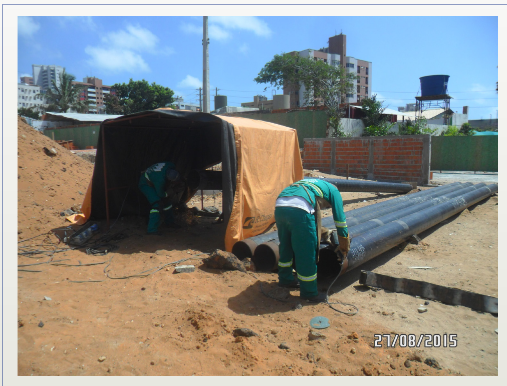
Foto 4. Área de estocagem e preparação de dutos.
