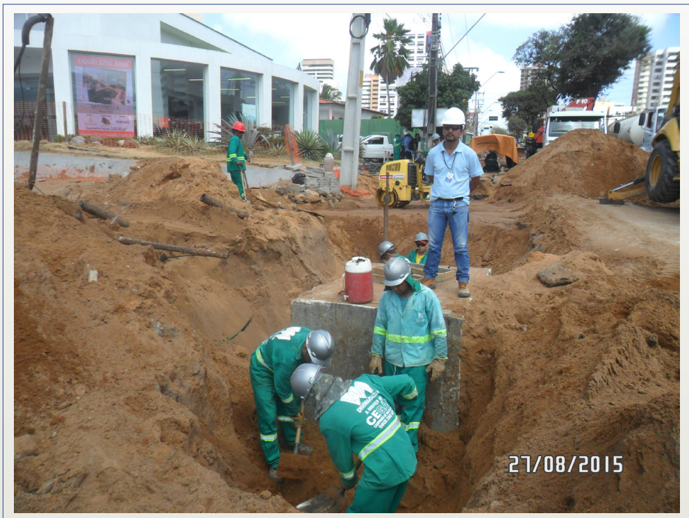
Foto 2. Obra de Construção da Caixa de Válvulas - Av. Engenheiro Santana Júnior com Av. Padre Antônio Tomás
