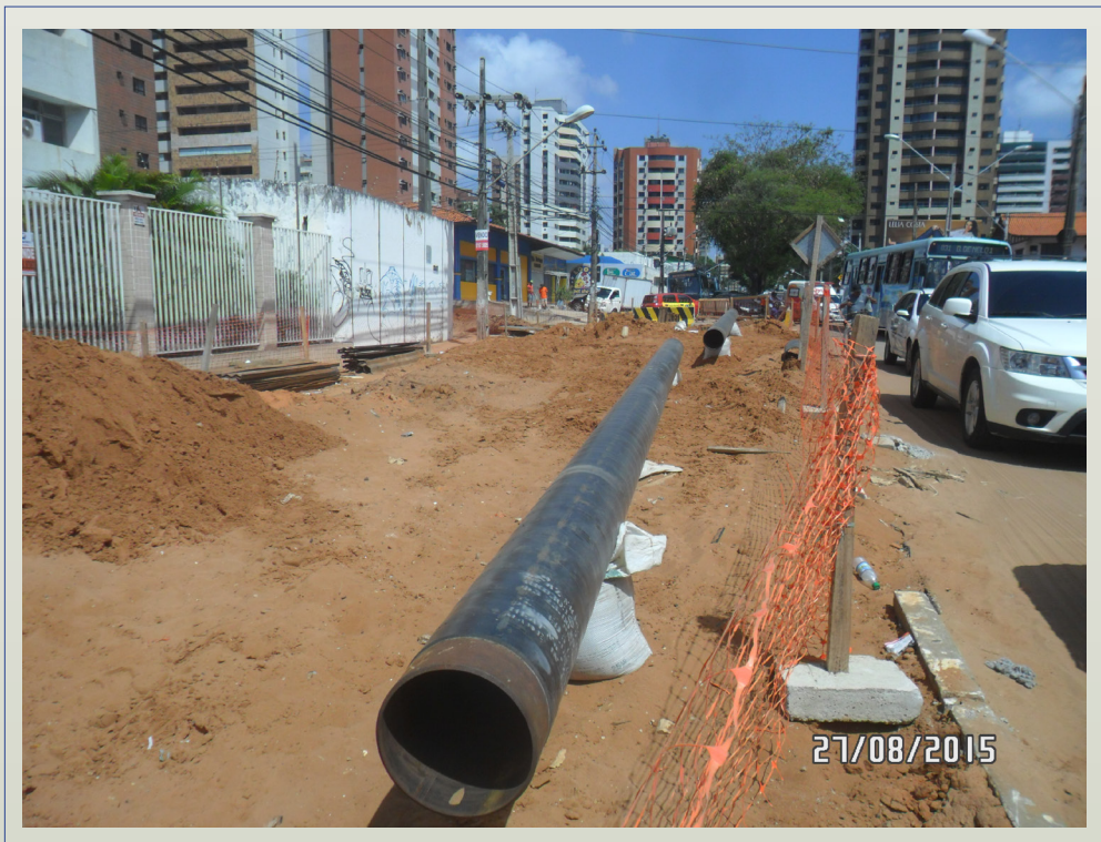
Foto 3. Desfile de Dutos aguardando soldagem, inspeção e lançamento (fixação no subsolo).
