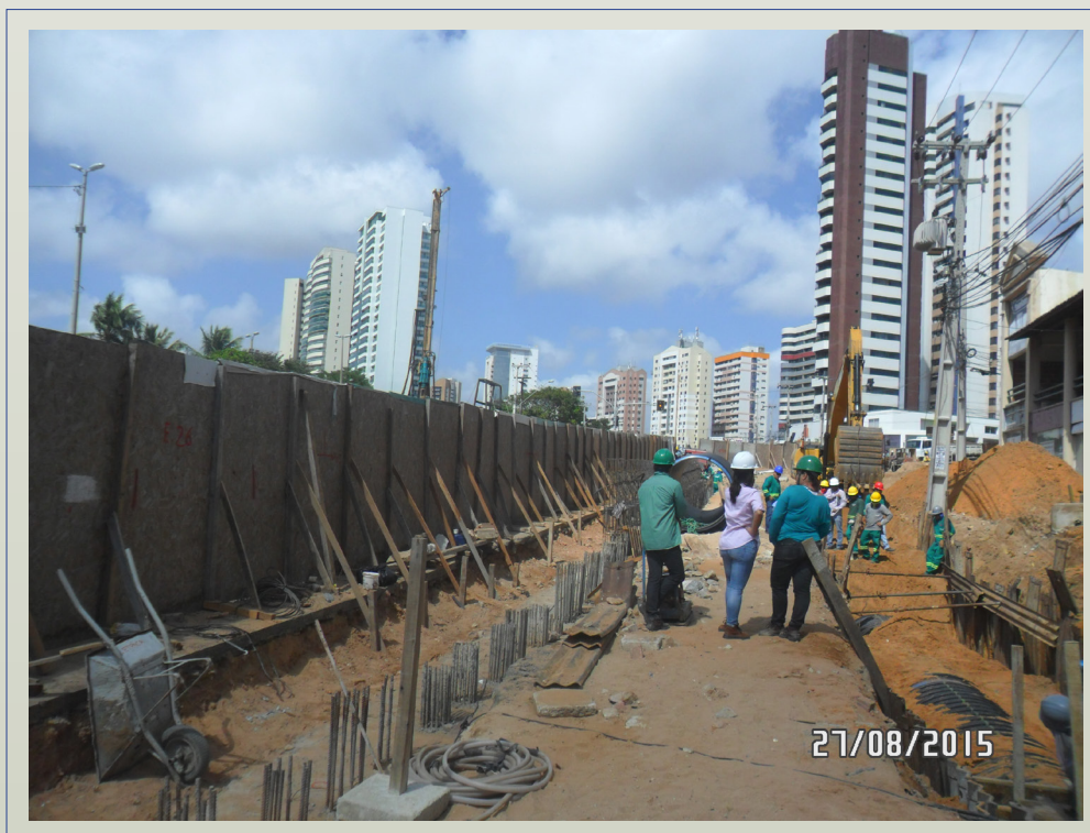
Foto 1. Trecho em Obras da Av. Engenheiro Santana Júnior
