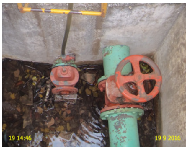
Foto 24 – RAP-02: Registros com vazamento.
