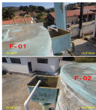
Foto 2 – ETA: Calhas de passagem dos filtros sem tampa.
