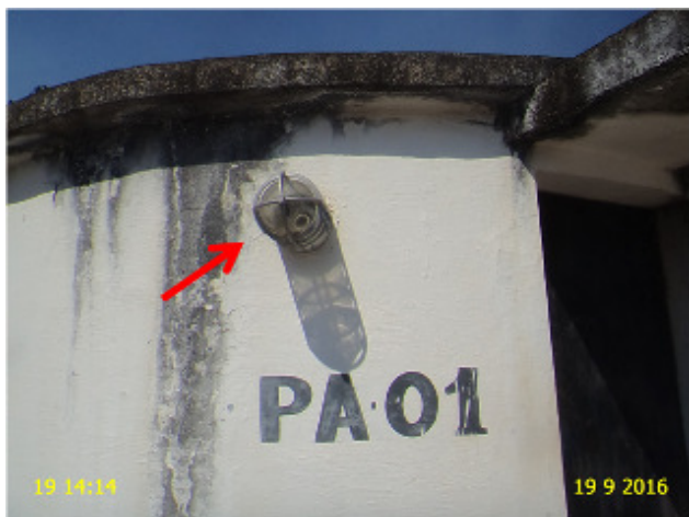
Foto 1 – PA-01: Ausência de iluminação.
