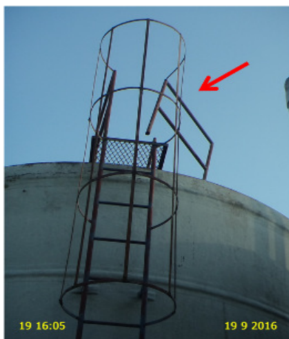
Foto 20 – ETE - Reator aeróbio 02: escada enferrujada e com o guarda-corpo danificado.
