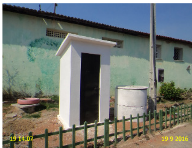
Foto 7 – PT-13: Ausência de identificação.
