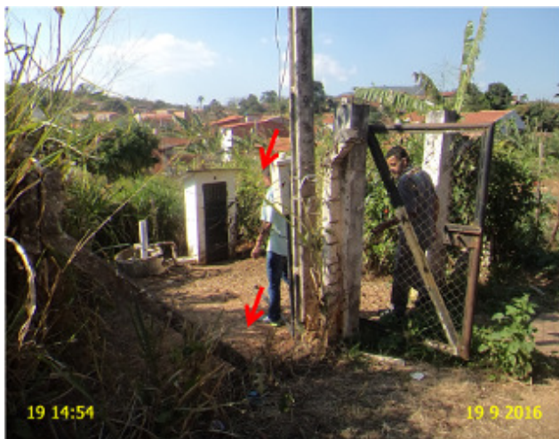
Foto 4 – PT-05: Cerca danificada.
