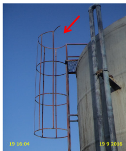
Foto 19 – ETE – Reator aeróbio 01: escada enferrujada e com haste do guarda-corpo danificada.
