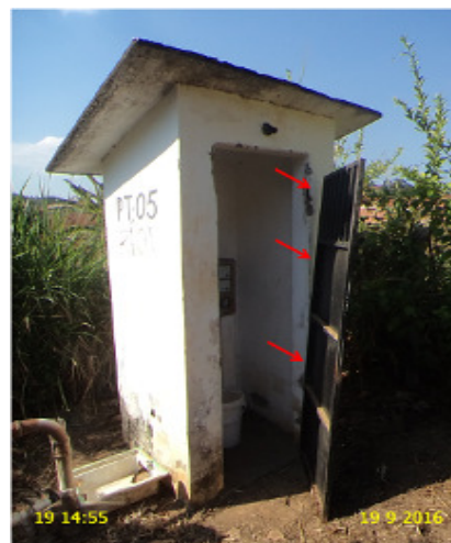
Foto 5 – PT-05: Portão danificado.
