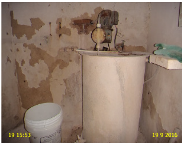
Foto 21 – ETE: Casa de química com estrutura deteriorada.
