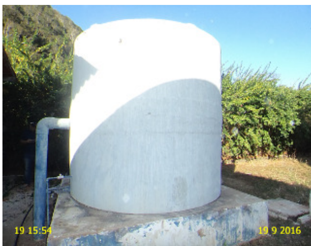
Foto 18 – ETE: Tanque de contato sem identificação.
