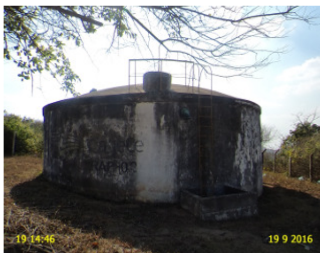
Foto 15 – RAP-02: Identificação pouco visível e pintura deteriorada.
