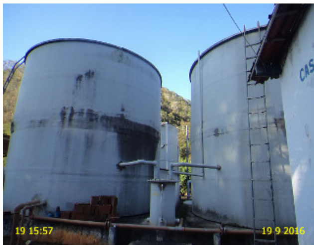
Foto 22 – ETE: Reatores UASB sem identificação.
