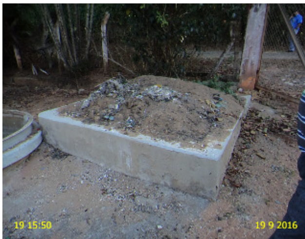
Foto 17 – ETE: Plataforma de secagem necessitando de limpeza.
