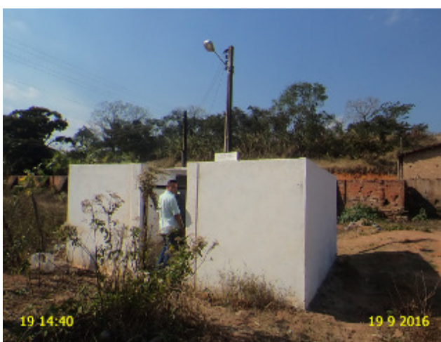
Foto 6 – PT-06: Ausência de identificação.
