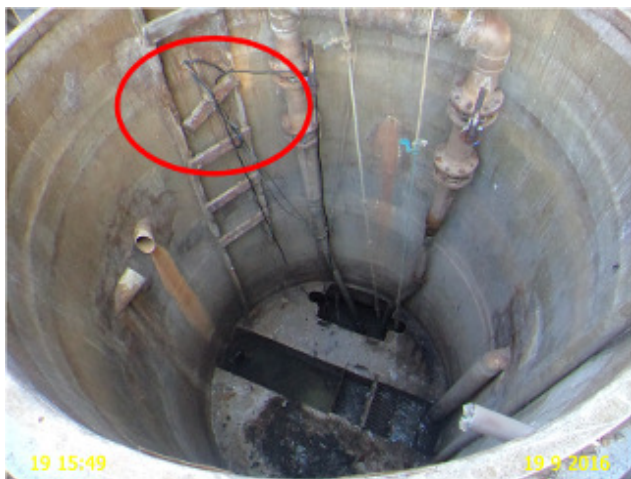
Foto 16 – ETE: Escada de acesso ao poço de sucção danificada.
