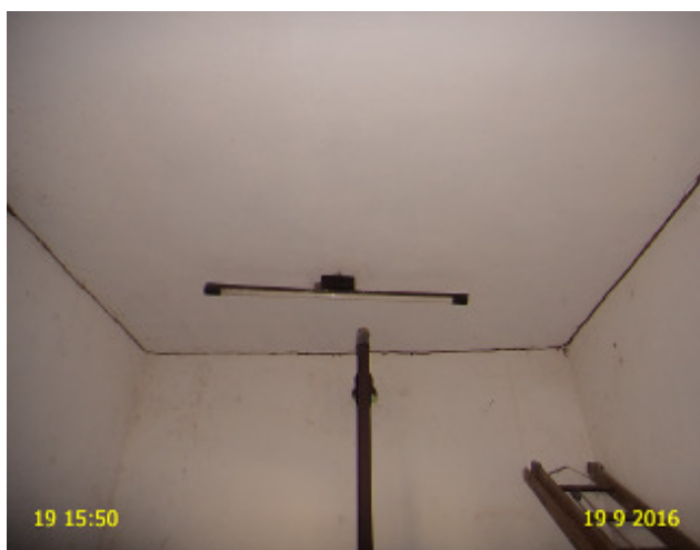
Foto 10 – EEE: A lâmpada da casa do gerador de energia elétrica não ascende.
