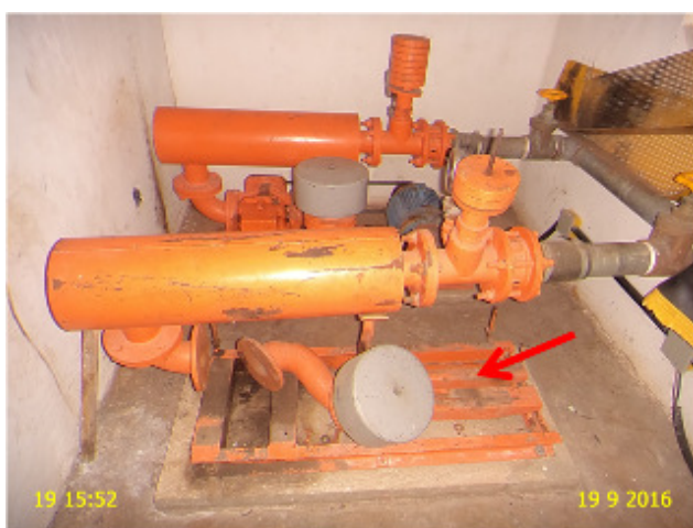
Foto 3 – ETE: Ausência de bomba reserva nos sopradores.
