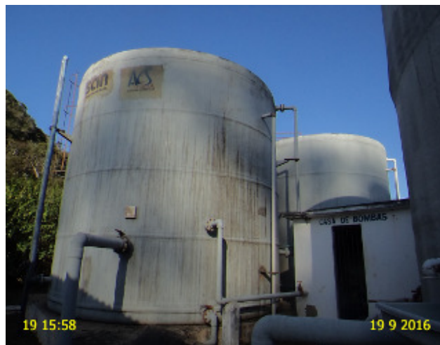
Foto 23 – ETE: Reatores aeróbios sem identificação.
