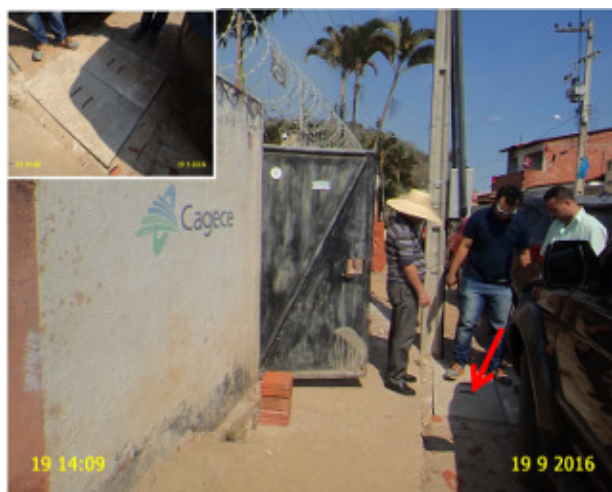
Foto 8 – PT-14: Ausência de identificação.
