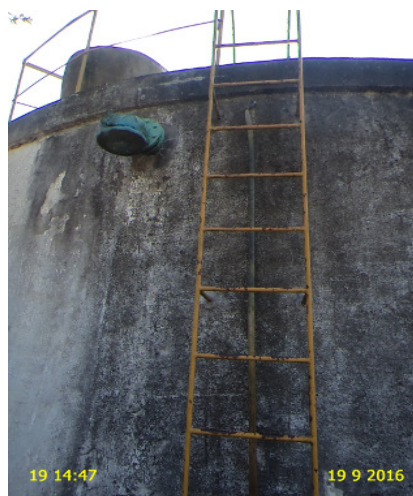
Foto 13 – RAP-02: Escada com pintura deteriorada.
