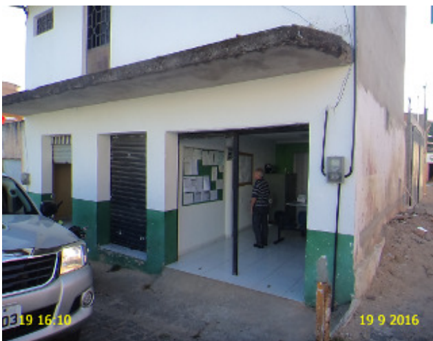
Foto 25 – Escritório de atendimento: ausência de identificação.
