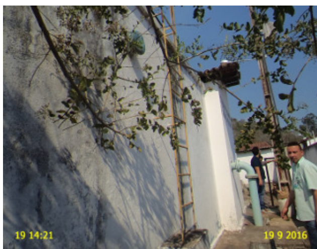
Foto 14 – RAP-01: Ausência de identificação.
