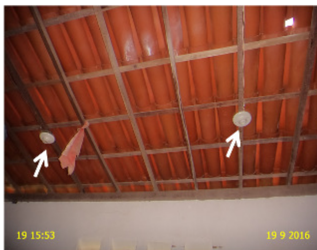
Foto 11 – ETE: Ausência de iluminação na casa de química.
