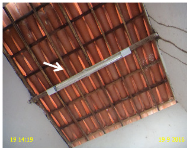
Foto 9 – PT-09: A lâmpada do prédio de abrigo do QC não ascende.
