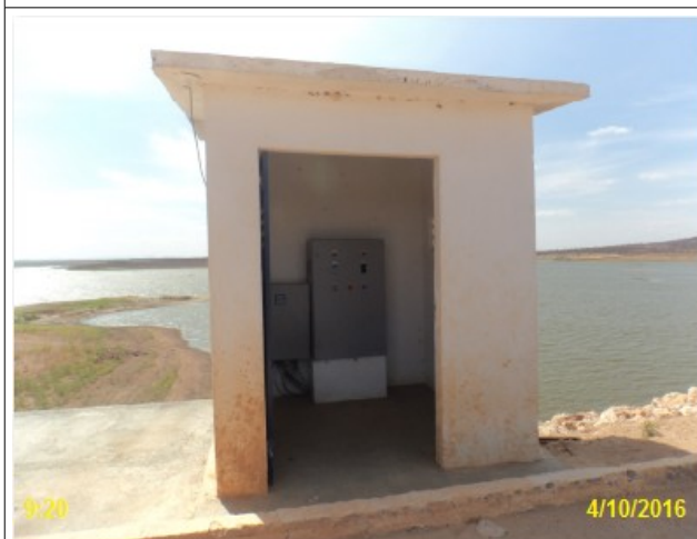
Foto 4 – EECS-02: abrigo do QC sem identificação.
