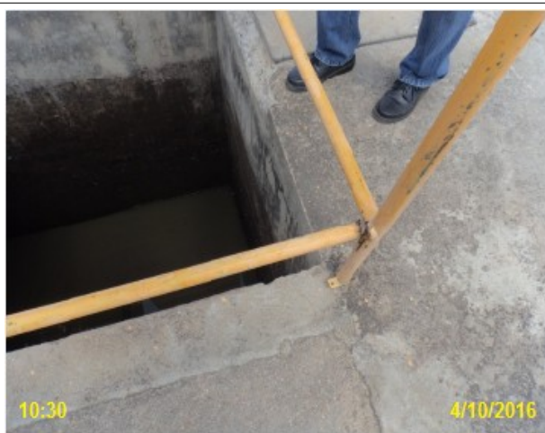
Foto 7 – ETE-01: guarda-corpo danificado.
