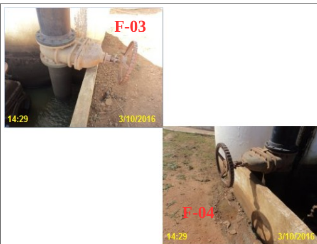
Foto 13 – F-03 e F-04: vazamento nos registros.
