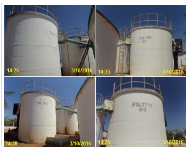
Foto 20 – F-01, F-02, F-03 e F-04: identificação pouco visível.
