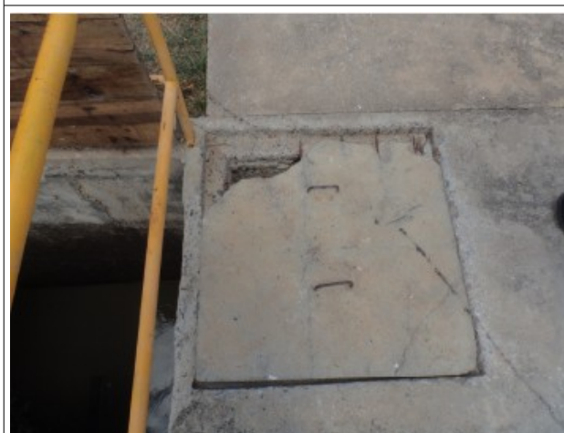
Foto 8 – ETE-01: tampa de inspeção deteriorada.
