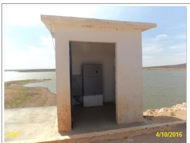
Foto 19 – EECS-01: QC sem identificação de que a captação é destinada para abastecimento público.
