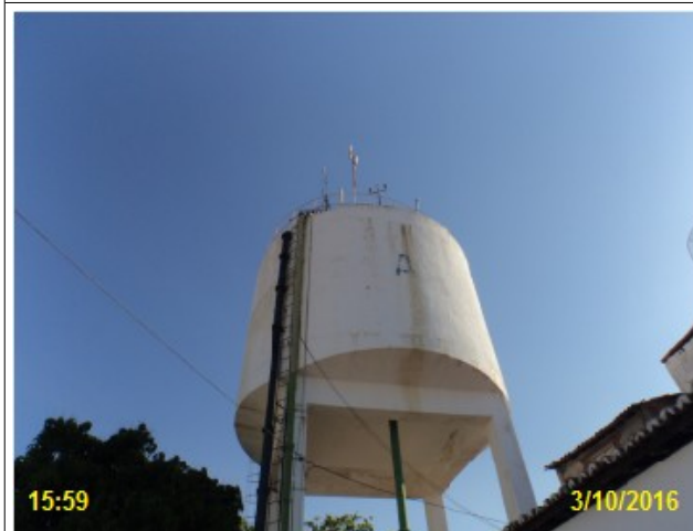
Foto 16 – REL-01: ausência de identificação.
