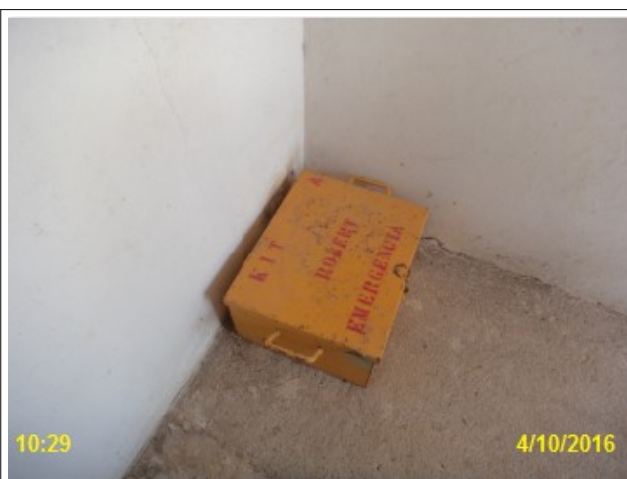
Foto 21 – ETA: KIT de emergência armazenados localizado na EEE-02.
