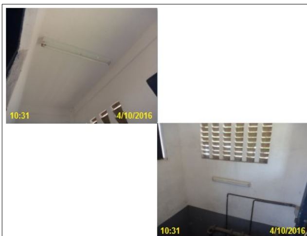
Foto 2 – EEE-02: lâmpadas sem funcionar.
