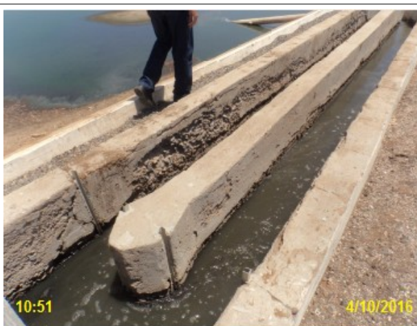
Foto 9 – ETE: caixa de areia com estrutura deteriorada.
