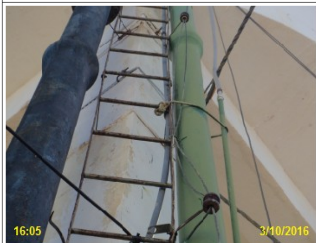
Foto 14 – REL-01: fiação dentro dos isoladores do para raio.
