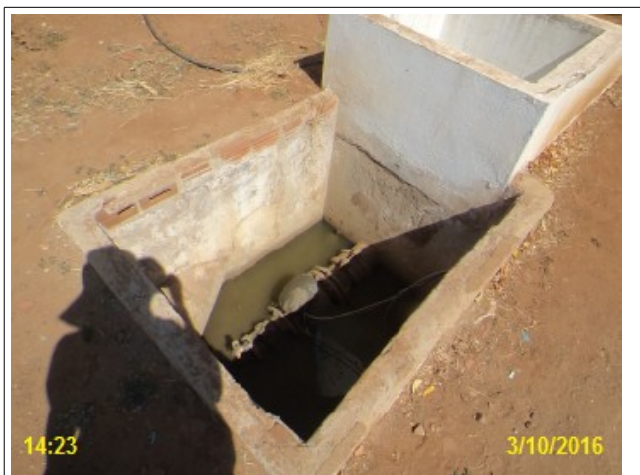
Foto 18 – AAB: caixa de inspeção sem tampa ou grade de proteção.
