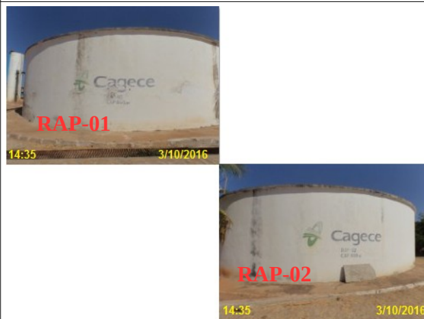
Foto 17 – RAP-01 e RAP-02: identificação com pouca visibilidade e pintura deteriorada.
