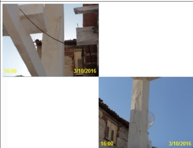
Foto 15 – REL-01: rachaduras na estrutura.
