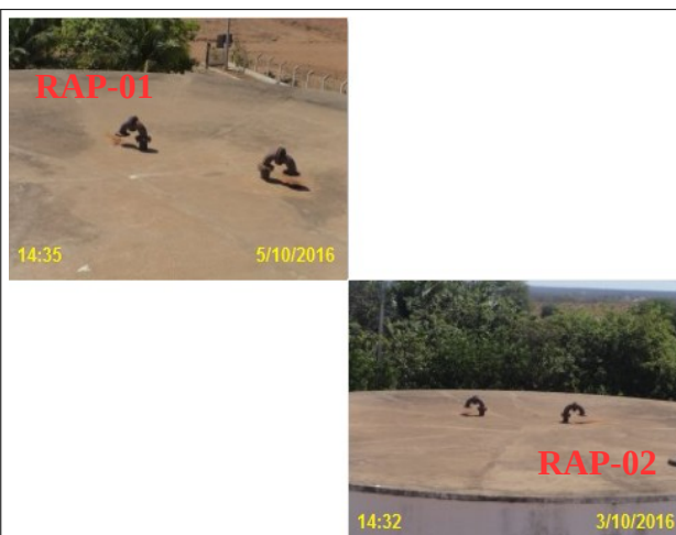
Foto 3 – RAP-01 e RAP-02: tubulações de ventilação sem tela de proteção.
