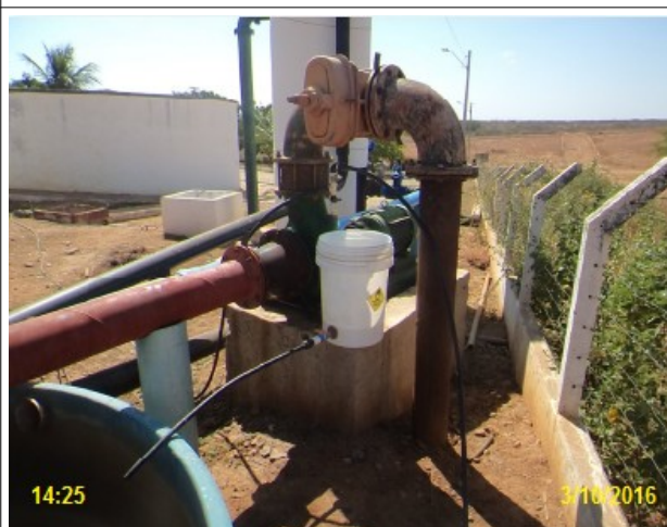
Foto 5 – EEAB-01: ausência de identificação.
