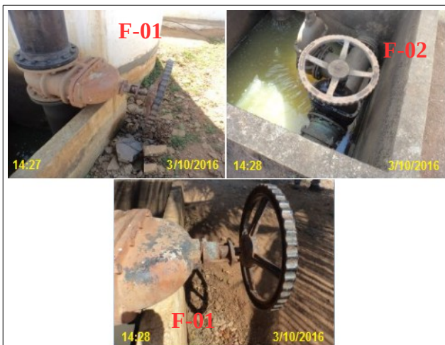
Foto 12 – F-01 e F-02: vazamento nos registros.
