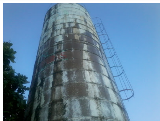
Infiltrações na Estação Elevatória do Sítio Espírito Santo ( Foto Freire Filho)
