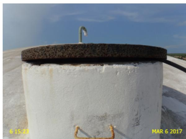
**Foto 7** – RAP-02: tampa de inspeção inadequada e em processo de corrosão.
