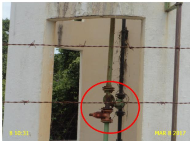
**Foto 2** – REL-02: ausência de medidor de nível.
