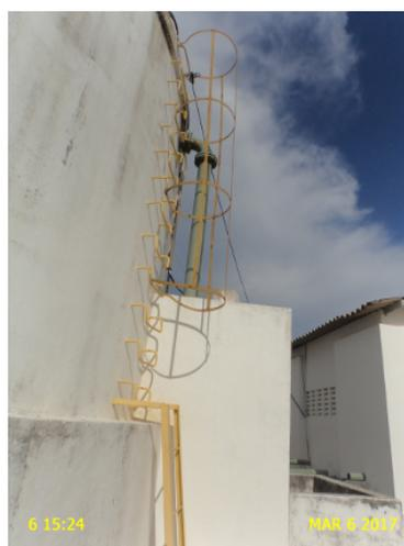
**Foto 15** – RAP-02: escada de acesso em processo de corrosão.
