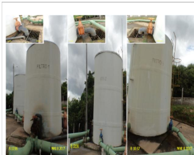
**Foto 10** – Filtros: F-01, F-02 e F-03 com vazamento no registro.
