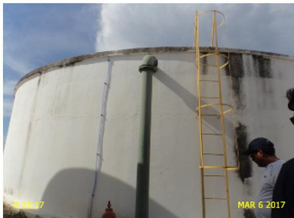
**Foto 16** – RAP-03: escada de acesso em processo de corrosão.
