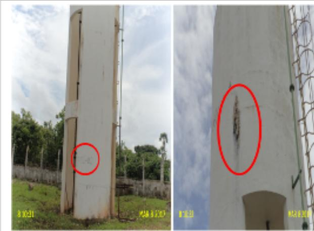
**Foto 22** – REL-02: identificação com pouca visibilidade e sinais de vazamento.
