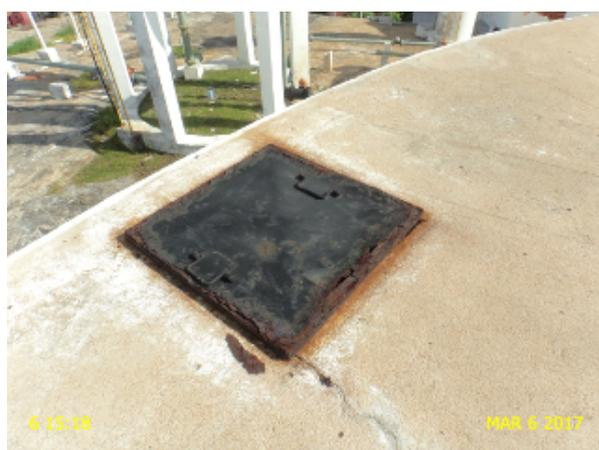
**Foto 8** – RAP-03: tampa de inspeção em processo de corrosão.
