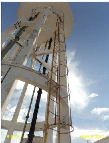
**Foto 18** – REL-03: escada em processo de corrosão.
