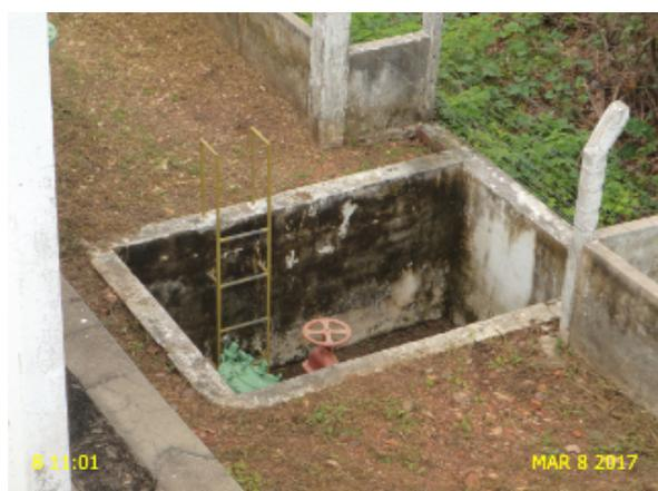
**Foto 6** – ETA: caixa de inspeção sem tampa ou grade de proteção.
