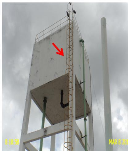
**Foto 17** – REL-01: escada em processo de corrosão
