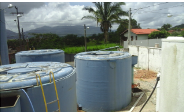
Foto 3 – Filtro F-05: a tampa está danificada não permitindo vedação adequada.
