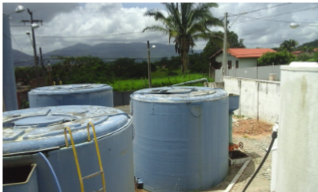
Foto 2 – Filtros F-03 e F-04: as tampas estão danificadas não permitindo vedação adequada.
