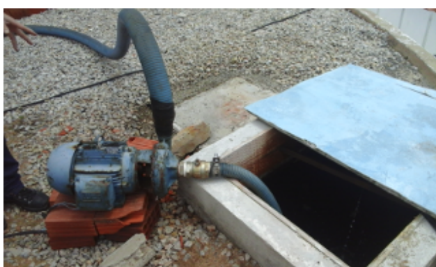
Foto 4 – RAP-01: sucção da bomba e tubulação de cloração estão impedindo a vedação adequada.
