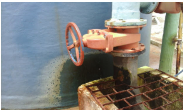
Foto 1 – Filtro F-04: registro apresenta vazamento.
