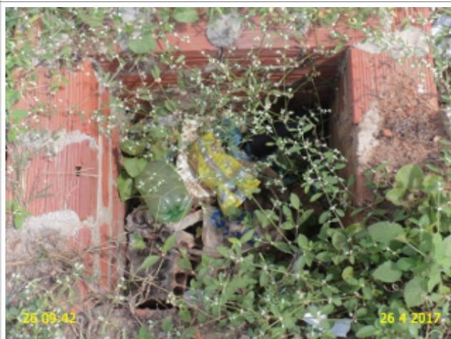
**Foto 30** - Registro de descarga com caixa sem tampa e com acúmulo de lixo: Rua 07 de Setembro.
