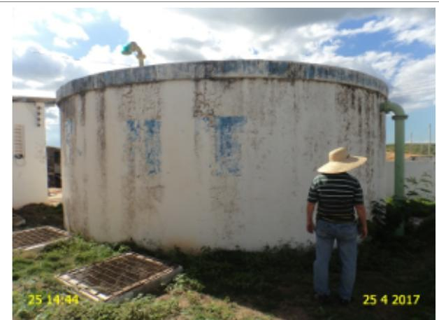
**Foto 18** - RAP-02: pintura deteriorada e identificação pouco visível.
