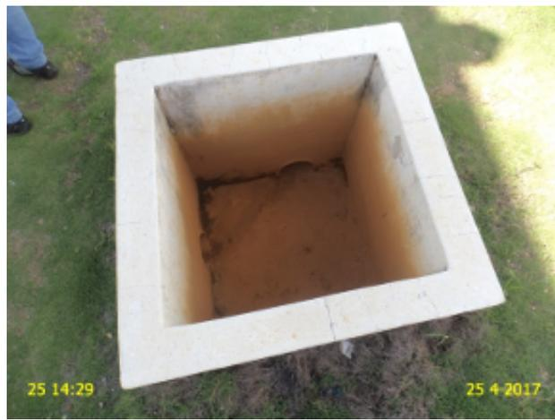
**Foto 14** - ETA: caixa de inspeção ou passagem sem tampa ou grade de proteção.
