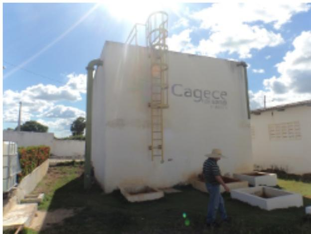
**Foto 10** – Floco-decantador: pintura deteriorada.
