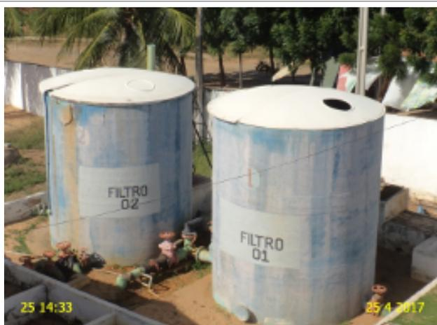
**Foto 4** - Filtros: F-01 sem tampa de inspeção.
