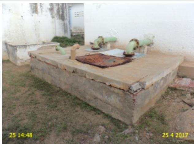
**Foto 17** - REN-01: Sem identificação, pintura deteriorada, tampa em processo de corrosão, tubulação de ventilação sem tela de proteção e rachaduras na laje de cobertura.
