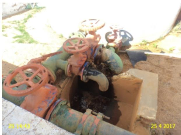
**Foto 11** - Filtros: vazamento no registro do F-02.
