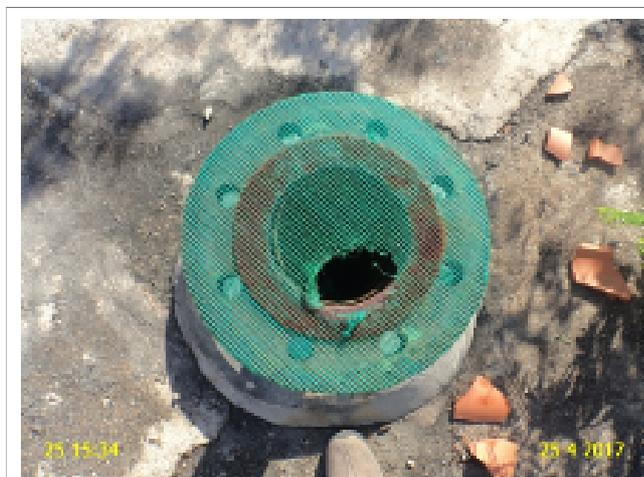
**Foto 7** - RAP-01: a tela de proteção da tubulação de ventilação está danificada.
