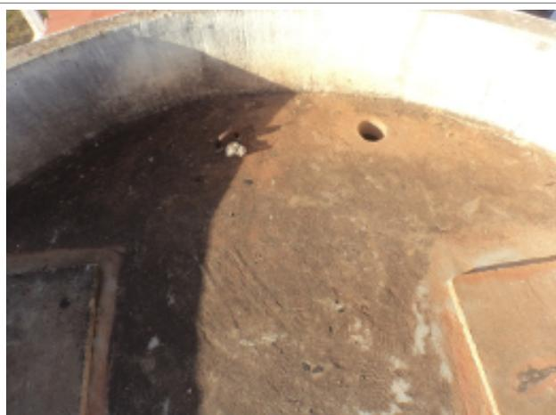
**Foto 6** – RAP-03: sem tubulação de ventilação.
