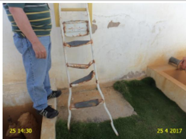
**Foto 24** - Escada de apoio para acesso ao decantador está danificada.
