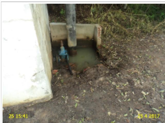
**Foto 21** - RAP-01: caixa de descarga de fundo danificada.
