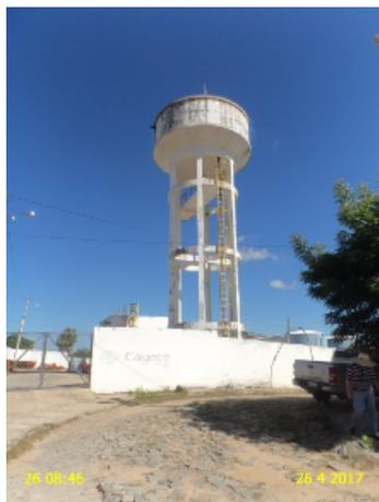
**Foto 15** - REL-01: pintura deteriorada e lâmpada de sinalização noturna de obstáculos danificada.
