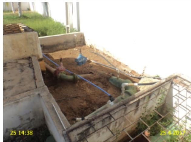
**Foto 13** - ETA: caixa de inspeção/passagem sem tampa ou grade de proteção.
