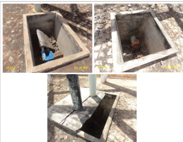
Foto 13 – REL-03 (Sede): caixas sem tampa ou grade de proteção.
