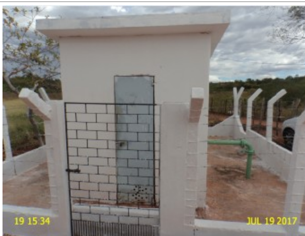
Foto 38 – EEAB-01 (Mangabeira): ausência de identificação e iluminação.
