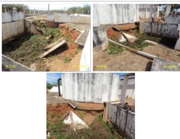
Foto 44 – ETA: desmoronamento do piso da ETGR Desativada.
