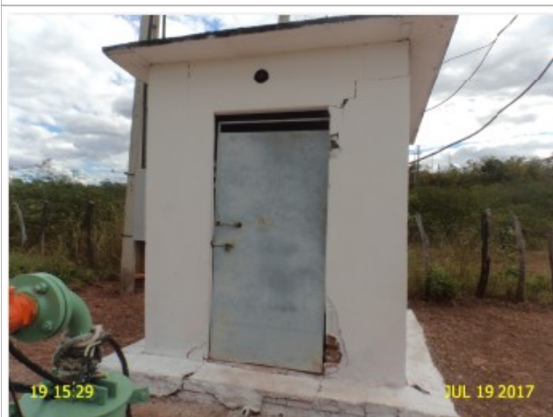
Foto 5 – PT-04 e PT-06 (Mangabeira): estrutura rachada, portão inadequado e ausência de identificação e iluminação para trabalhos noturnos.
