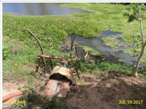
Foto 7 – EECS-01 (Amaniutuba): ausência de bomba reserva.
