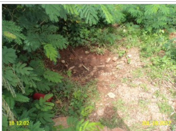
Foto 42 – REL-01 (Quitaiús): evidências de extravasamento.
