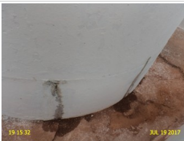
Foto 28 – RAP-01 (Mangabeira): sinais de vazamento.
