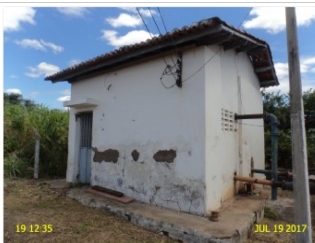
Foto 18 – EECS-01 e EEAB-01 (Amaniutuba) : ausência de identificação, pintura e reboco deteriorados.
