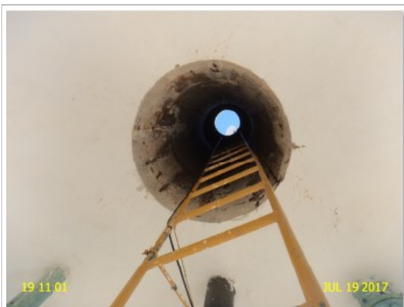
Foto 1 – REL-01 (Amaniutuba): ausência de tampa de inspeção.
