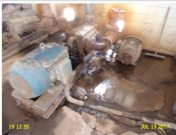
Foto 46 – EEAB-01 (Amanituba): vazamento na gaxeta da bomba.
