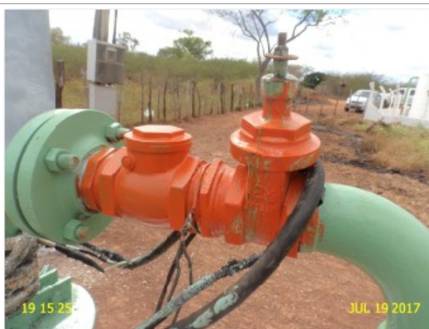
Foto 22 – PT-04 (Mangabeira): vazamento no registro.
