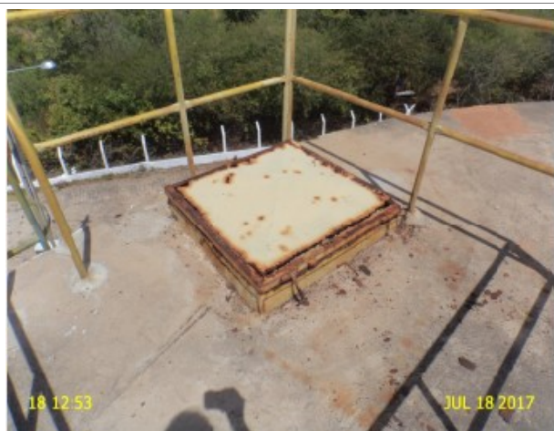
Foto 31 – REL-03 (Sede): tampa de inspeção em processo de corrosão.
