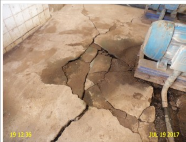
Foto 45 – EEAB-01 (Amanituba): piso deteriorado.
