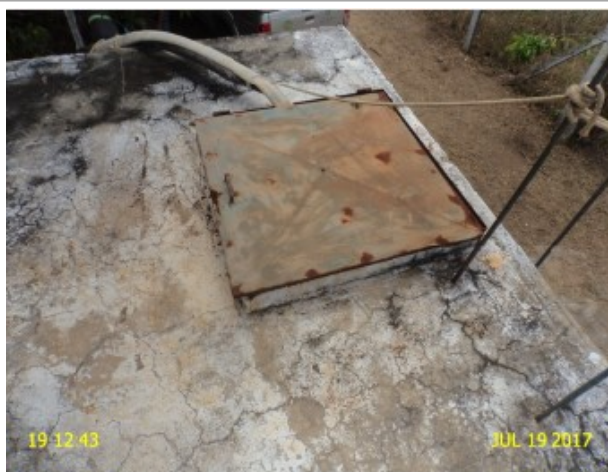
Foto 33 – RAP-01 (Amanituba): tampa de inspeção em processo de corrosão.
