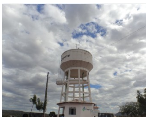
Foto 10 – REL-01 (Mangabeira): ausência de sinalização noturna e para raios.
