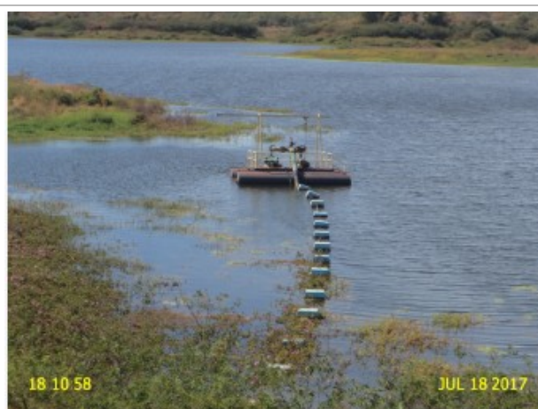
Foto 6 – EECS-01 (Quitaiús): bomba reserva não instalada.
