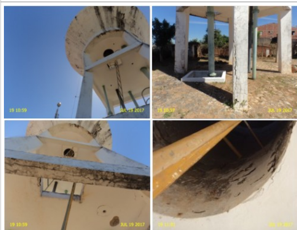
Foto 27 – REL-01 (Amaniutuba): armadura exposta e pintura e reboco deteriorados.
