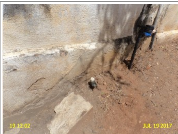
Foto 17 – RDA (Amaniutuba): registro de descarga no Sítio Gado Bravo - Amaniutuba sem caixa.
