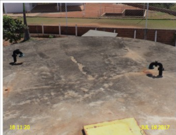
Foto 34 – RAP-01 (Quitaiús): tubulação de ventilação sem tela de proteção.
