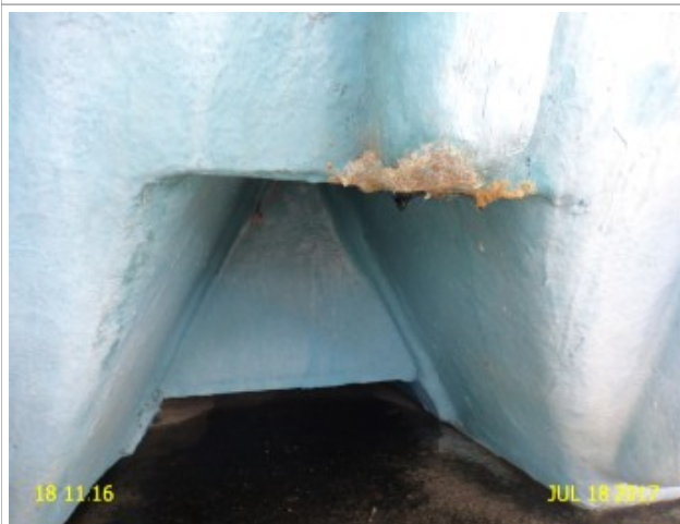
Foto 43 – Decantador 01 (Quitaiús): sinal de vazamento.
