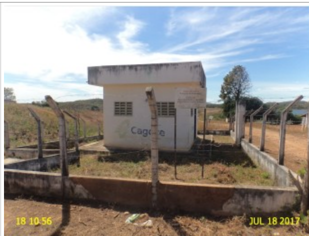
Foto 14 – EECS-01 (Quitaiús): cerca delimitadora danificada.
