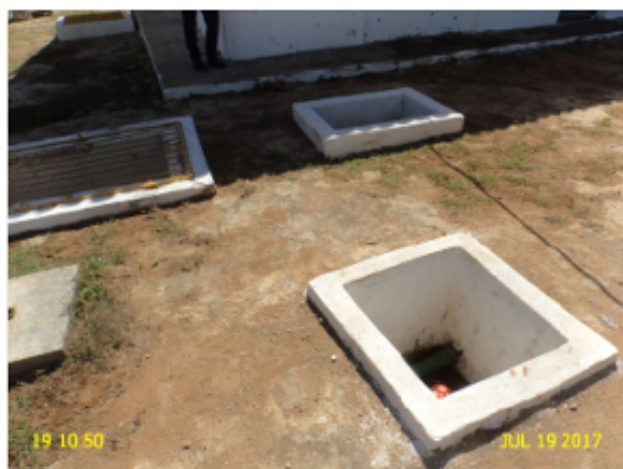
Foto 15 – AAT (Amaniutuba): caixas de inspeção sem tampa ou grade.
