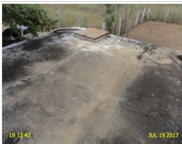
Foto 4 – RAP-01 (Amaniutuba): ausência de tubulação de ventilação.
