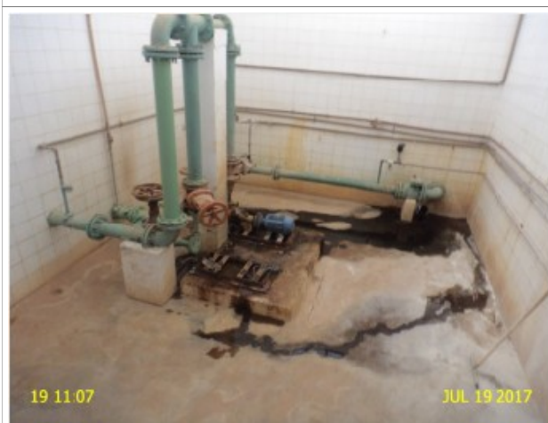
Foto 11 – EEAT-01 (Amaniutuba): ausência de bomba reserva.
