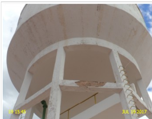
Foto 29 – REL-01 (Mangabeira): reboco deteriorado.
