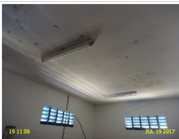
Foto 36 – EEAT-01 (Amaniotuba): lâmpadas sem funcionar.
