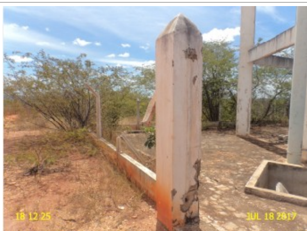
Foto 8 – REL-03 (Sede): cerca de delimitação danificada.
