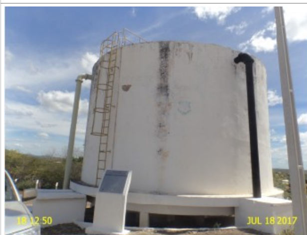
Foto 39 – REL-02 (Sede): pintura deteriorada e ausência de identificação.
