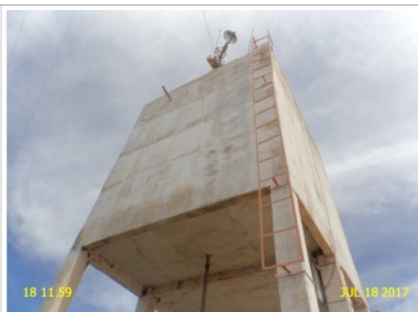
Foto 2 – REL-01 (Quitaiús): escada sem guarda corpo.
