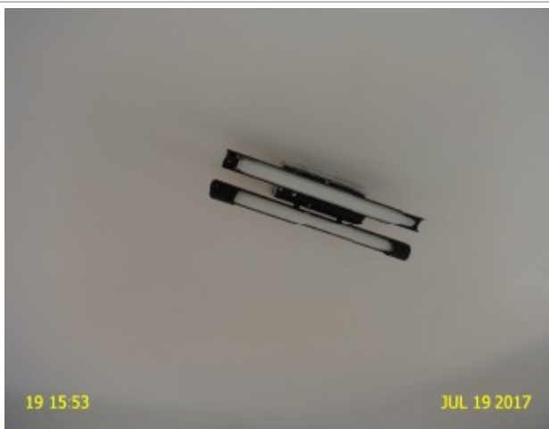
Foto 20 – Laboratório (Mangabeira): lâmpadas sem funcionar.
