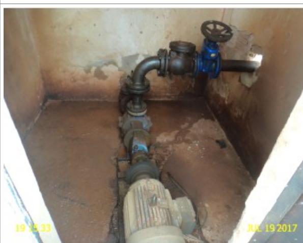
Foto 12 – EEAB-01(Mangabeira): ausência de bomba reserva e pintura deteriorada.
