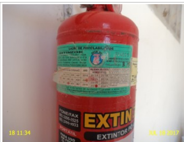
Foto 30 – EEAT-01 e EELF-01 (Quitaiús): extintor com carga vencida.
