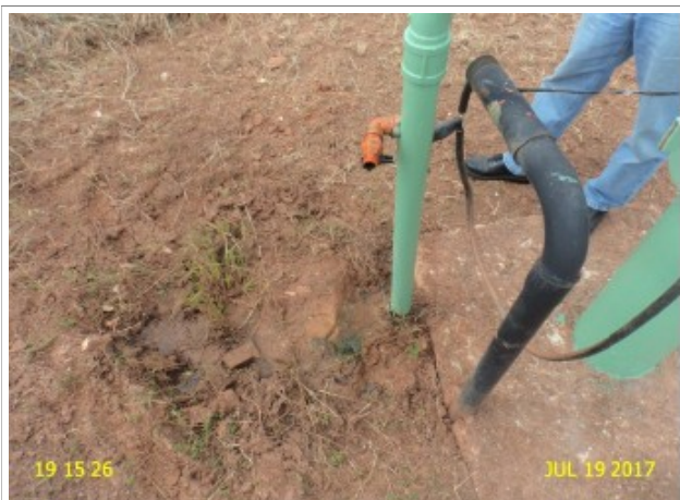
Foto 23 – PT-06 (Mangabeira): vazamento no ponto de água.
