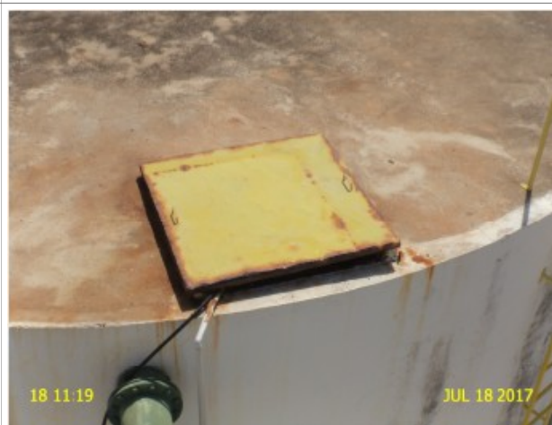
Foto 32 – RAP-01 (Quitaiús): tampa de inspeção inadequada, em processo de corrosão.
