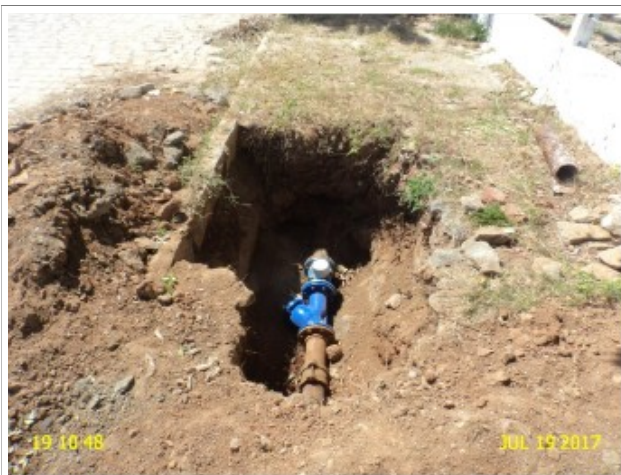
Foto 35 – AAB (Amaniotuba): medidor sem caixa.
