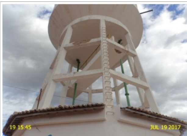
Foto 3 – REL-01 (Mangabeira): ausência de guarda-corpos na escada.
