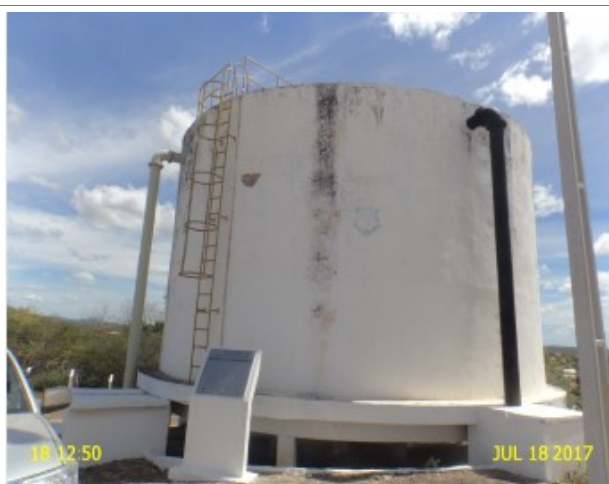
Foto 24 – REL-02 (Sede): pintura deteriorada e ausência de identificação.
