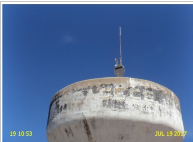
Foto 41 – REL-01 (Amanituba): ausência de identificação.
