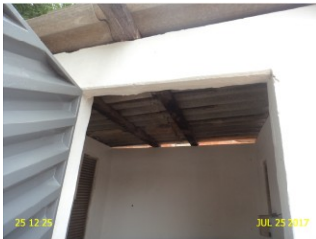
Foto 2 – EEAT-02 Booster : ausência de iluminação.
