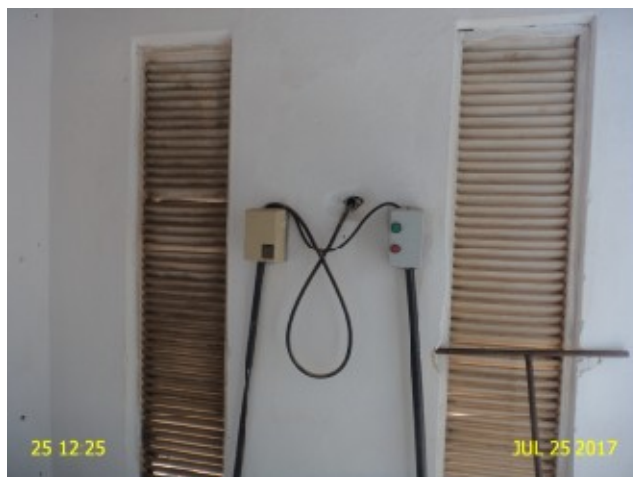
Foto 1 – EEAT-02 Booster : ausência de horímetro.
