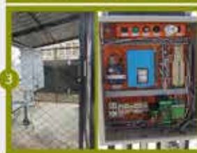
Foto 3 - Unidade de Transmissão Remota (UTR), localizada na ETC.
