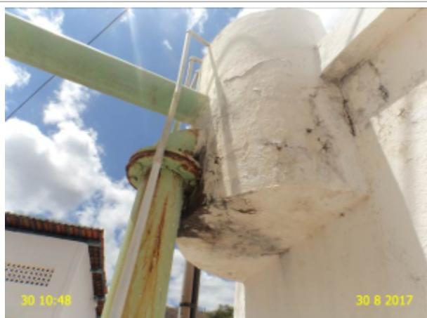
**Foto 22** - RAP-01 (Pereiro): sinais de vazamento na entrada de água.
