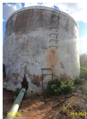
**Foto 21** – RAP-02: sem identificação, pintura deteriorada, escada danificada, ausência de para-raios e ausência de dispositivo de controle de nível.
