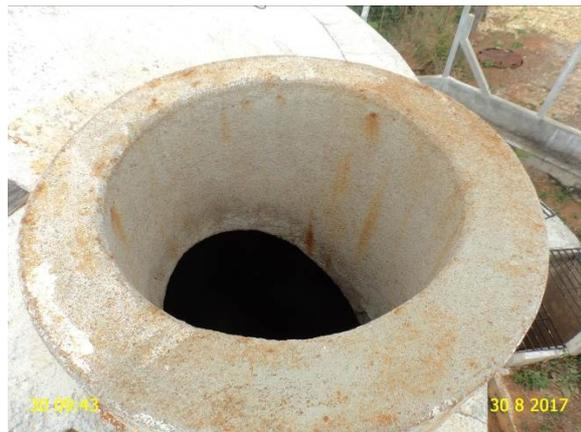
**Foto 13** - RAP-02 (Pereiro): ausência de tampa de inspeção.
