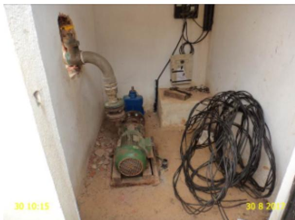
**Foto 1** - EEAB-01: ausência de bomba reserva e instalações elétricas inadequadas.
