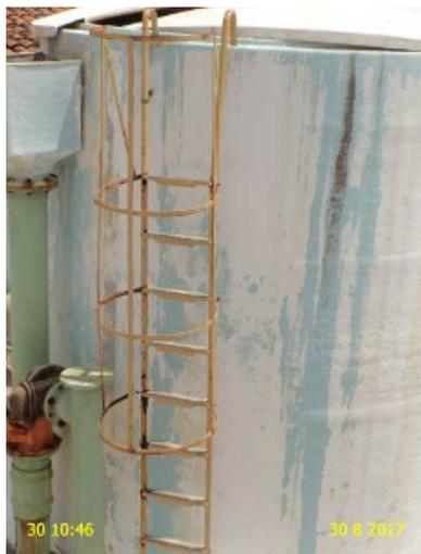
**Foto 24** – F-01: escada de acesso em processo de corrosão.
