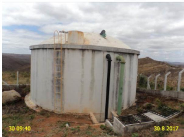
**Foto 26** - RAP-02 (Pereiro): pintura deteriorada e ausência de identificação.
