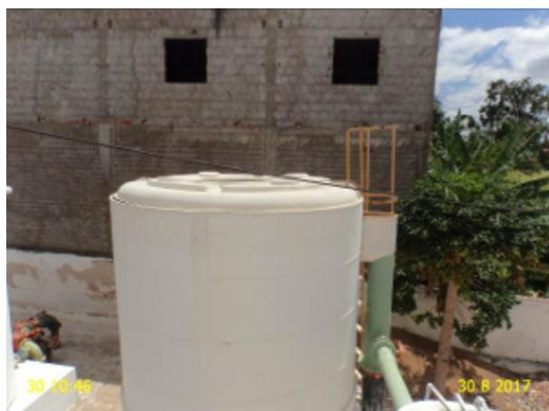
**Foto 11** - F-02: ausência de identificação, calha de saída de água sem tampa e a tampa de inspeção sem vedação.
