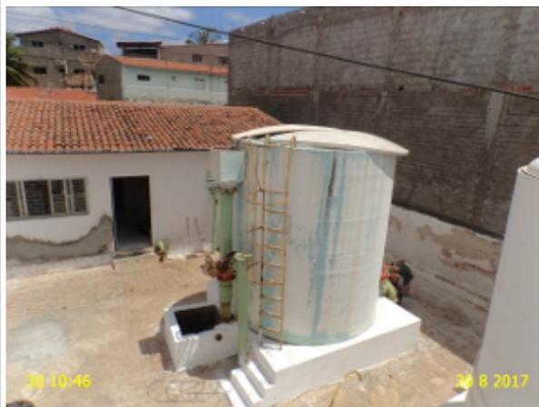
**Foto 10** – F-01: tampa de inspeção sem vedação e calha de saída de água sem tampa.
