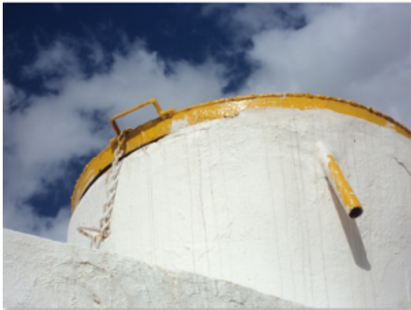
Foto 10 – RAP-02 (Sede): tampa sem vedação.
