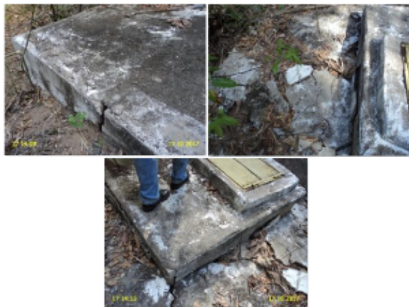
Foto 14 – RAP-01: laje com rachaduras.
