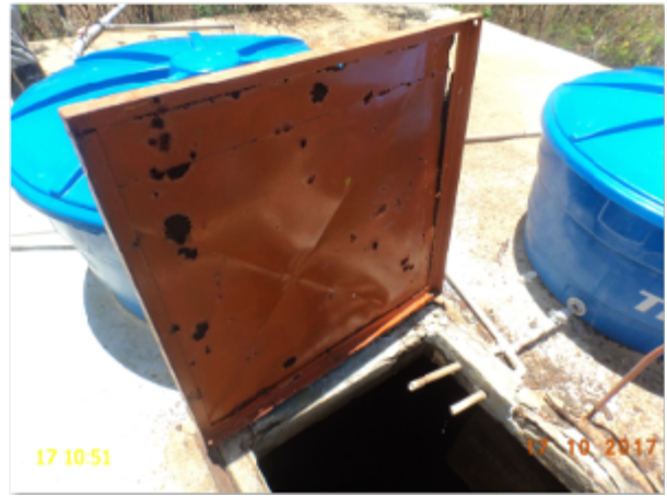
Foto 11 – RAP-03 (Brejo Grande): tampa de inspeção em processo de corrosão.
