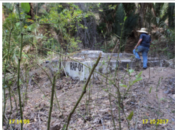
Foto 6 – RAP-01 (Sede): pintura deteriorada.
