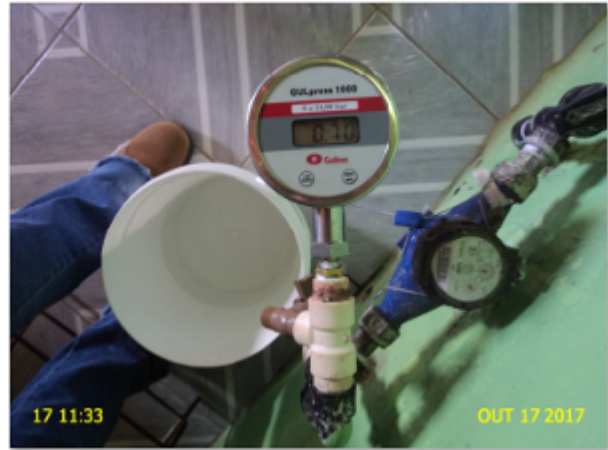
Foto 3 – RDA: medição instantânea de pressão na Rua São José, nº 60.
