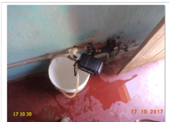
Foto 1 – RDA: datalogger instalado na Rua São Pedro, FNS 91, Brejo Grande, Santana do Cariri.
