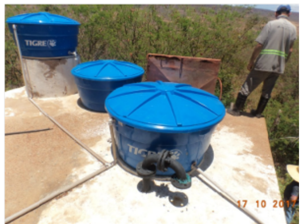
Foto 11 – RAP-03 (Brejo Grande): tampa de inspeção em processo de corrosão.
