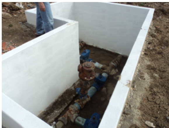
Foto 9 – AAT (Sede): caixa de inspeção sem tampa ou grade.
