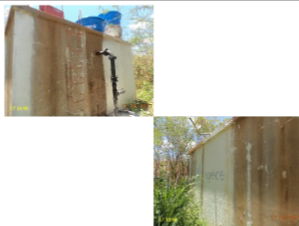
Foto 7 – RAP-03 (Brejo Grande): pintura deteriorada e ausência de identificação.
