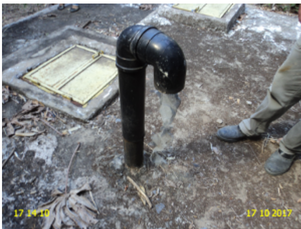
Foto 12 – RAP-01 (Sede): tubulação de ventilação sem tela de proteção.
