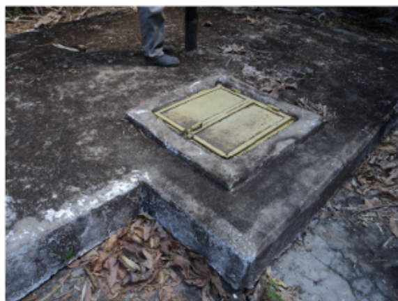
Foto 8 – Fonte Prata (Sede): ausência de identificação.
