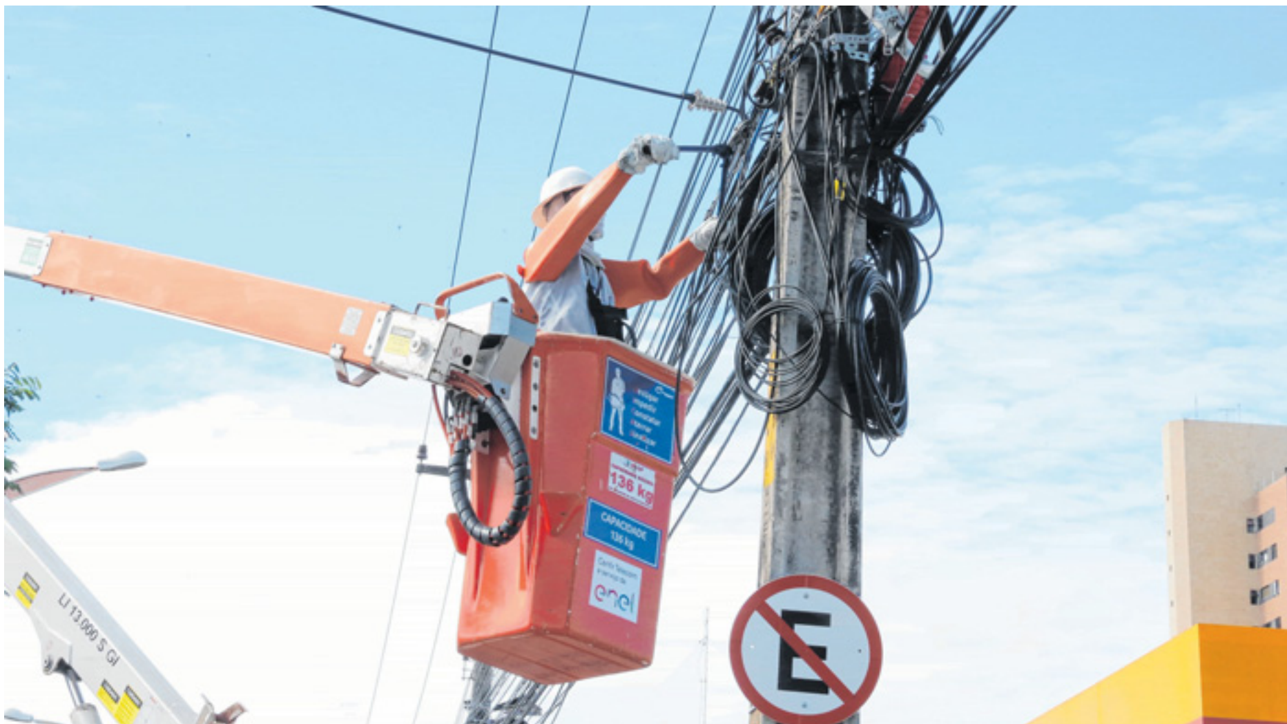
Falta de energia foi o principal motivo das reclamações feitas pelos consumidores no mês de dezembro, segundo relatório da Agência Reguladora do Ceará (Arce) FOTO: KID JÚNIOR
