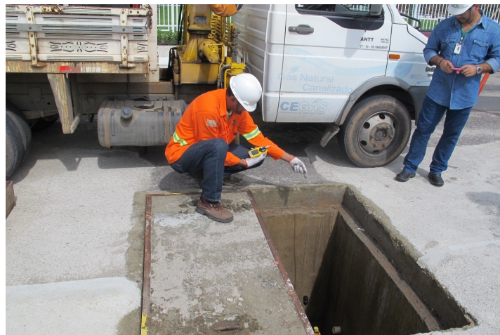
1-9h20 Medição de explosividade na caixa de válvula.
