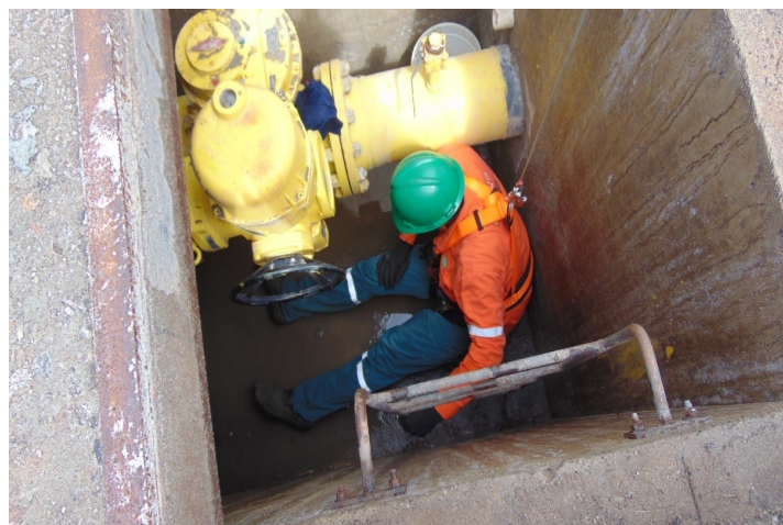
2- 09:35 Operador desmaiou enquanto realizava a atividade de limpeza da caixa.
