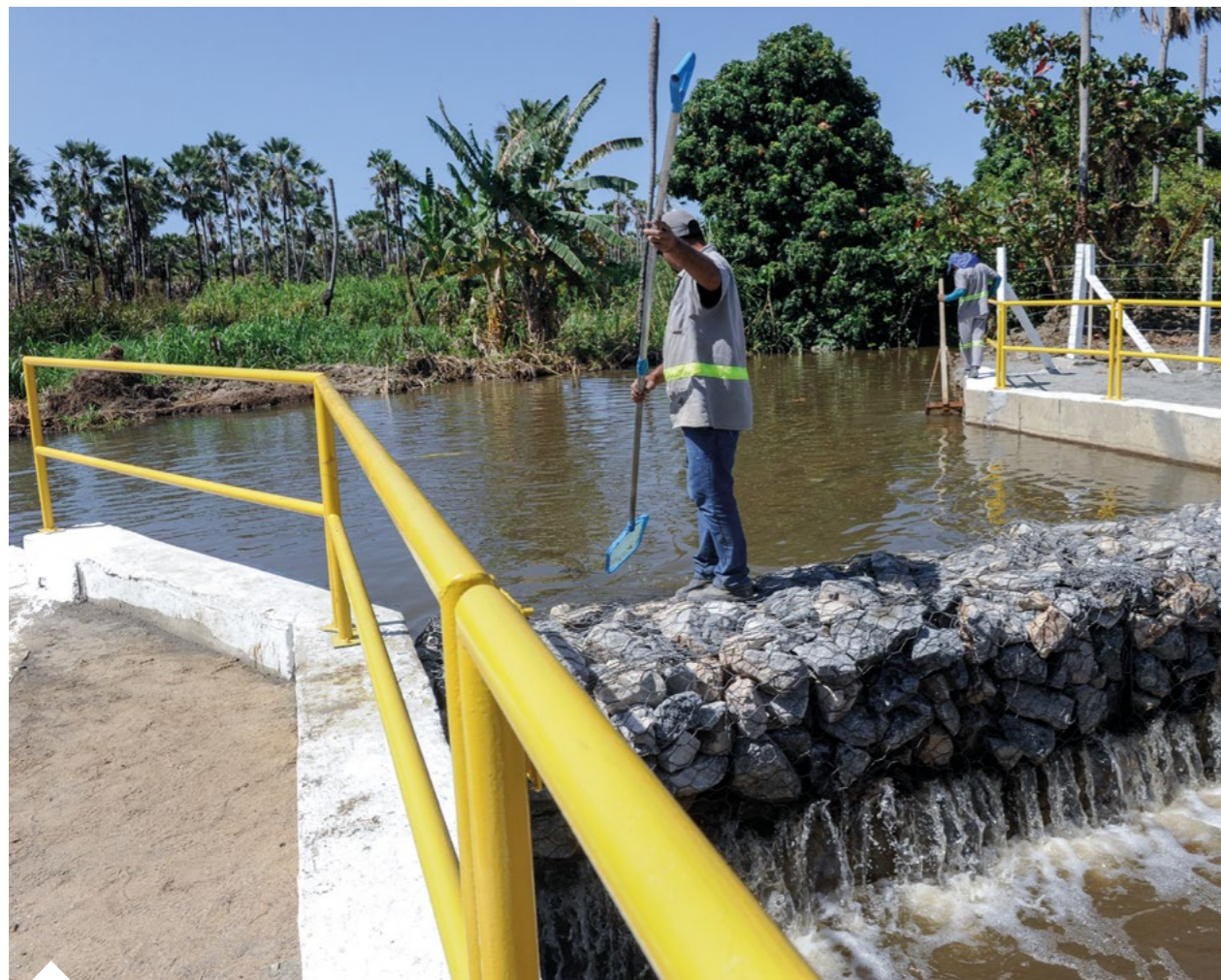
O sistema de recirculação da água após a lavagem dos filtros da Estação de Tratamento de Água (ETA) Gavião é uma das ações executadas pela Cagece, utilizando recursos apurados por meio da Tarifa de Contingência
