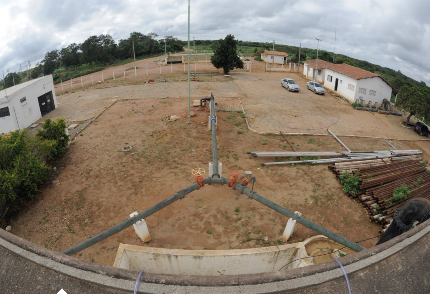
O poço localizado na cidade de Araripe possui mais de 900 metros de profundidade
