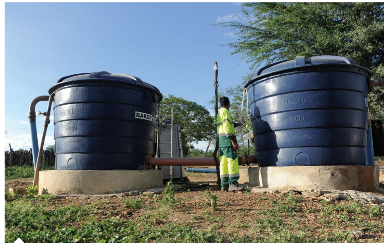
Por meio dos dois poços, a Cagece está conseguindo captar cerca de 100 m 3 /h para a cidade de Campos Sales
