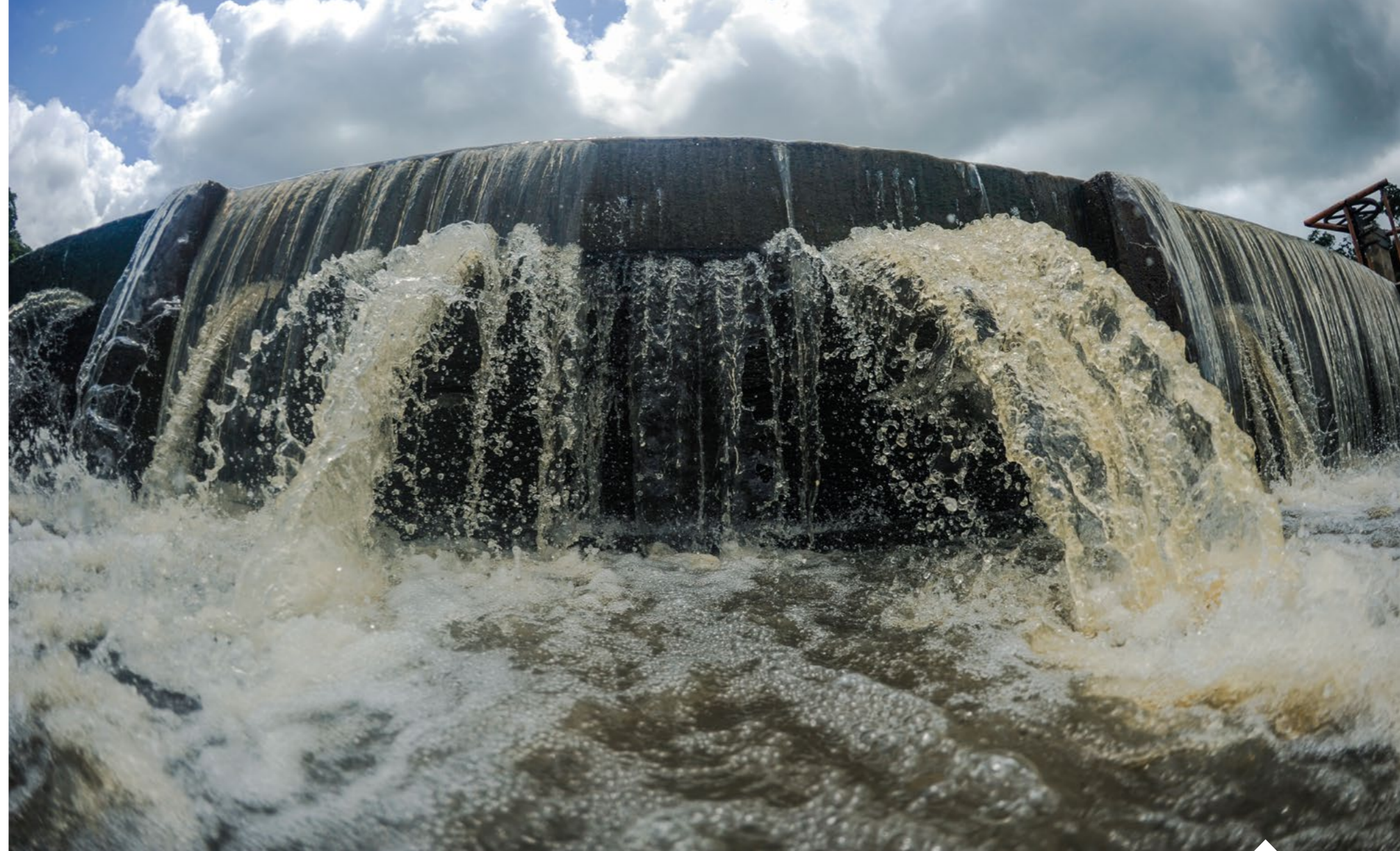
Sangradouro da barragem Tijuquinha, localizado no município de Baturité
