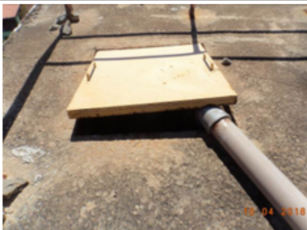
Foto 13 – REL-01: tampa sem vedação.
