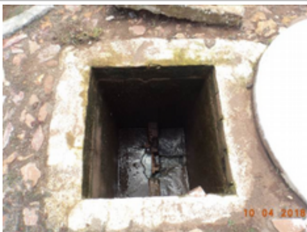
Foto 5 – ETE: caixa de inspeção/passagem sem tampa
