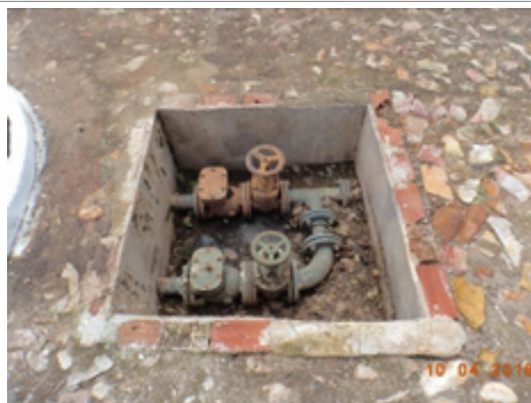
Foto 6 – ETE: caixa de inspeção/passagem sem tampa.
