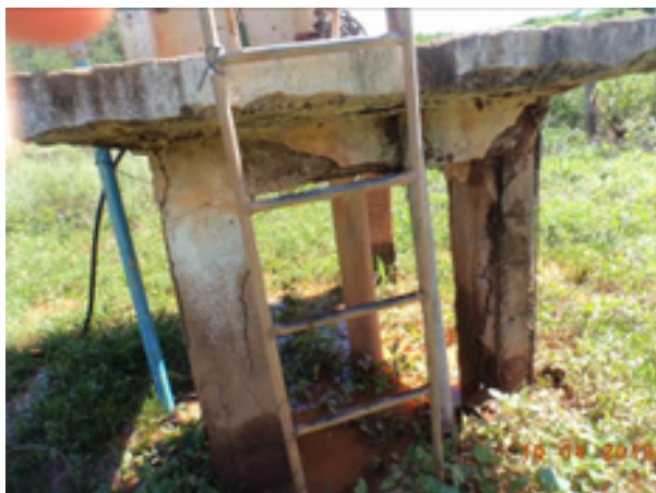
Foto 18 – PT-01: estrutura da laje de proteção e do quadro de comando com armaduras expostas.
