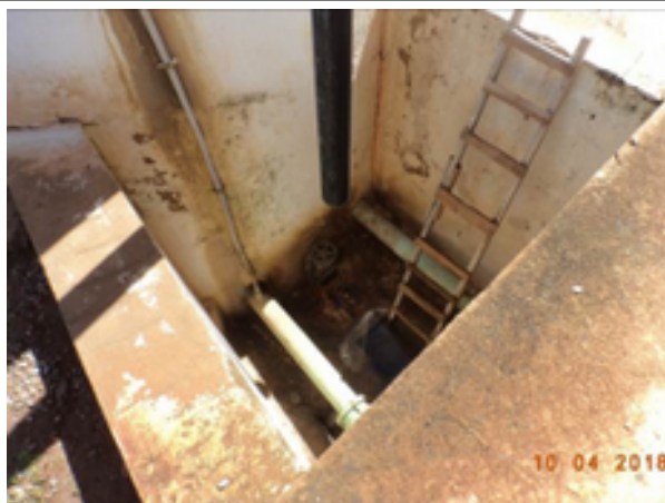
Foto 8 – RAP-01: caixa do registro e da descarga de fundo sem tampa.
