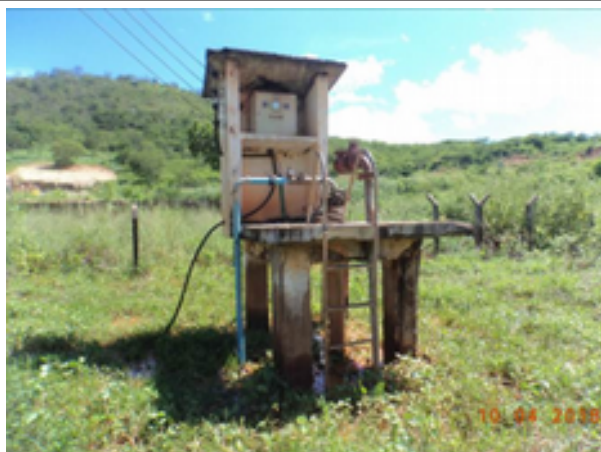
Foto 14 – PT-01: sem identificação e estrutura da laje de proteção e do quadro de comando danificada.
