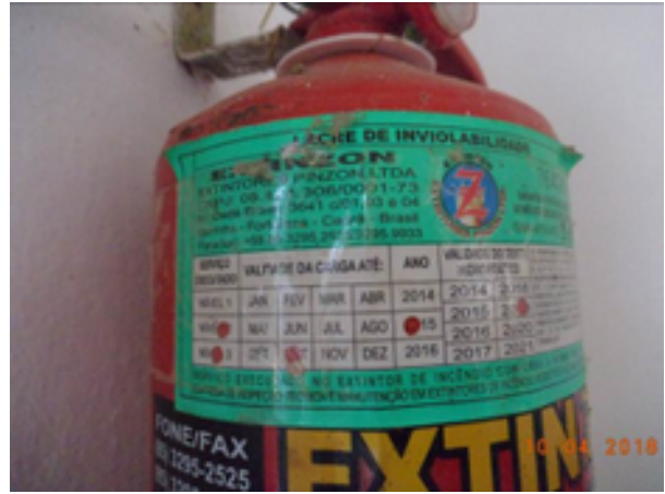
Foto 20 – EEAT-01: datas de validade da recarga e do teste hidrostático do cilindro vencidas.
