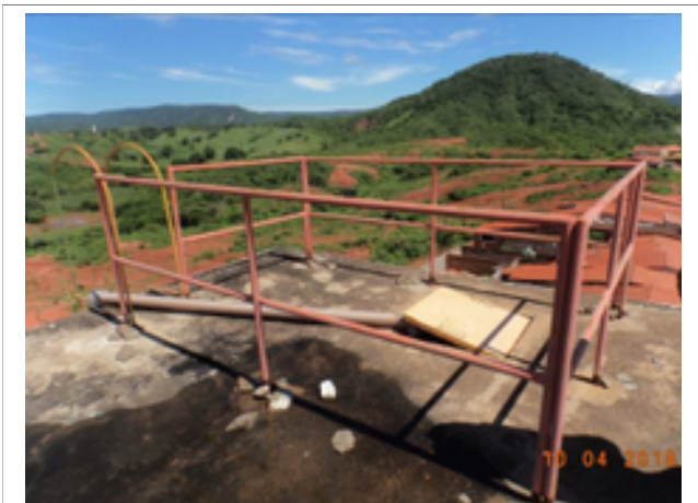
Foto 23 – REL-01: guarda-corpo não instalado em toda extensão da laje de cobertura do reservatório .
