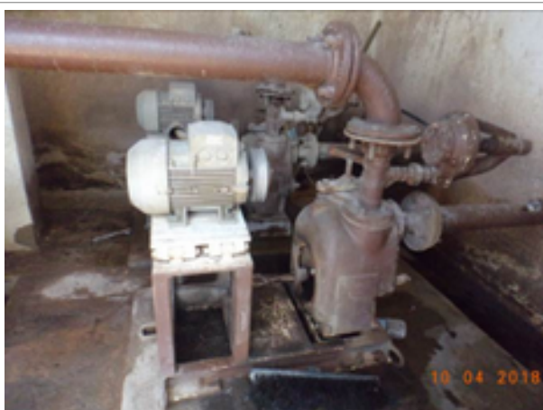
Foto 1 – EEE-01: apenas uma bomba instalada.
