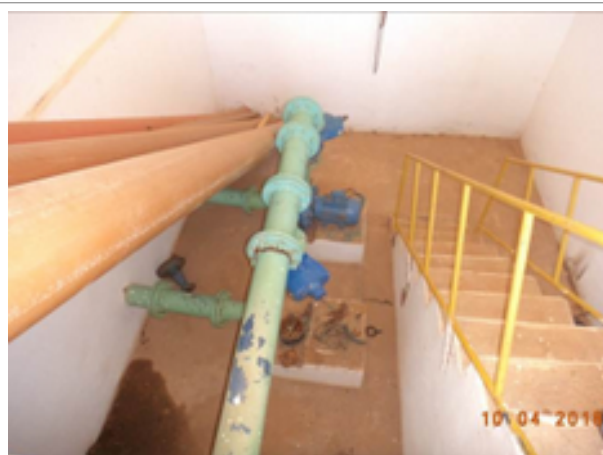
Foto 2 – EEAT-01: apenas uma bomba instalada.
