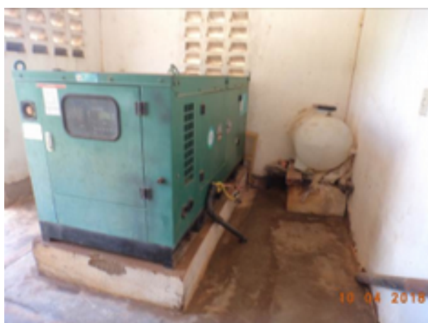
Foto 11 – EEE-01: grupo gerador de energia não instalado.
