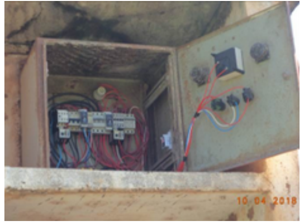
Foto 4 – Captação: quadro de comando dos poços PT-01 e PT-02 sem horímetro instalado.
