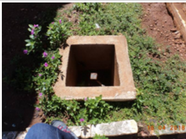
Foto 7 – RAP-01: caixa de inspeção sem tampa.
