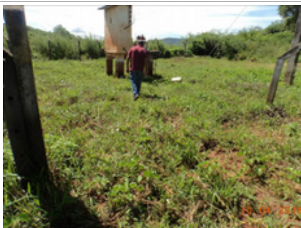
Foto 10 – Captação: cerca de delimitação da área dos poços PT-01 e PT-02 danificada. Ausência de placa indicando que a área é destinada ao abastecimento público.
