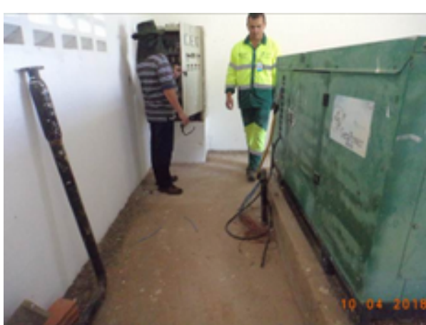
Foto 12 – EEE-02: grupo gerador de energia elétrica não instalado.
