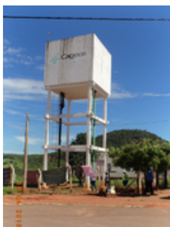
Foto 17 – REL-01: pintura deteriorada.
