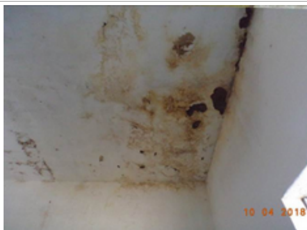
Foto 9 – EEAT-01: sinais de infiltração no teto.
