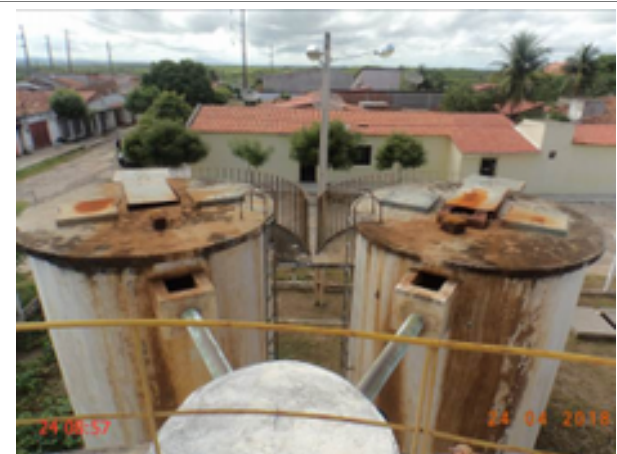
Foto 6 – ETA/Filtração: F-01 e F-02 estão com pintura deteriorada, Tampas de inspeção com corrosão e sem vedação e as calhas de saída de água sem tampa.
