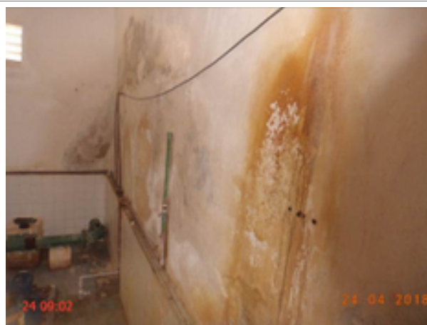
Foto 37 – EEAT-01: pintura deteriorada e sinais de infiltração na parede.
