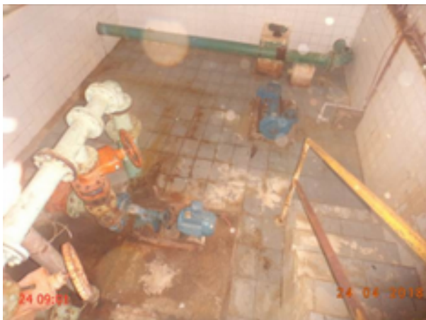
Foto 7 – EEAT-01: apenas uma bomba instalada.
