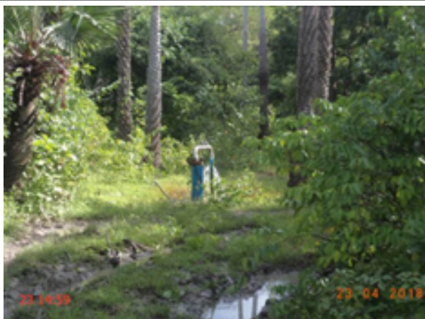
Foto 1 – PT-07: Área sem iluminação/Vazamento na tubulação do poço.
