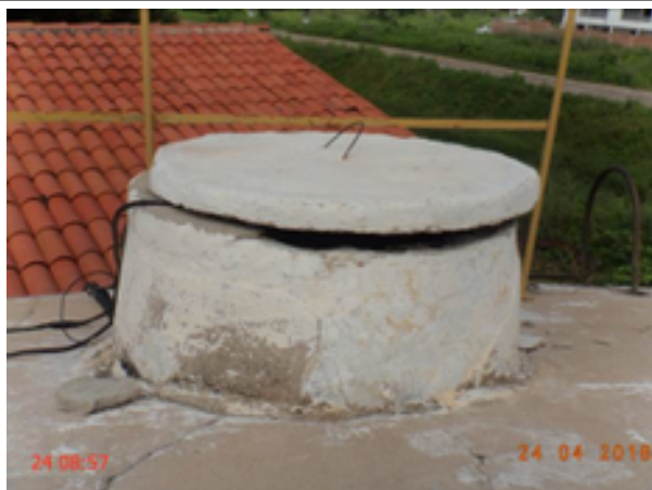
Foto 9 – RAP-01: tampa de inspeção sem vedação.
