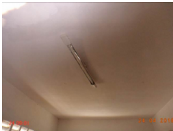
Foto 33 – EEAT-01: lâmpada não acende.
