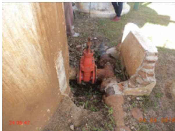
Foto 31 – F-01: caixa do registro do filtro danificada.
