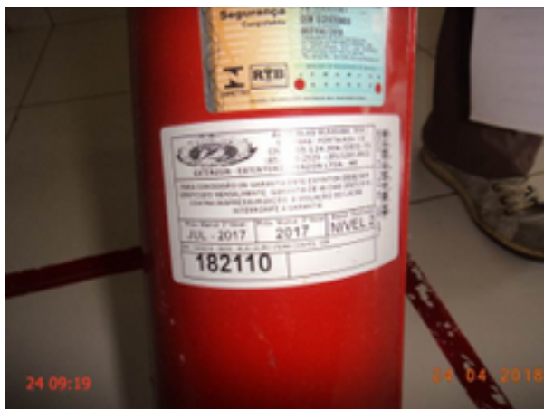
Foto 13 – Escritório: extintor de incêndio com datas da validade da recarga e do teste hidrostático vencidas.
