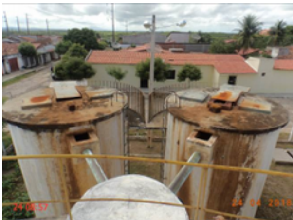
Foto 30 – ETA/Filtração: F-01 e F-02 calha de saída de água sem tampa/Pintura deteriorada/Tampas de inspeção em corrosão e sem vedação.
