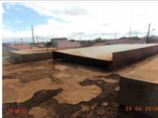
Foto 29 – F-02: tampa de inspeção em processo de corrosão e sem vedação.
