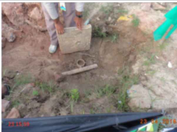
Foto 8 – RDA: registro de descarga instalado sem caixa e tampa de proteção na Rua Sebastião Miranda, Próximo ao Posto Leão.
