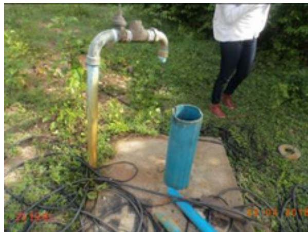
Foto 15 – PT-08: Área sem iluminação e sem bomba.
