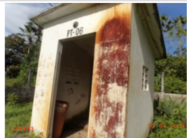
Foto 4 – PT-06: casa de abrigo do QC sem lâmpada instalada/Pintura da casa de abrigo deteriorada.
