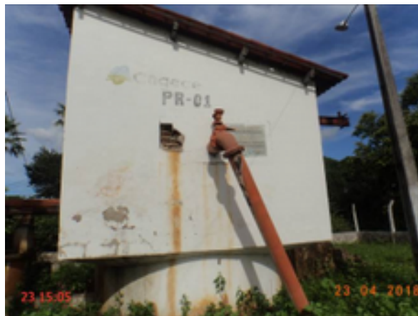
Foto 21 – PR-01: pintura e reboco deteriorados.
