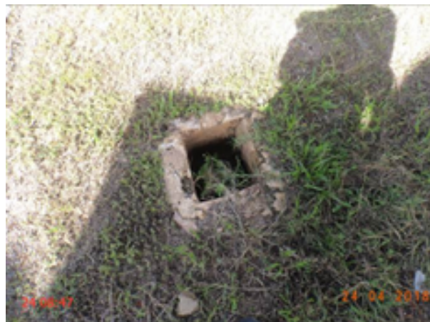
Foto 27 – ETA: caixa de inspeção localizada próximo à torre de nível sem tampa ou grade de proteção.
