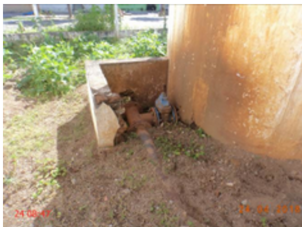
Foto 32 – F-02: caixa do registro do filtro danificada.
