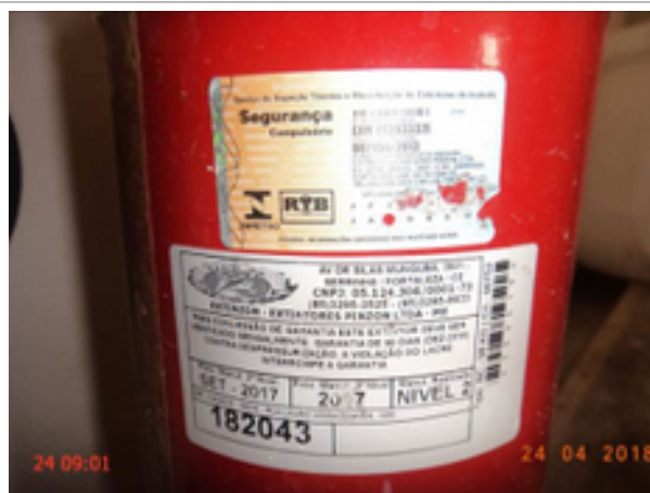
Foto 23 – EEAT-01: extintor de incêndio com datas de validade da recarga e do teste hidrostático vencidas.
