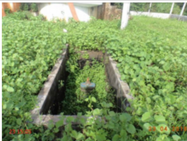
Foto 11 - AAB: caixa de inspeção sem tampa ou grade de proteção.
