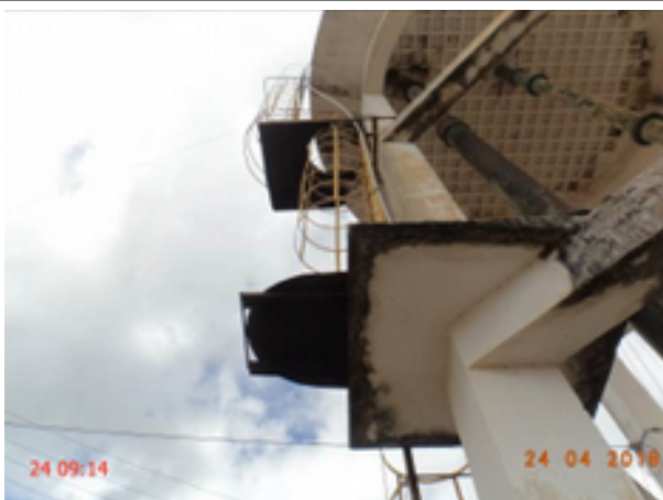
Foto 18 – REL-01: escada em processo de corrosão.
