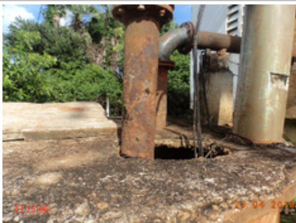
Foto 5 – PR-01: laje de cobertura danificada.
