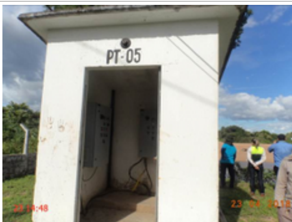
Foto 3 – PT-05: casa de abrigo do QC sem lâmpada instalada.
