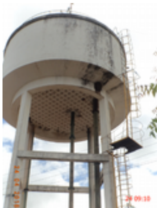
Foto 20 – REL-01: pintura deteriorada
