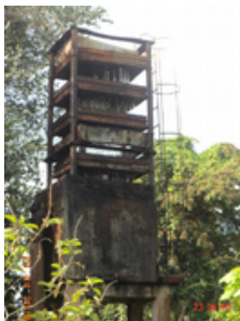
Foto 12 – Aerador: pintura deteriorada, bandejas e escada de acesso em processo de corrosão.
