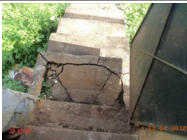
Foto 36 – EEAB-01: escada de acesso da casa de abrigo do QC com degrau danificado.
