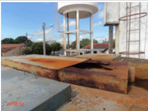
Foto 28 – F-01: tampa de inspeção em processo de corrosão e sem vedação.
