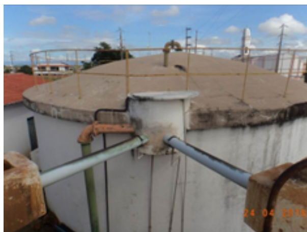
Foto 19 – RAP-01: pintura deteriorada.
