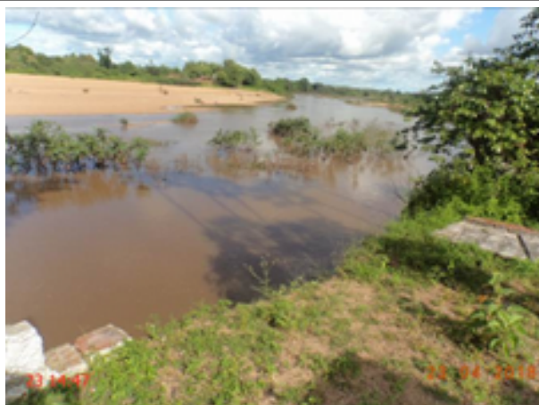
Foto - 38 – PT-05: muro danificado.
