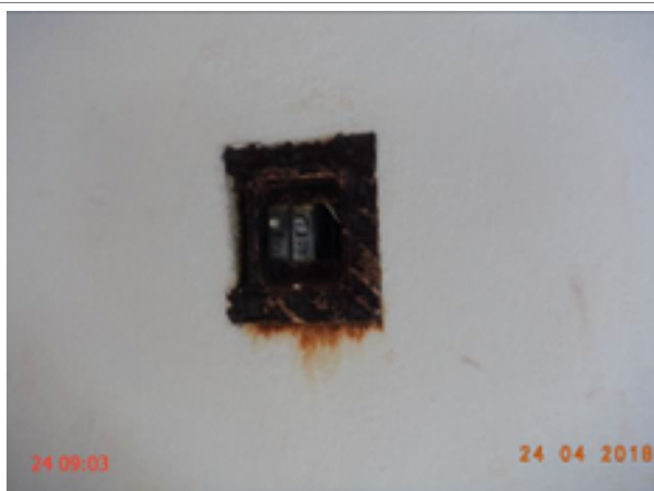
Foto 24 – ETA/Casa de Química: quadro dos disjuntores sem tampa.
