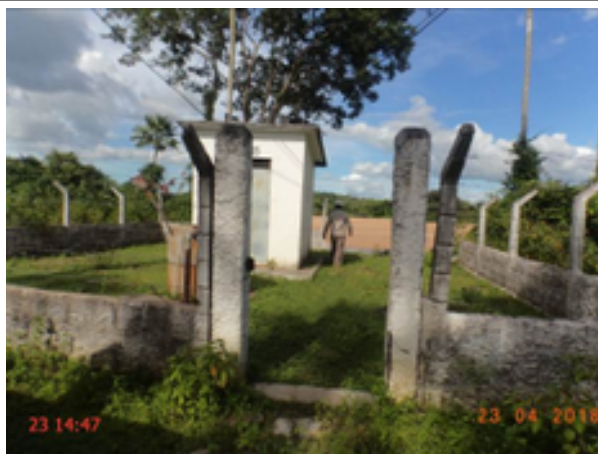
Foto 39 – PT-05: área de delimitação sem portão.
