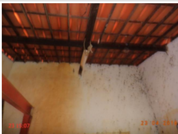
Foto 34 – EEAB-01: lâmpada da casa de abrigo do quadro de comando não acende.
