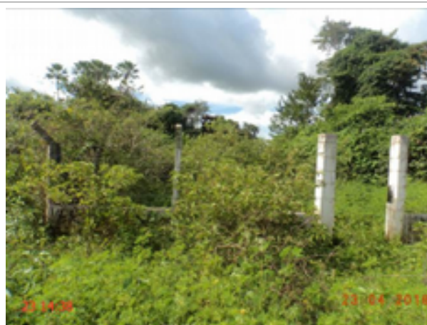
Foto 35 – Aerador: vegetação excessiva e ausência de portão na área de delimitação.
