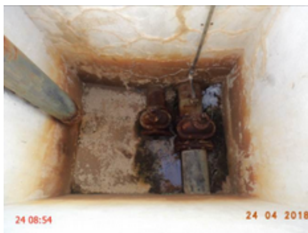
Foto 17 – RAP-01: registro sem vedação.
