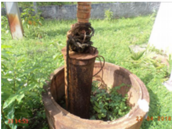
Foto 14 – PT-06: proteção em processo de corrosão.
