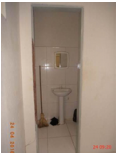
Foto 40 – Loja de atendimento da Cagece: banheiro sem porta.
