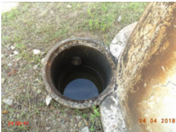
Foto 26 – ETA: caixa da descarga de fundo da torre de nível sem tampa ou grade de proteção.
